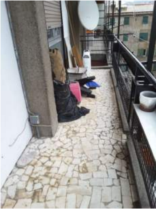
Balcone lato est
