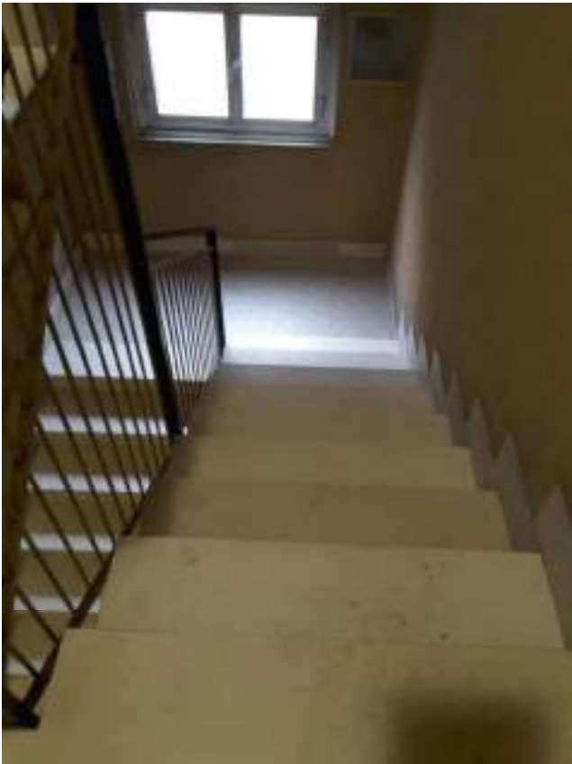
Vano scala C
