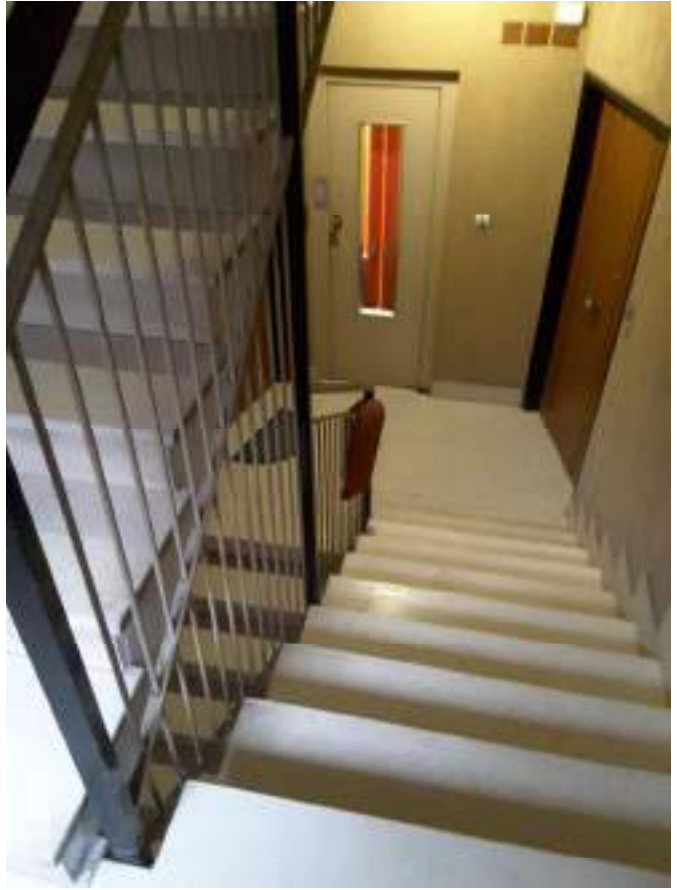
Vano scala C
