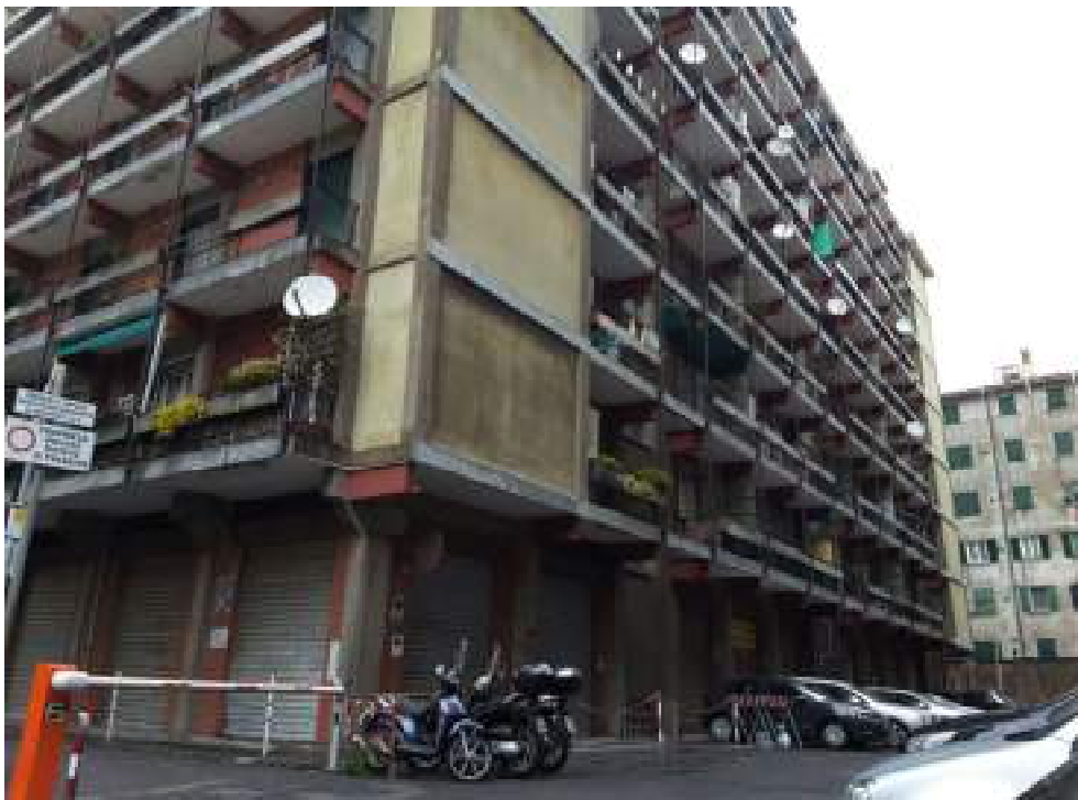
Condominio via Carlo Orgiero n.6, prospetto est
