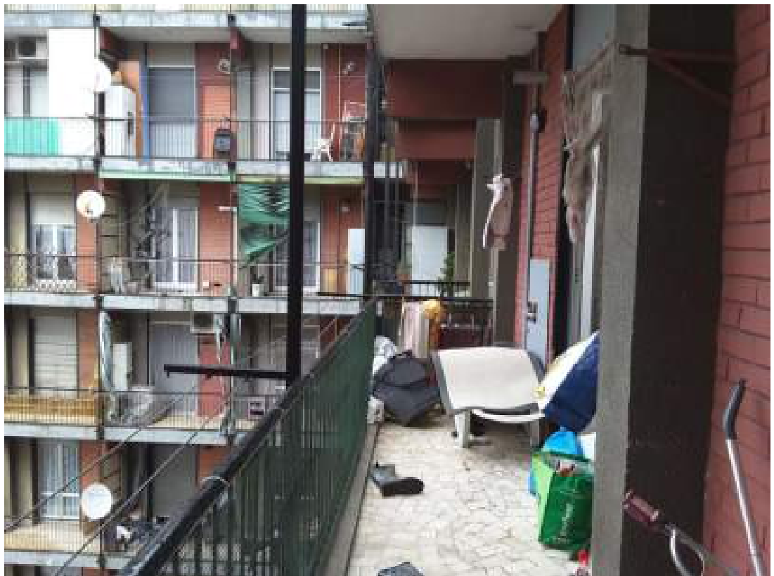
Balcone lato ovest
