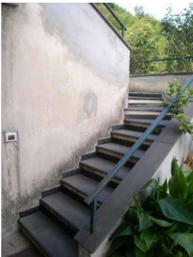
Foto 12 – Scala di accesso al piano
