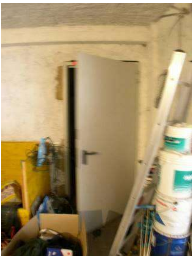
Foto 46 e 47 – Vista interna del magazzino 2
