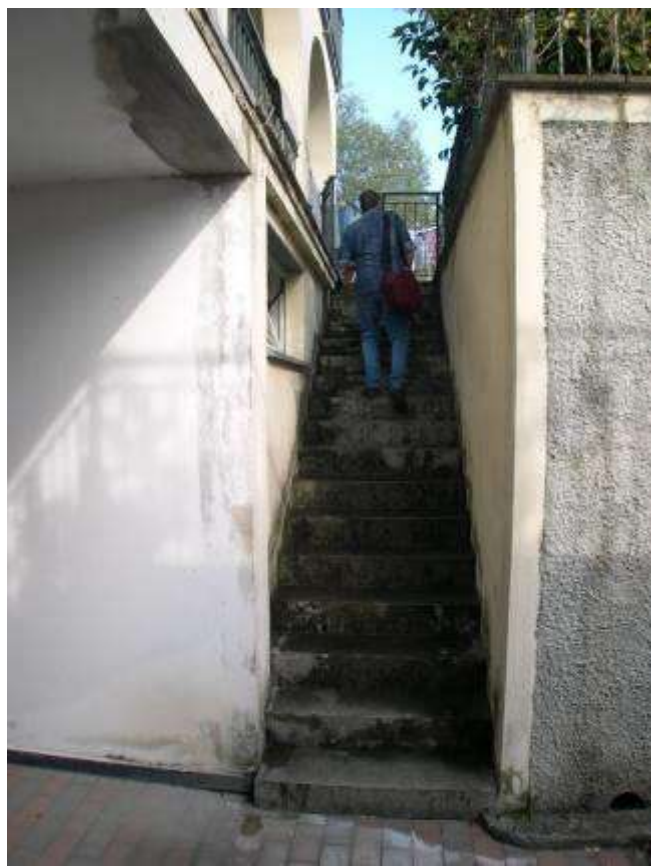
Foto 41– Vista della scala pedonale dal piano interrato al piano di campagna
