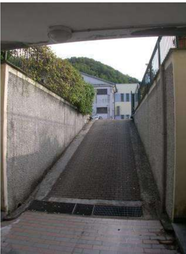
Foto 40 – Vista della rampa carraia
