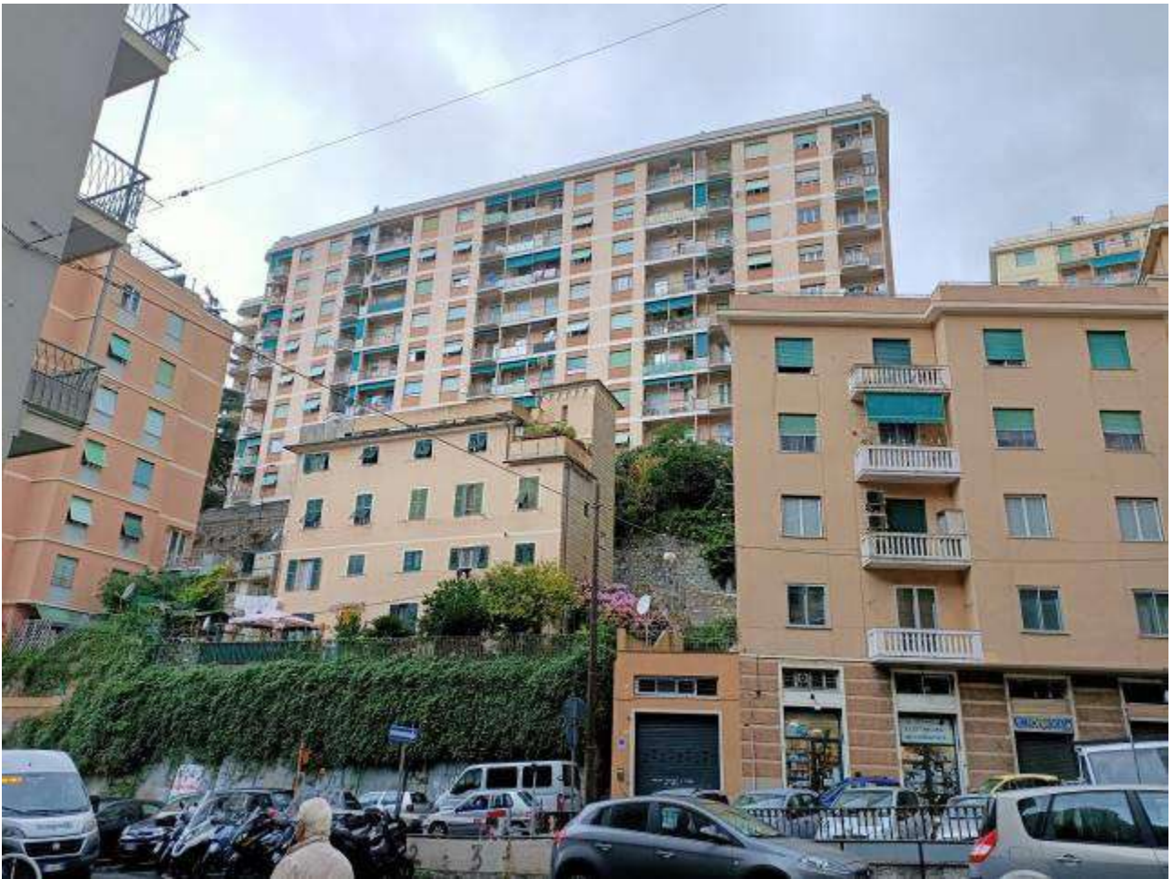
Foto 9 – Vista del caseggiato da Via Fereggiano
