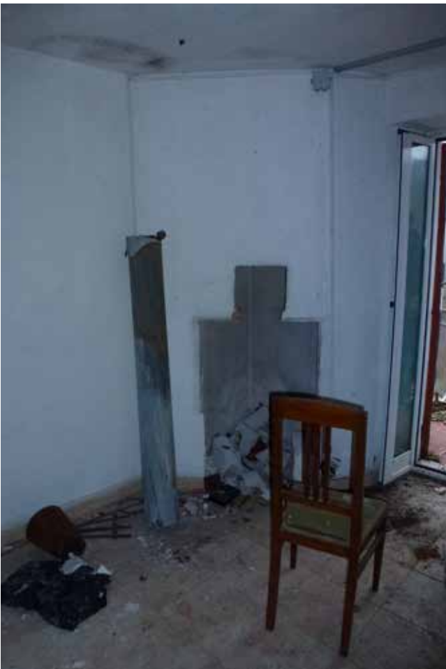
Foto 26 - Vista della predisposizione del camino sull'angolo nordovest
