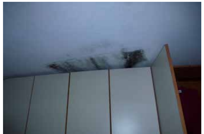
Foto 27 e 28 - Vista delle perdite a soffitto
