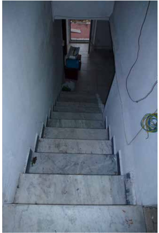
Foto 18- Vista della scala di collegamento fra primo e secondo piano
