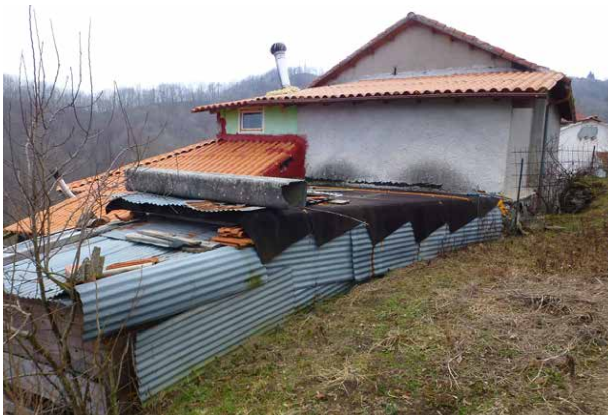
Foto 6 - Vista di porzione dell'immobile sul fronte ovest
