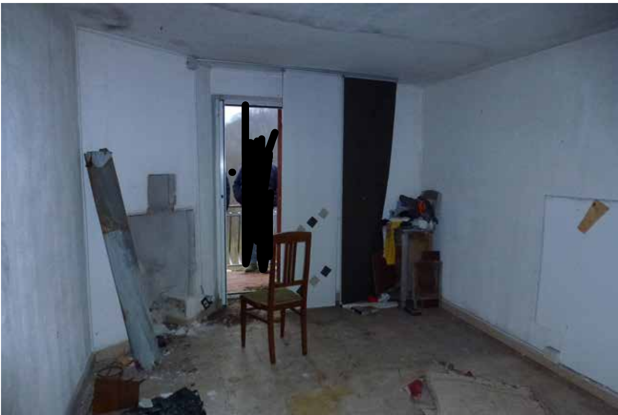
Foto 24 - Vista della finestra di accesso al vano ovest al secondo piano
