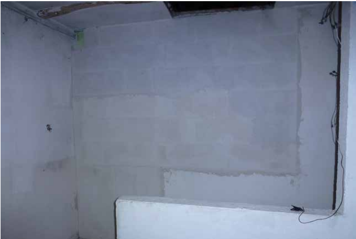
Foto 23 - Vista della chiusura dell'accesso al vano ovest al secondo piano
