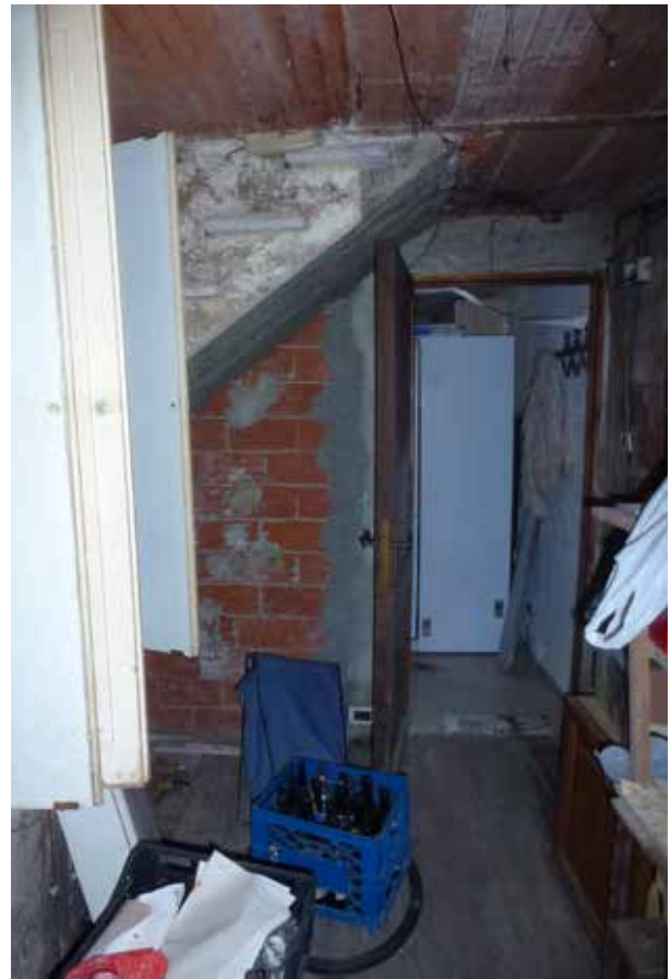
Foto 11 - Vista della dispensa verso l'ingresso
