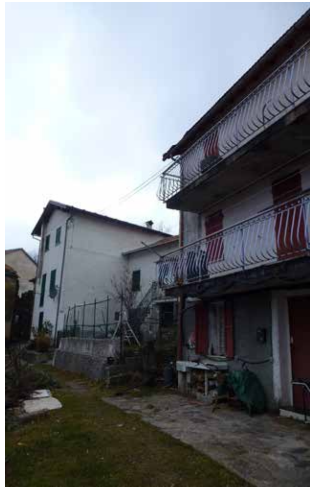
Foto 4- Vista dell'immobile dal fronte nord
