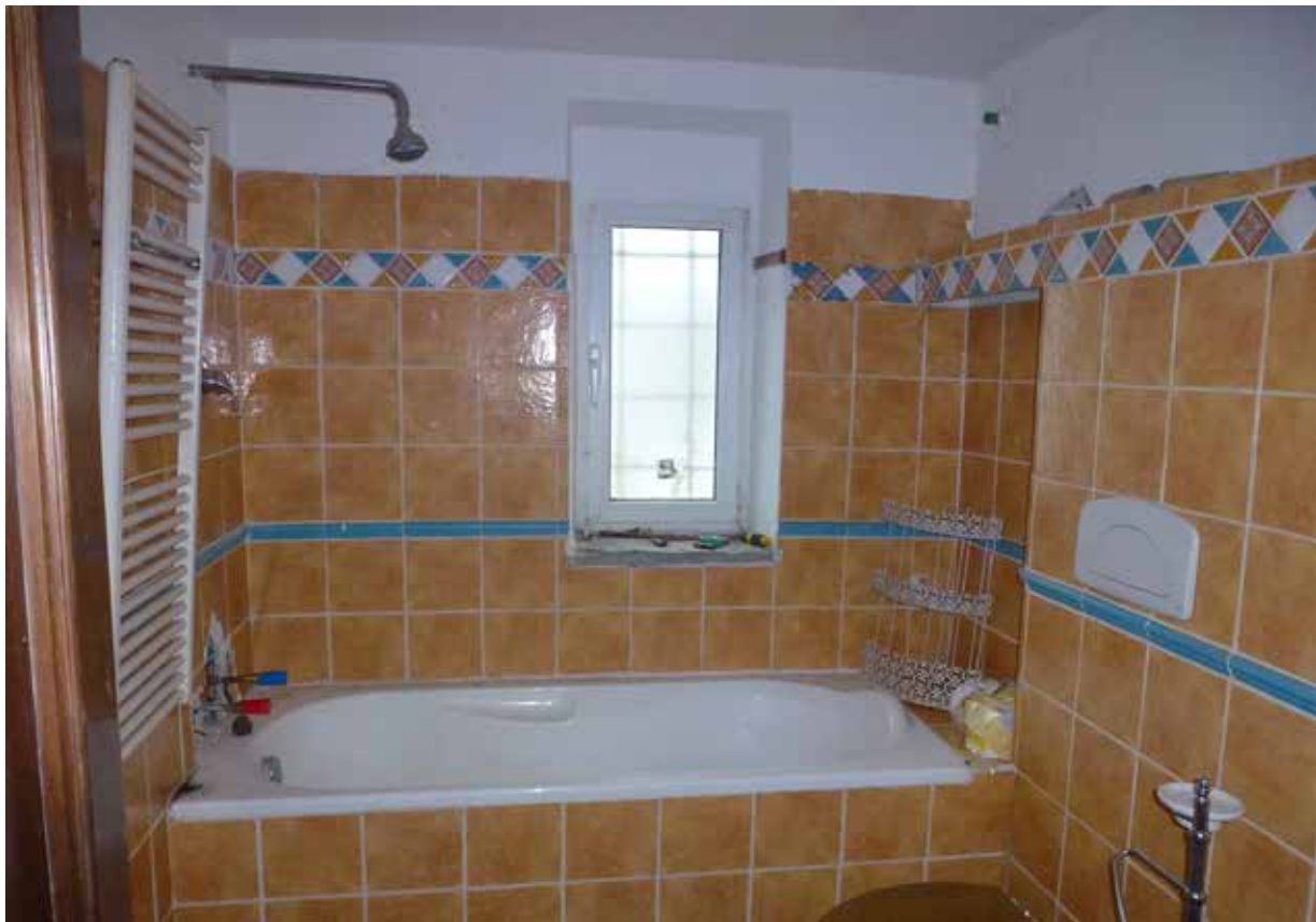
Foto 16 - Viste del bagno al primo piano
