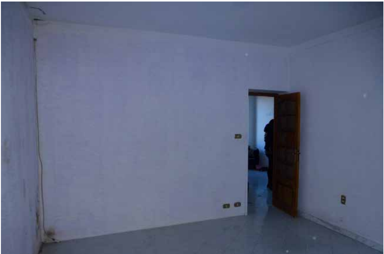
Foto 23 - Vista della camera sudovest verso la porta
