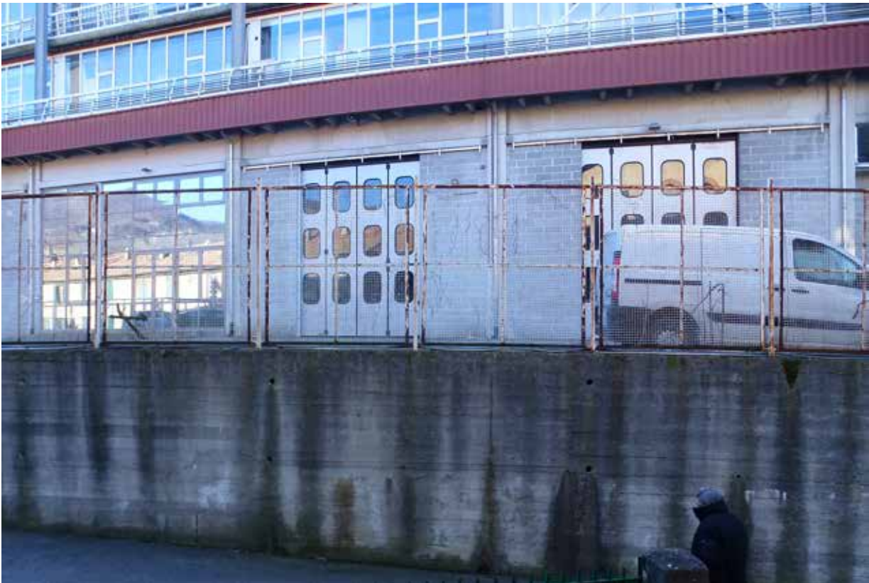
Foto 22 - Vista dalle camere sul fronte sud
