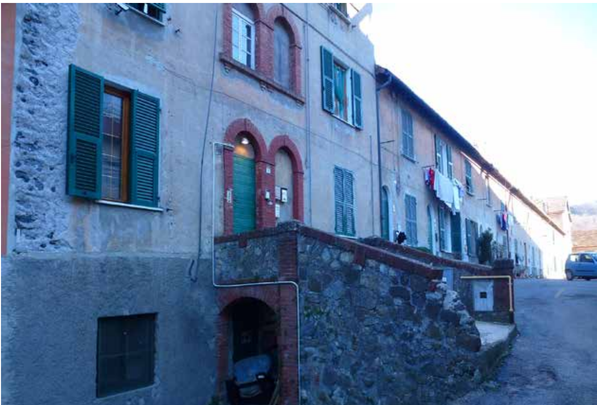
Foto 4 - Vista del civico 59 in corrispondenza dell'accesso
