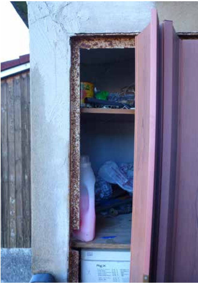
Foto 14 - Vista del ripostiglio esterno
