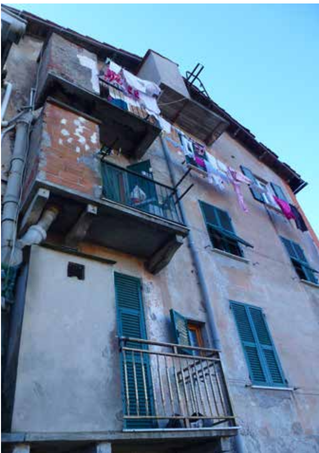
Foto 7 - Vista esterna del balcone dell'immobile
