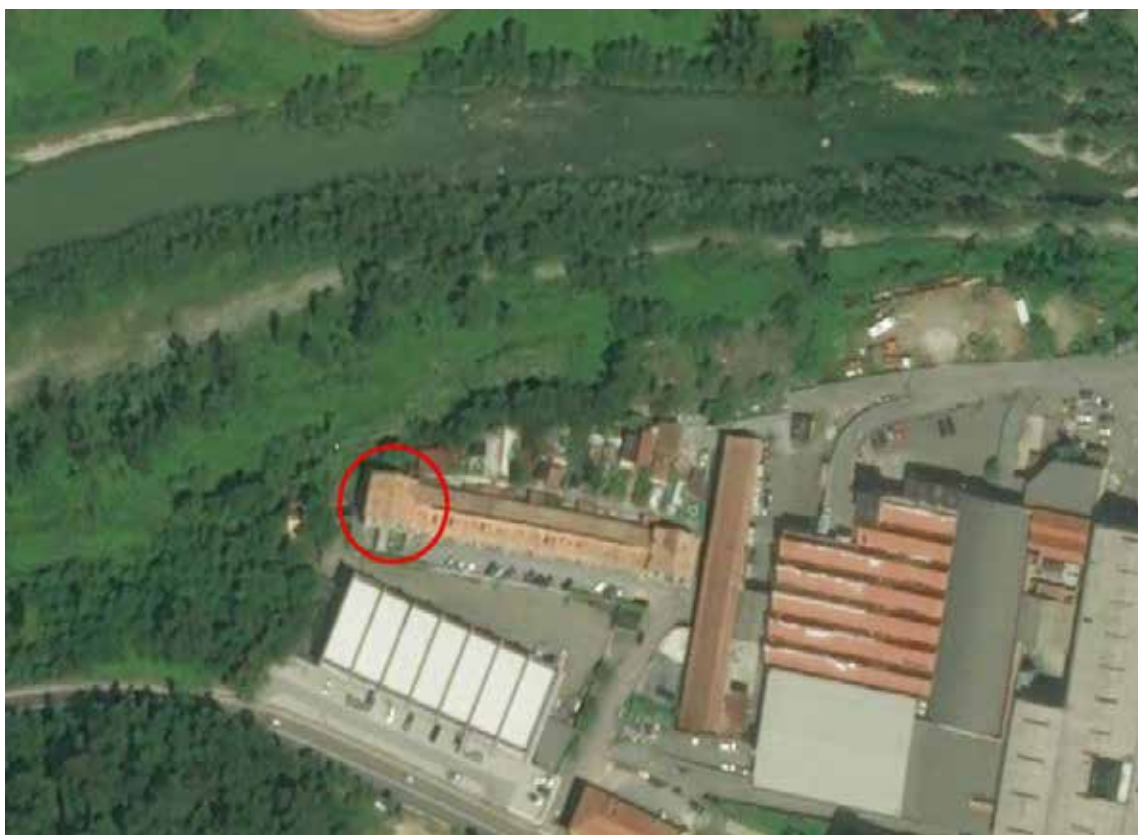
Foto 1 - Vista aerea del civico 59
