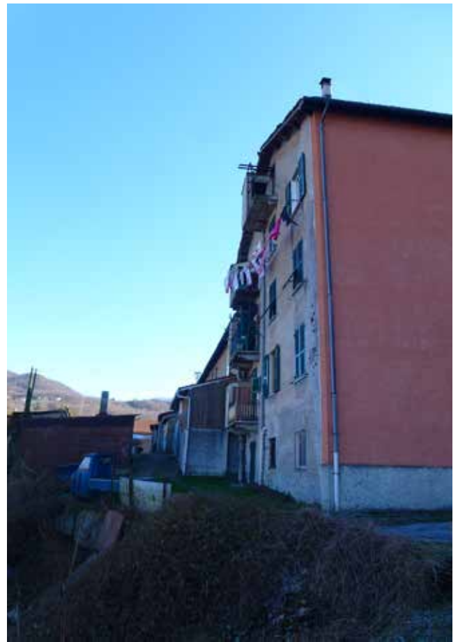
Foto 6 - Vista del fronte del civico 59 sul fiume
