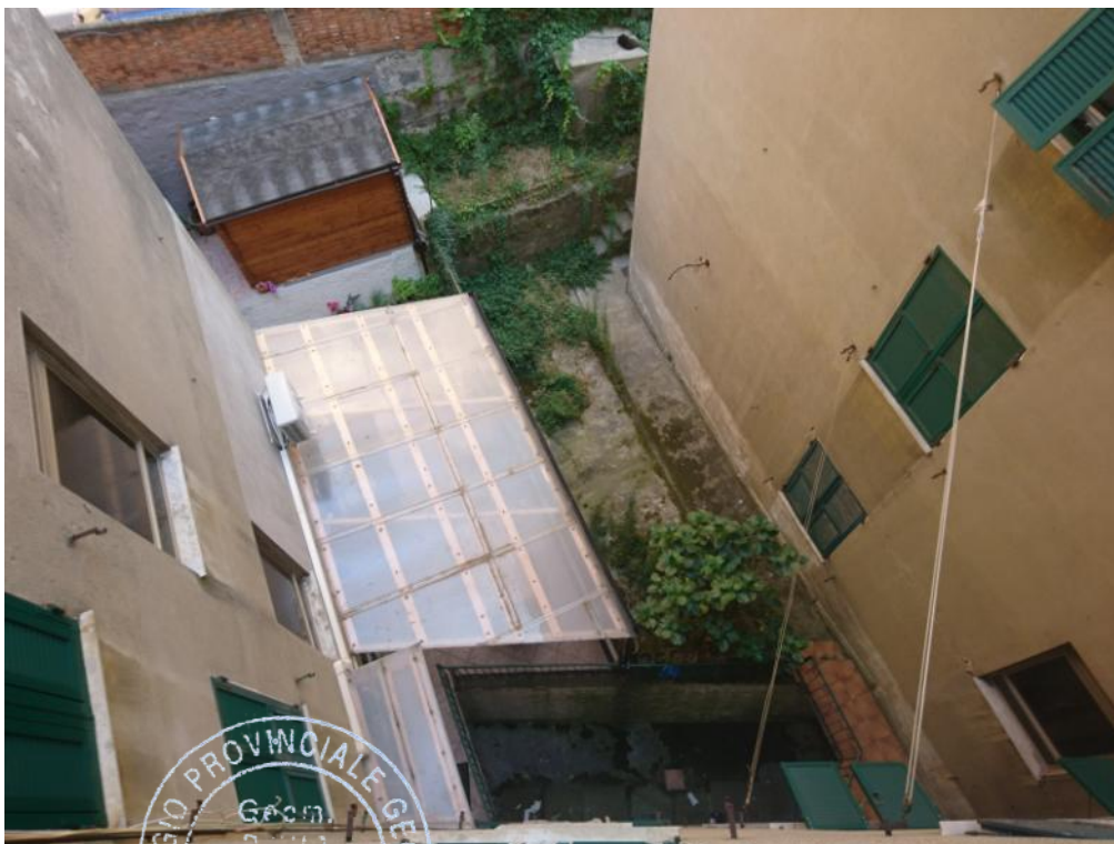
FOTO N°. 19: Vista su Cavedio
