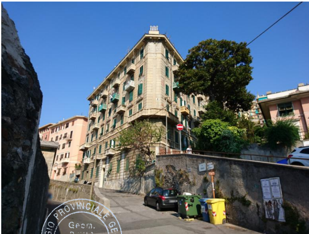
FOTO N°. 1: Prospetti Sud-Est
