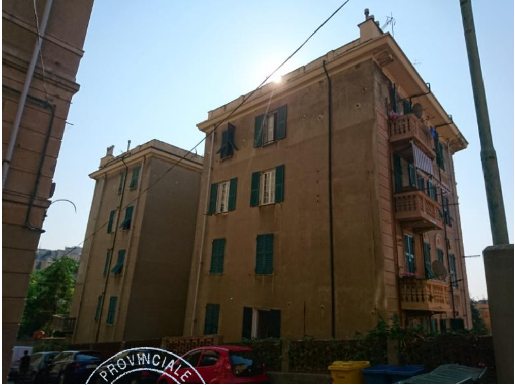
FOTO N°. 5: Prospetti Nord- Ovest
