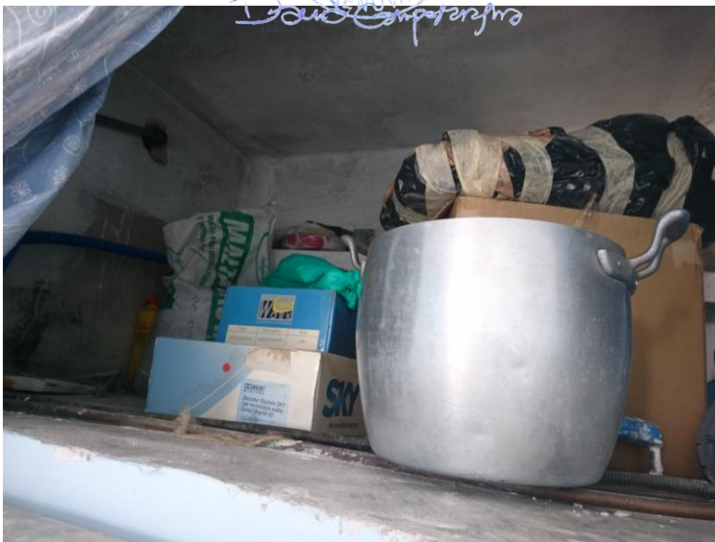
FOTO N°. 30: Soppalco
