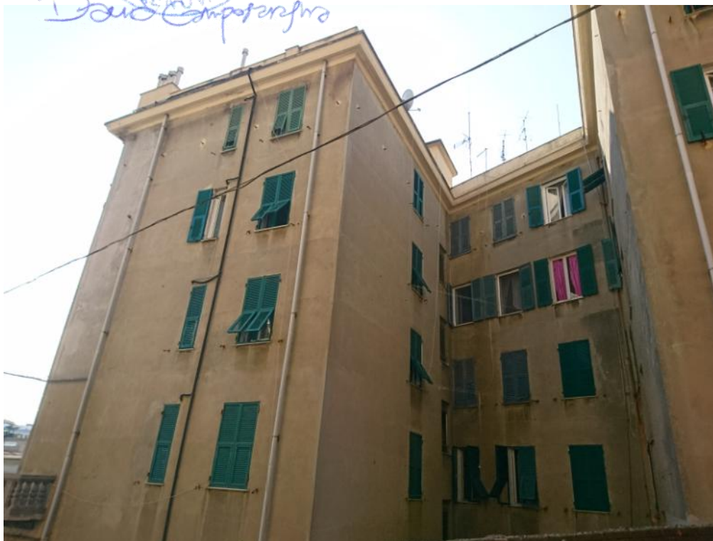
FOTO N°. 4: Prospetto Nord
