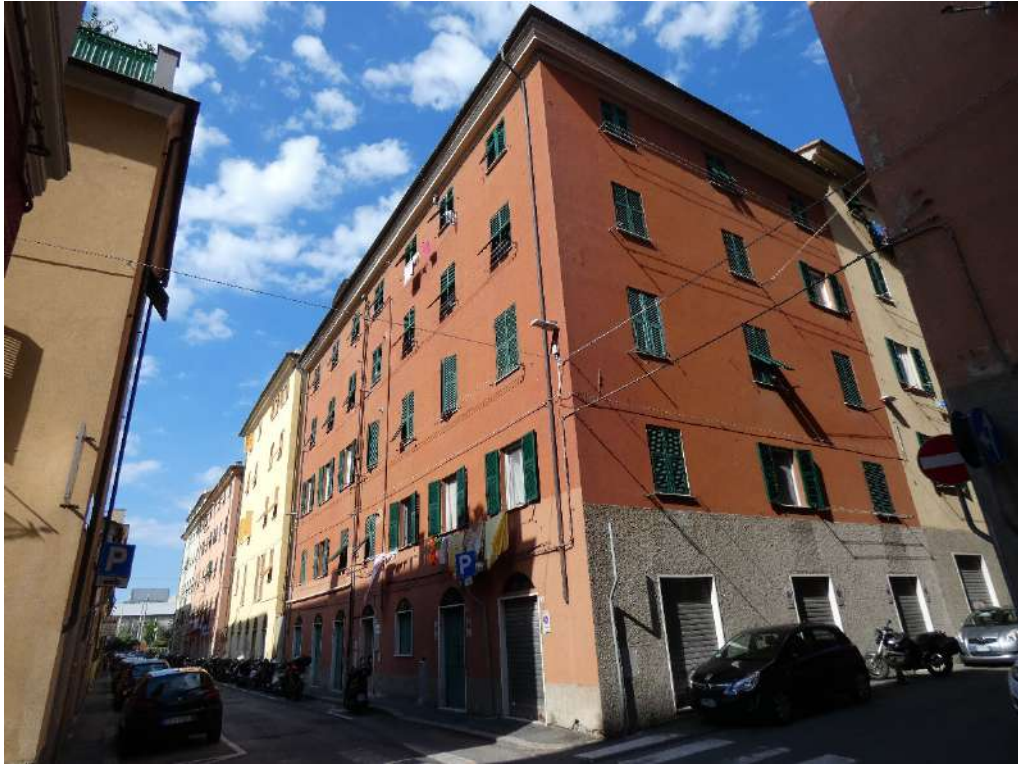
Foto n°50 - vista generale del fabbricato di Via ursone da Sestri civ. 13
