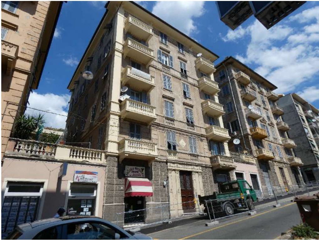
Foto n°75 - vista generale del fabbricato di Viale Carlo Canepa civ. 20
