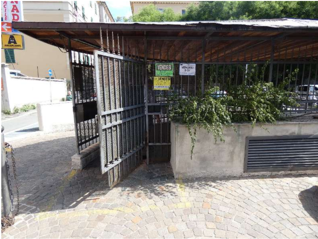
Foto n°72 - vista generale entrata autorimessa
