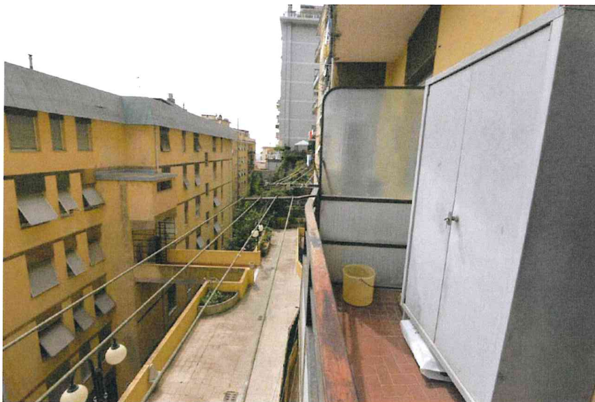
POGGIOLO LATO SUD
