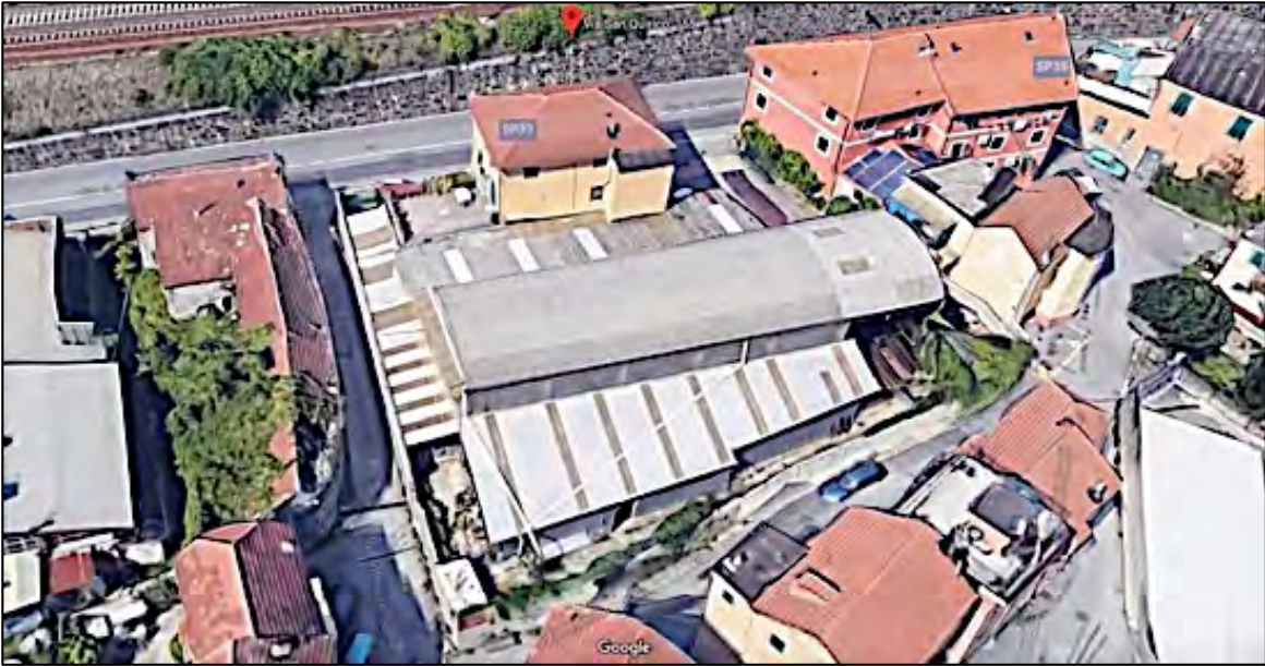
Vista verso ovest
