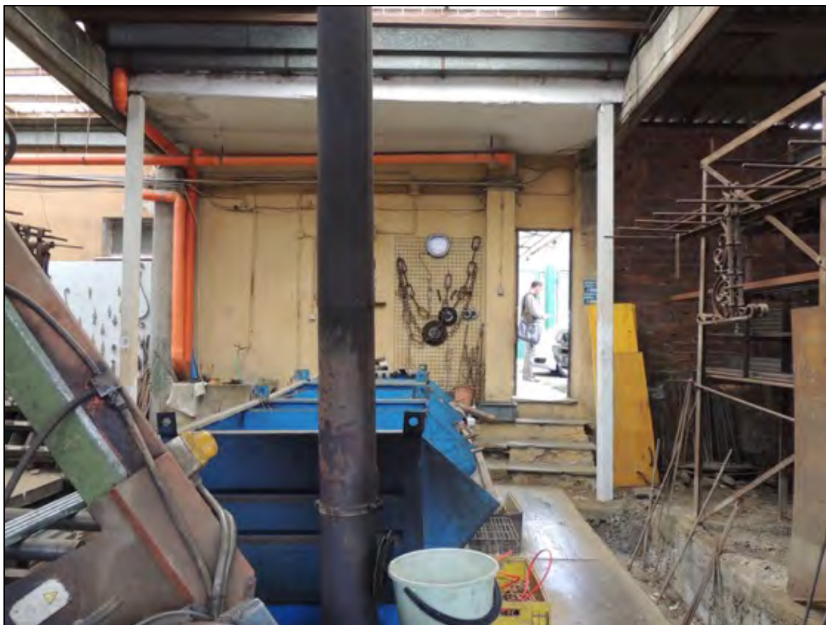
Foto 47 – vista sull'accesso pedonale al capannone a lato del fabbricato.
