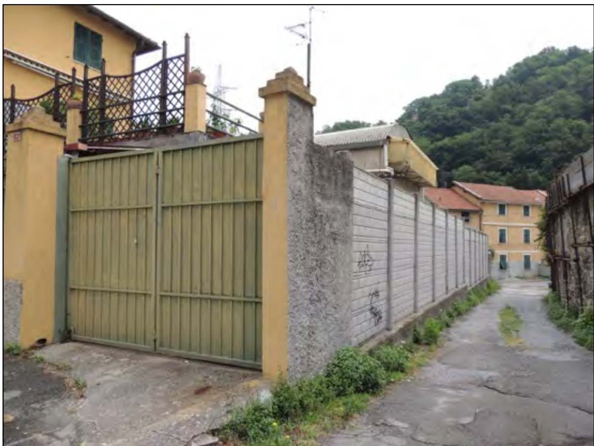
Foto 3 – la recinzione a sud su via inferiore Budulli
