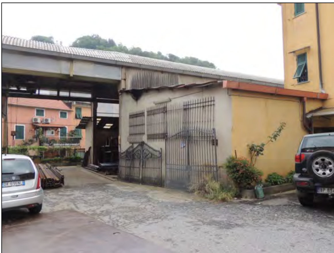
Foto 25 – la navata laterale del capannone e l'accesso carrabile in corrispondenza della navata centrale
