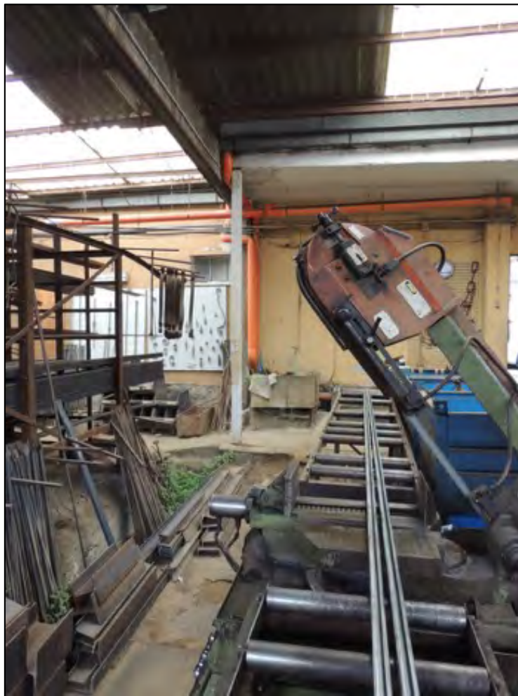
Foto 46 – vista dall'interno del capannone verso il fabbricato
