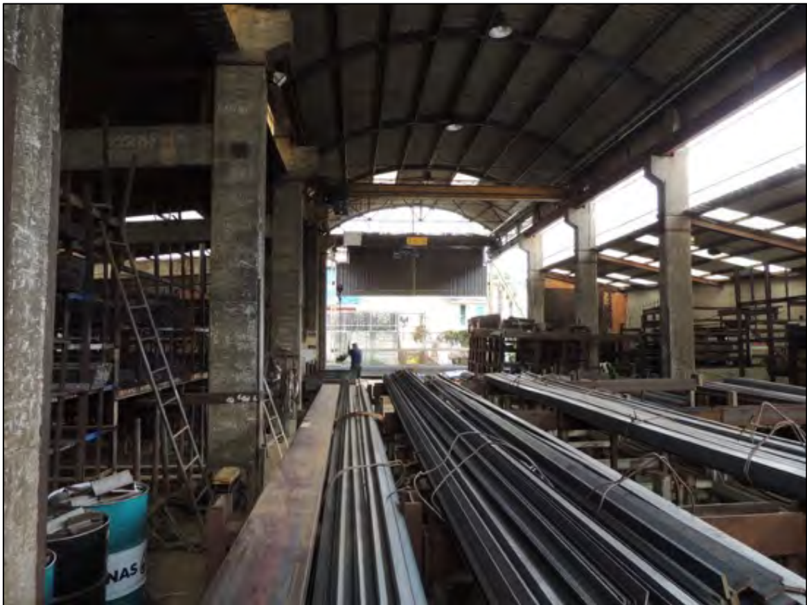
Foto 40 – la navata centrale: dai pilastri di supporto della copertura a volta di botte, le travi di c.a. di collegamento ai pilastri adiacenti al muro perimetrale dell'edificio del civ.77
