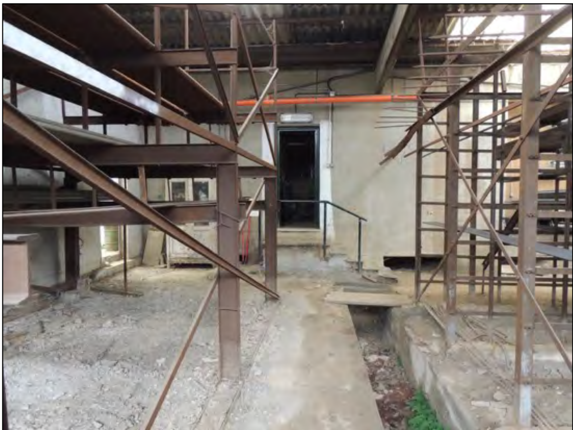
Foto 41 – l'interno del capannone, vista sulla scala e l'accesso al locale magazzino e spogliatoi del personale, il civ. 155r.
