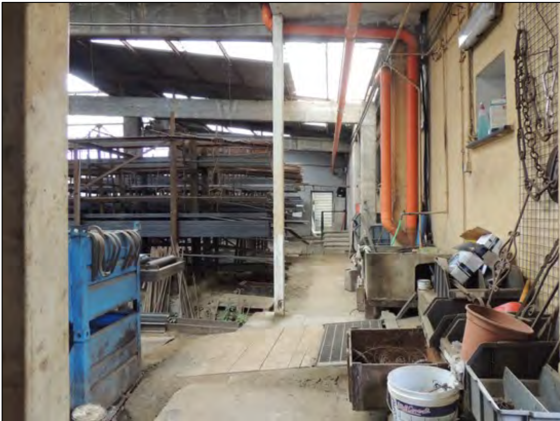
Foto44 – la navata laterale verso ovest, a destra il muro del fabbricato , sullo sfondo la scala verso il magazzino e di fronte la porta di accesso al distacco su via inferiore Budulli
