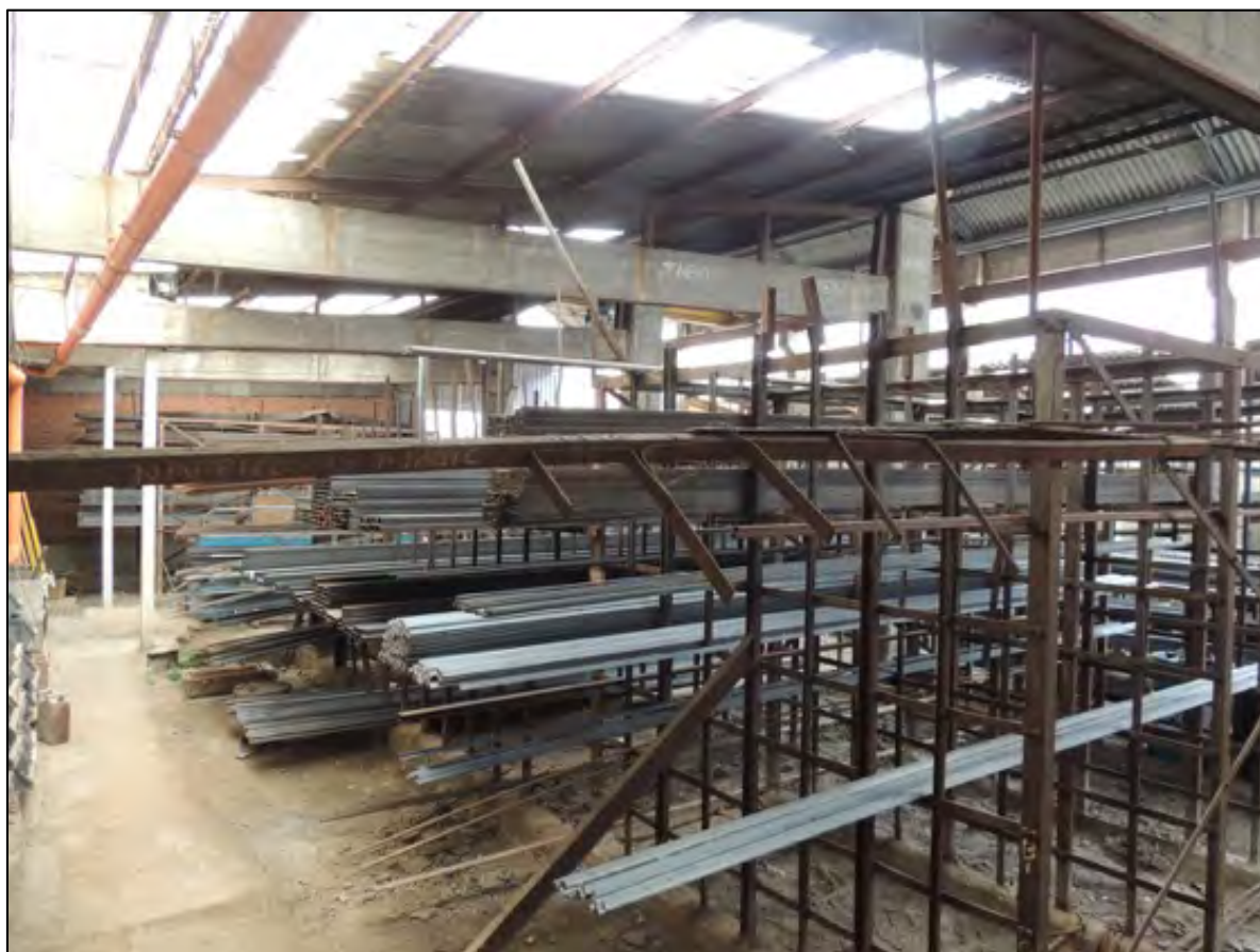
Foto 43 – la navata laterale adiacente all'edificio civ.77
