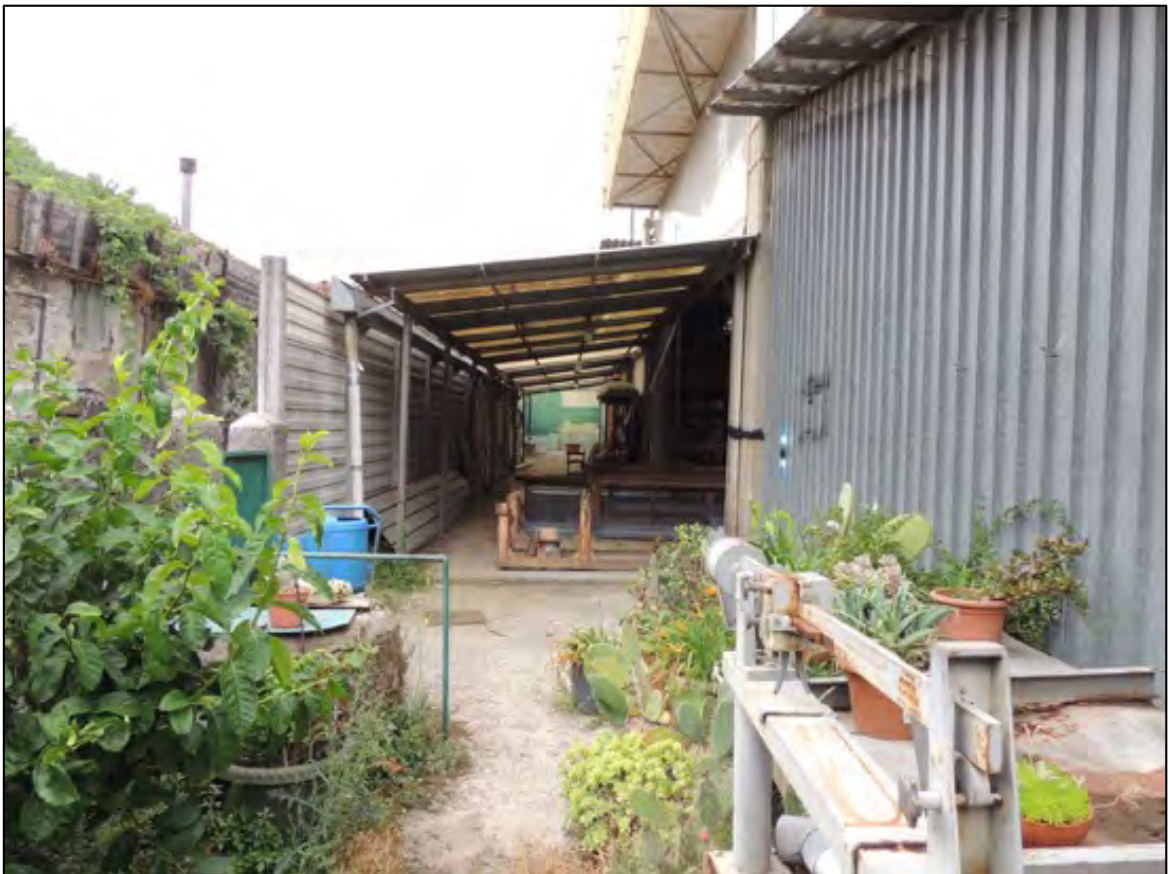
Foto 33 – il distacco verso sud, da via Inferiore Budulli, che in corrispondenza della navata centrale è coperto da tettoia in lamiera zincata alternata da ondolux
