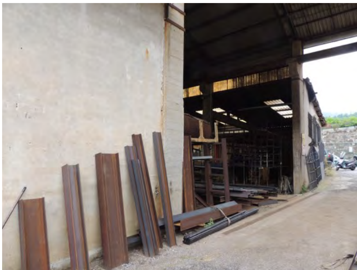
Foto 29 – il tamponamento delle due navate laterali verso via San Quirico
