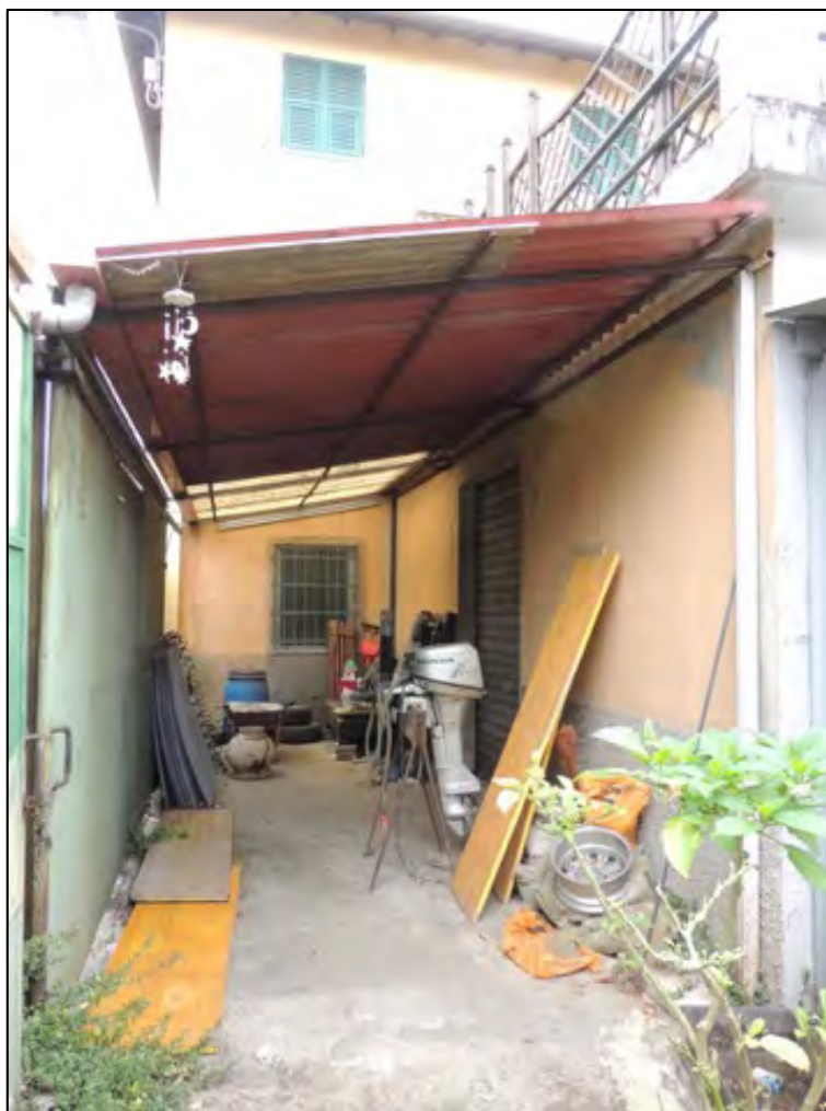
Foto 38 – il distacco su via San Quirico coperto da tettoia
