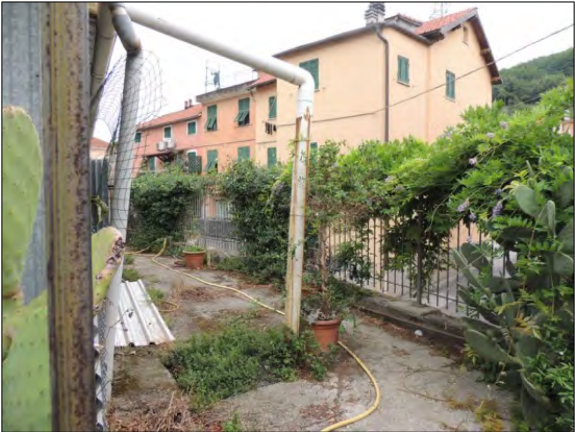
Foto 32 – il distacco del capannone su via Inferiore Budulli
