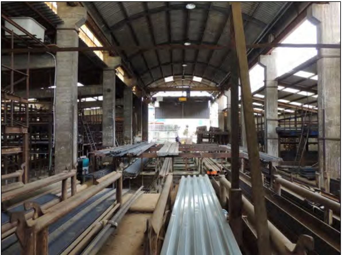
Foto 35 – vista assiale verso nord del capannone
