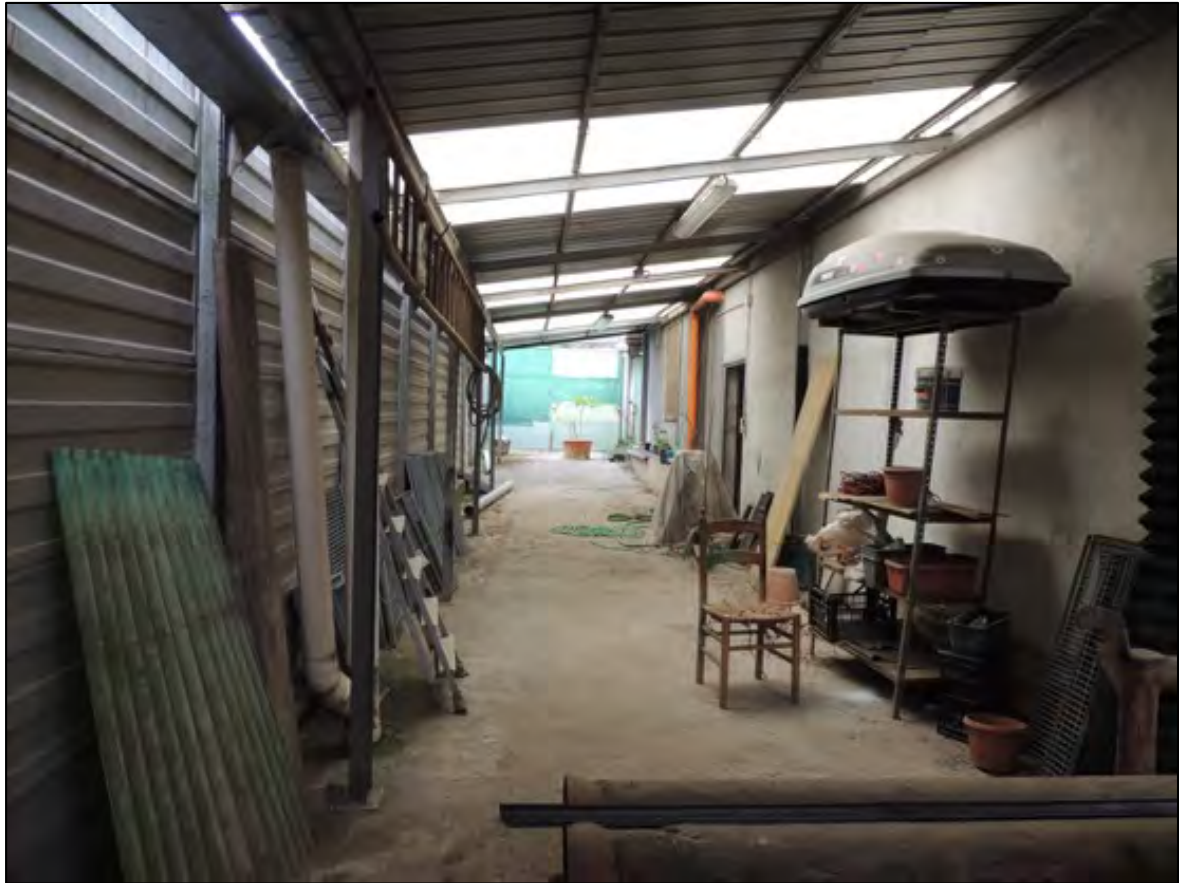
Foto 36 – il distacco verso sud coperto da tettoia in lamiera zincata alternata da ondolux
