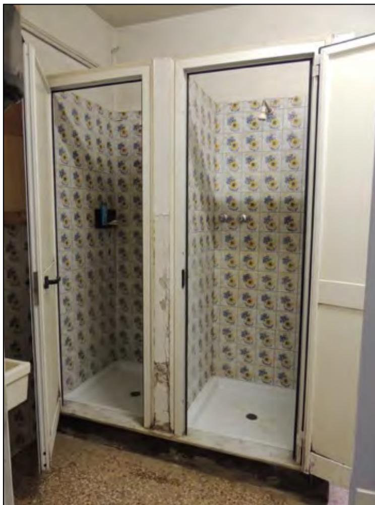
Foto 22 – le due cabine doccia nello spogliatoio
