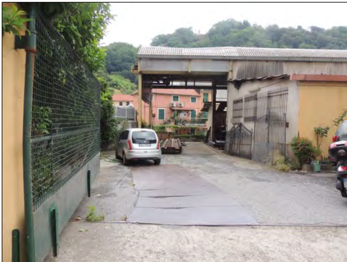
Foto 24 – il civ. 157r. Il capannone visto dall'ingresso carrabile su via San Quirico. La navata centrale, con copertura a volta a botte ribassata, avanza, rispetto alle due laterali
