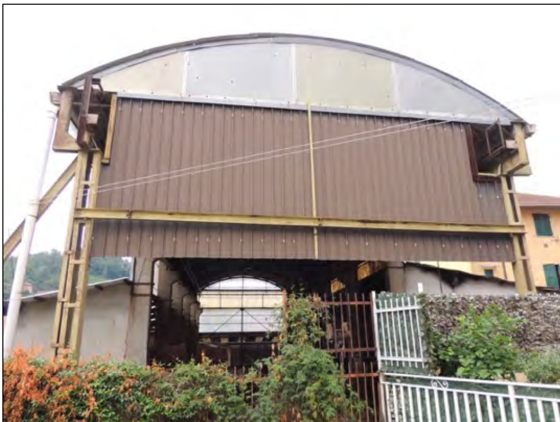
Foto 8 – vista dalla scala dell’immobile confinante del corpo centrale del magazzino, con copertura a volta di botte ribassata e tamponamento verticale in lamiera grecata
