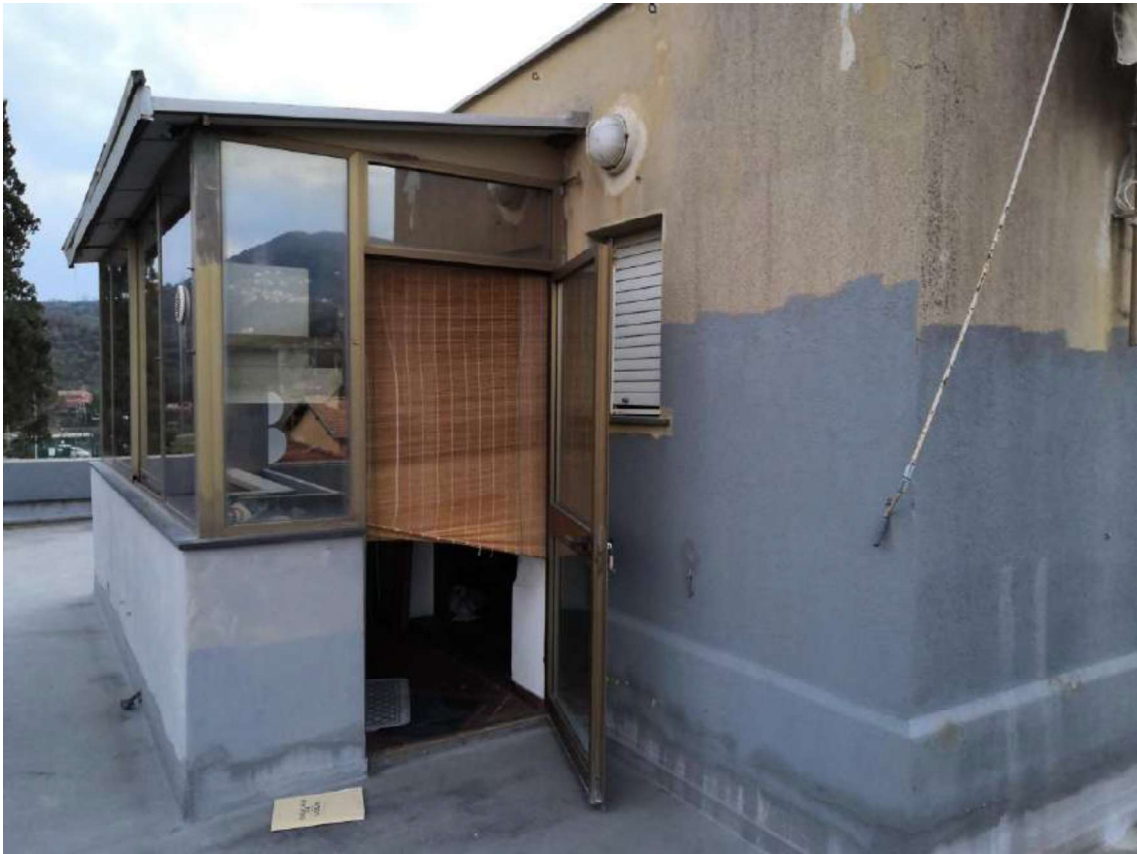
Foto 19: VERANDA – PIANO TERZO
