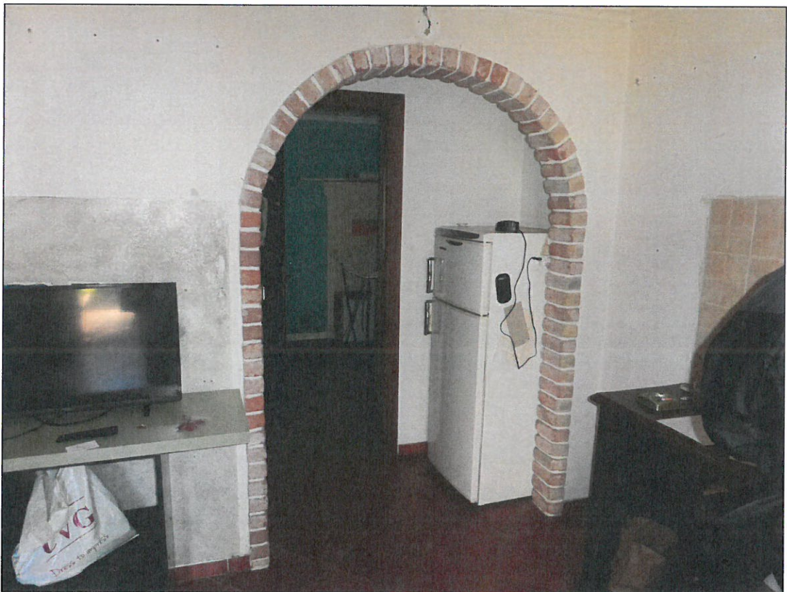
ARCO DI ACCESSO AL DISIMPEGNO
