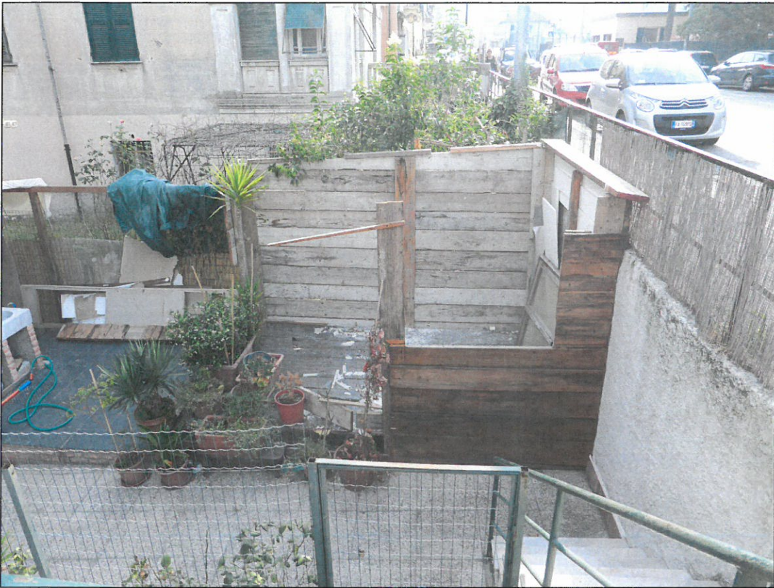
SCALA DI ACCESSO
