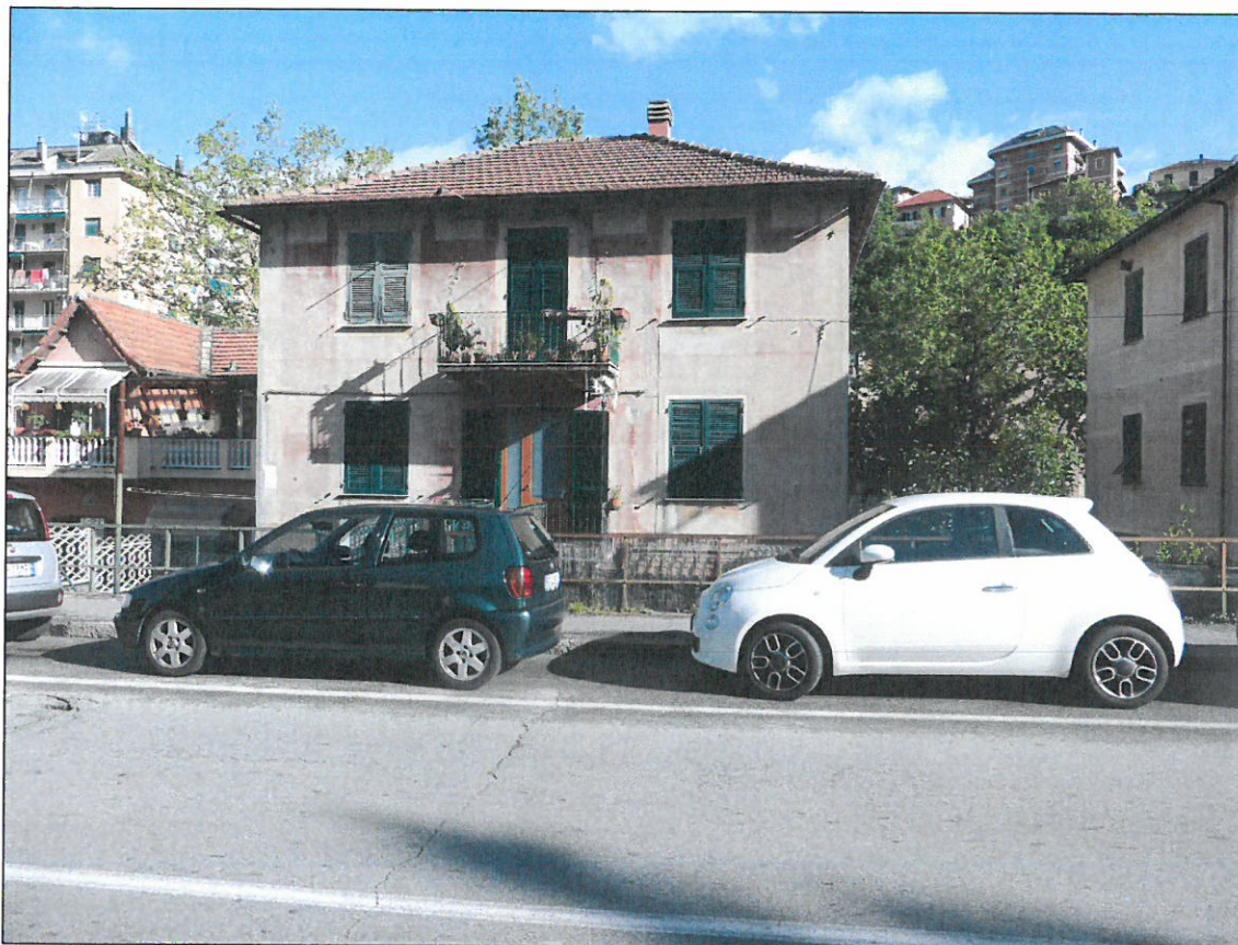
FABBRICATO VISTO DA VIA STRUPPA
