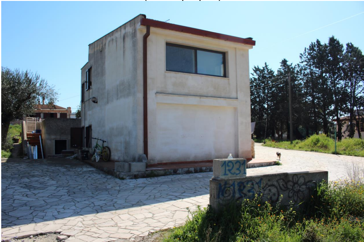
Foto 3 (Vista del prospetto)
