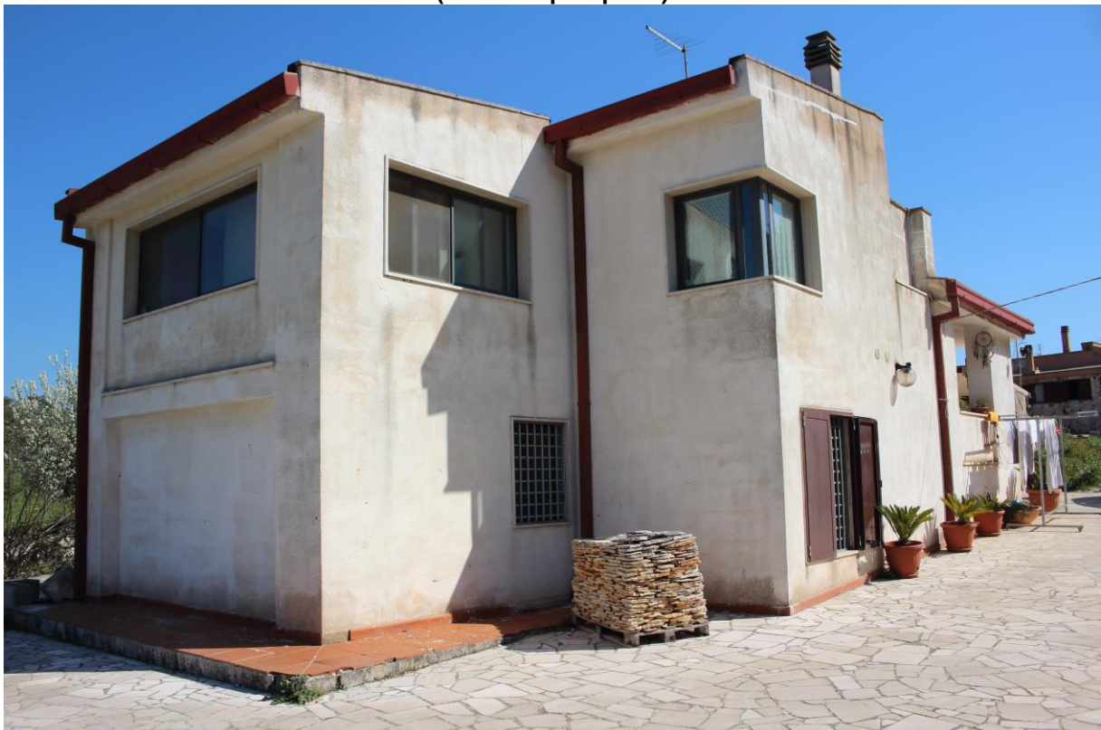
Foto 4 (Vista del prospetto)
