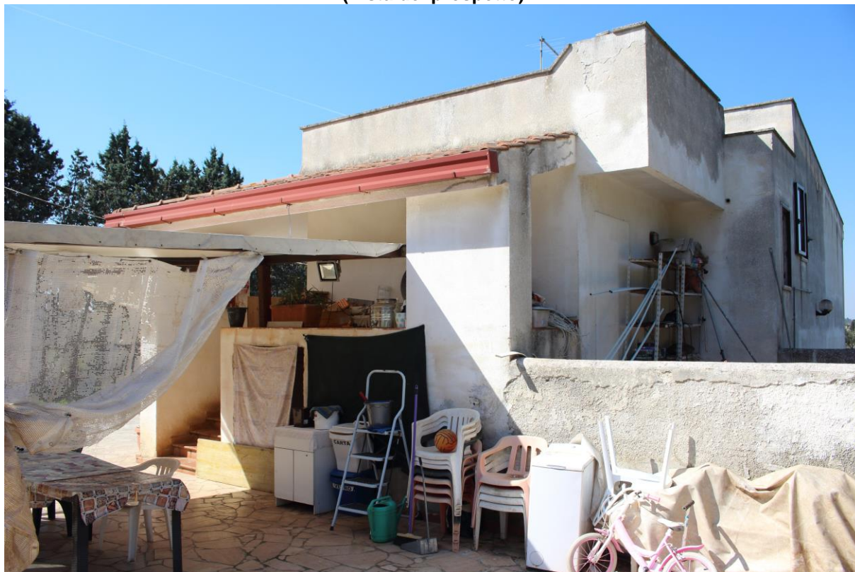
Foto 6 (Vista del prospetto)
