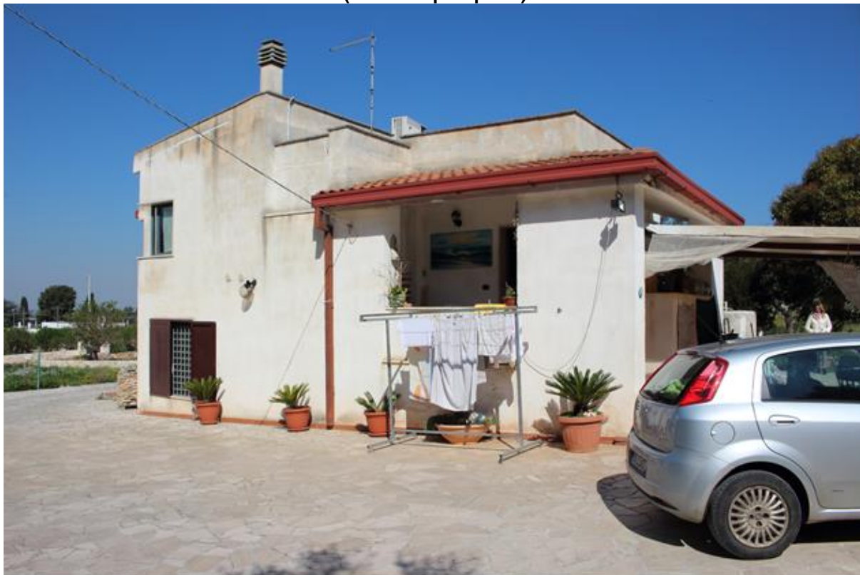
Foto 5 (Vista del prospetto)
