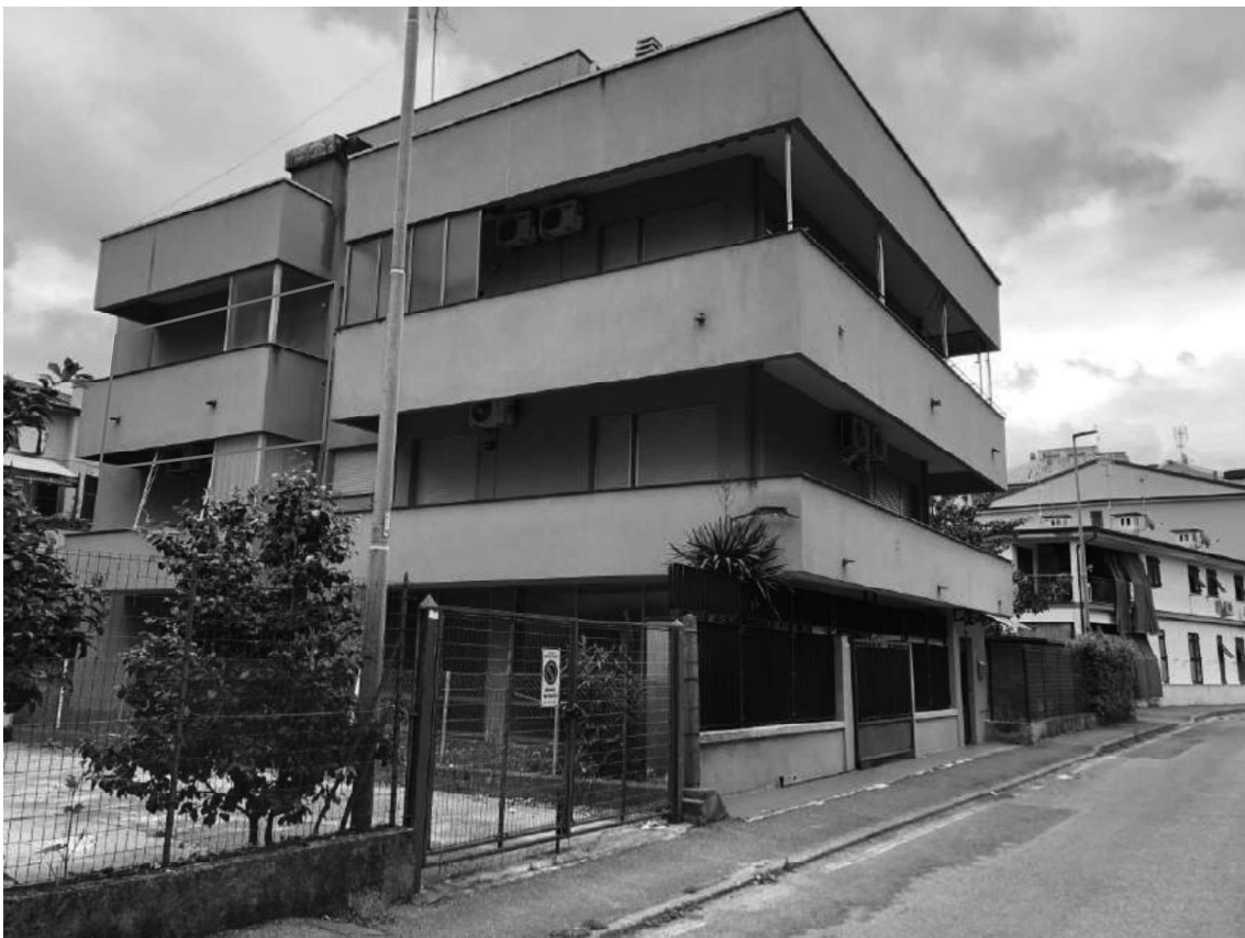
Foto 2: VEDUTA GENERALE DEL FABBRICATO IN CUI RICADE L'IMMOBILE OGGETTO DI STIMA.
