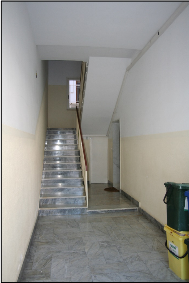
FOTO 4 - ANDRONE CONDOMINIALE DELL'EDIFICIO.
