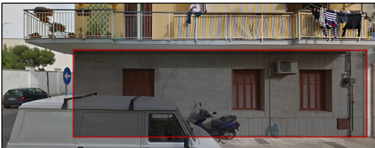
FOTO 3 - PROSPETTO A SUD-OVEST SU VIA RAFFAELLO SANZIO.
