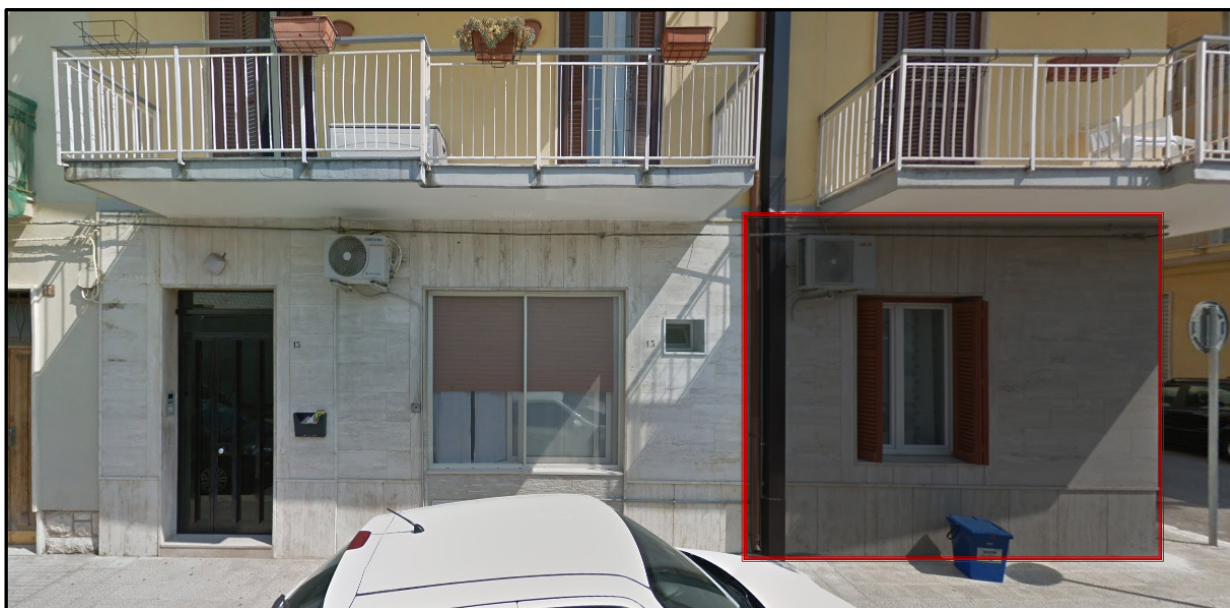
FOTO 2 - PROSPETTO A NORD-OVEST SU VIA PIERO DELLA FRANCESCA.
