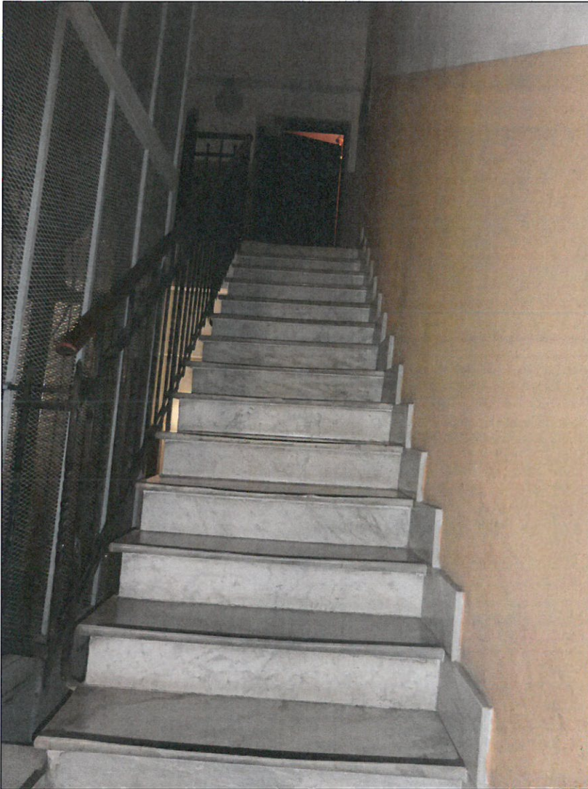
VANO SCALA B
