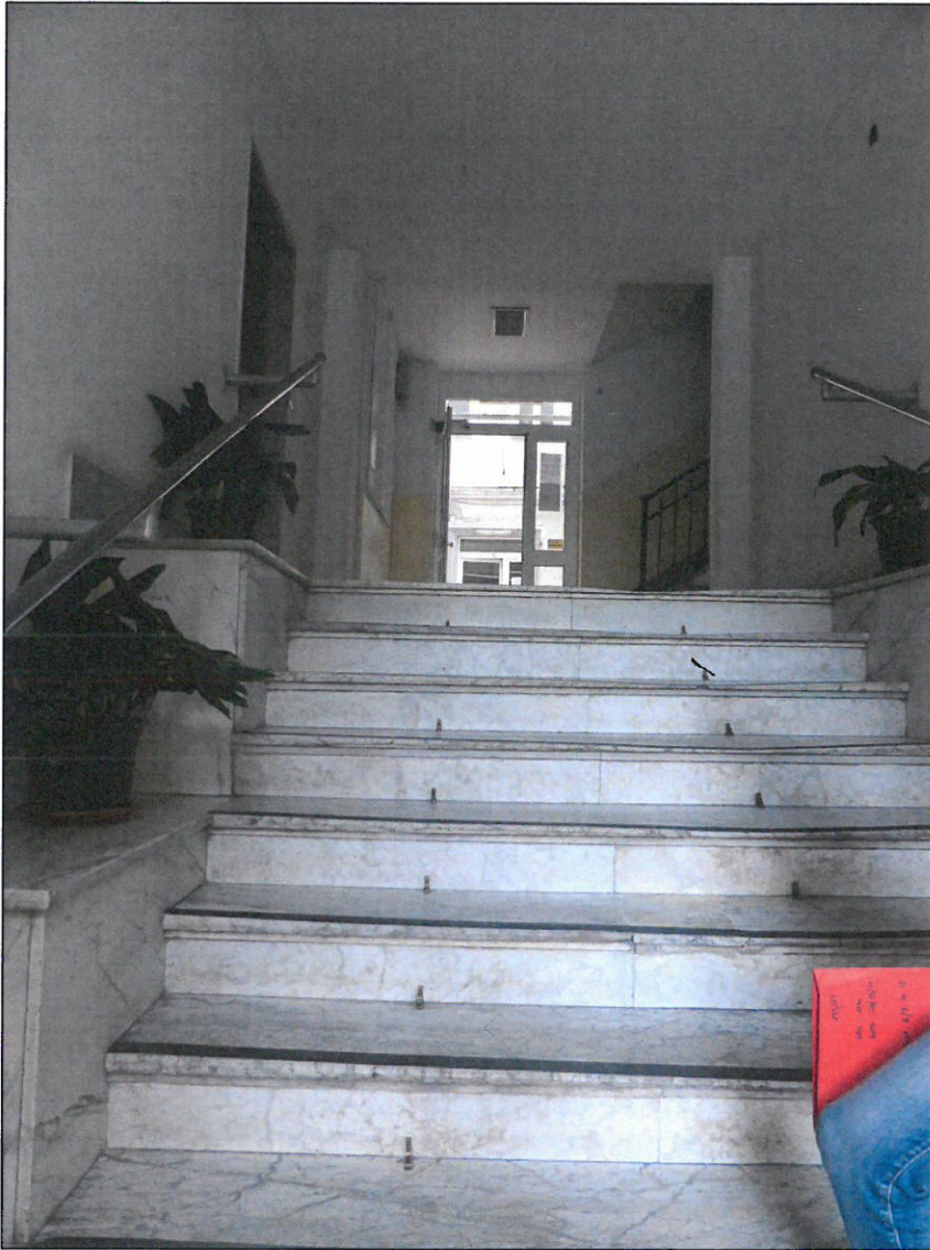
ATRIO DI ACCESSO ALLA SCALA A E AL CORTILE INTERNO
