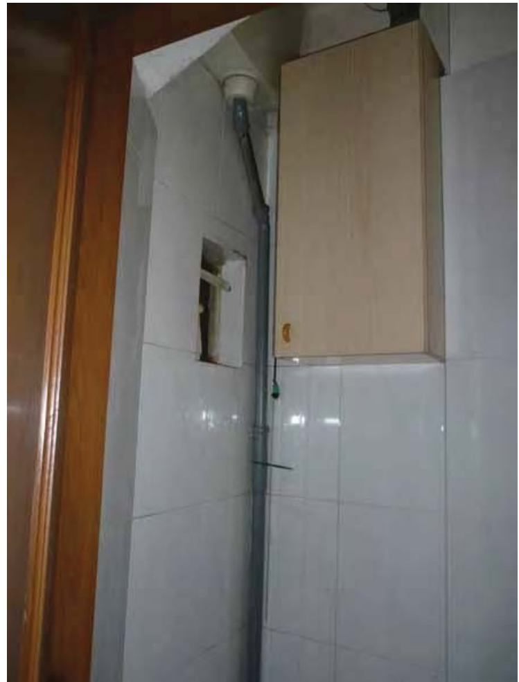
22) Particolare Locale w.c.
