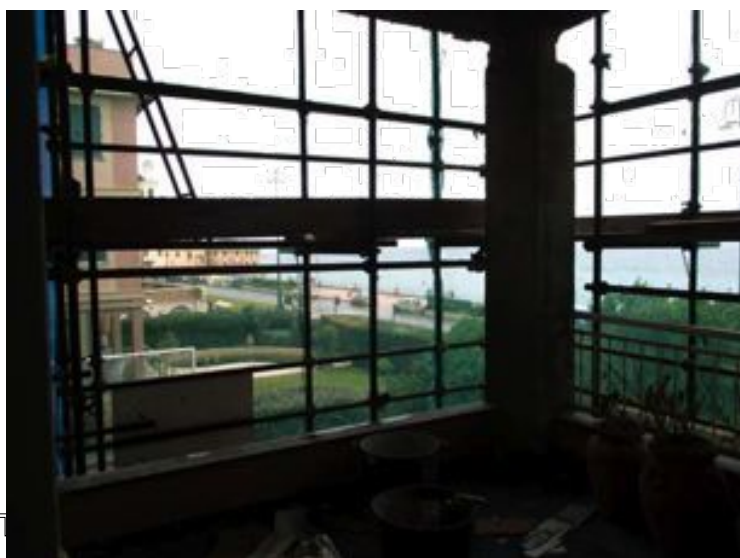
la loggia con la vista su Corso Italia; oggi interessata da lavori di ristrutturazione
