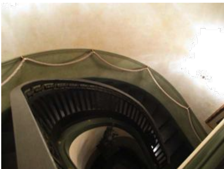
la scala di collegamento con il piano superiore
