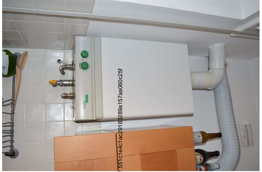
Bolier acqua calda sanitaria
