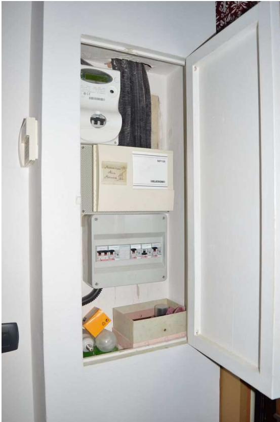
Quadro elettrico principale
