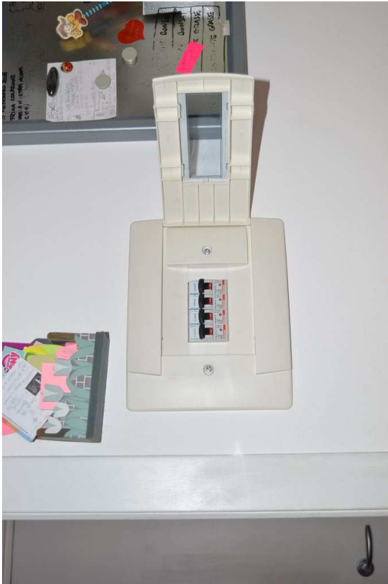
Quadro elettrico cucina
