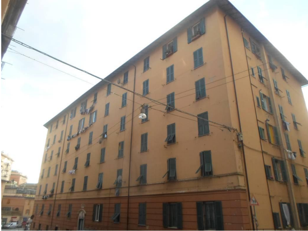
FOTO N. 1 Vista dell'edificio da Viale Centurione Bracelli.
