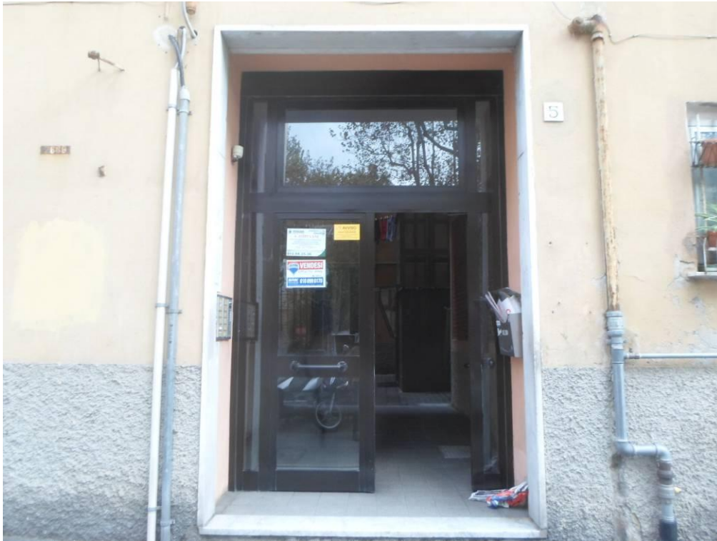
FOTO N. 3 Ripresa del portone di accesso al caseggiato di Piazza Galileo Ferraris contraddistinto con il civico 5.
