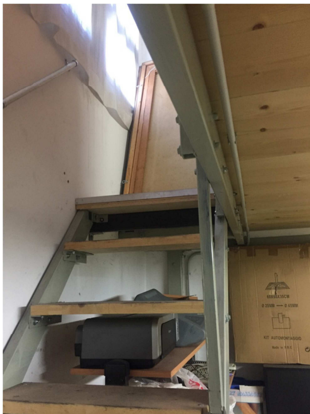
Scala accesso al soppalco
