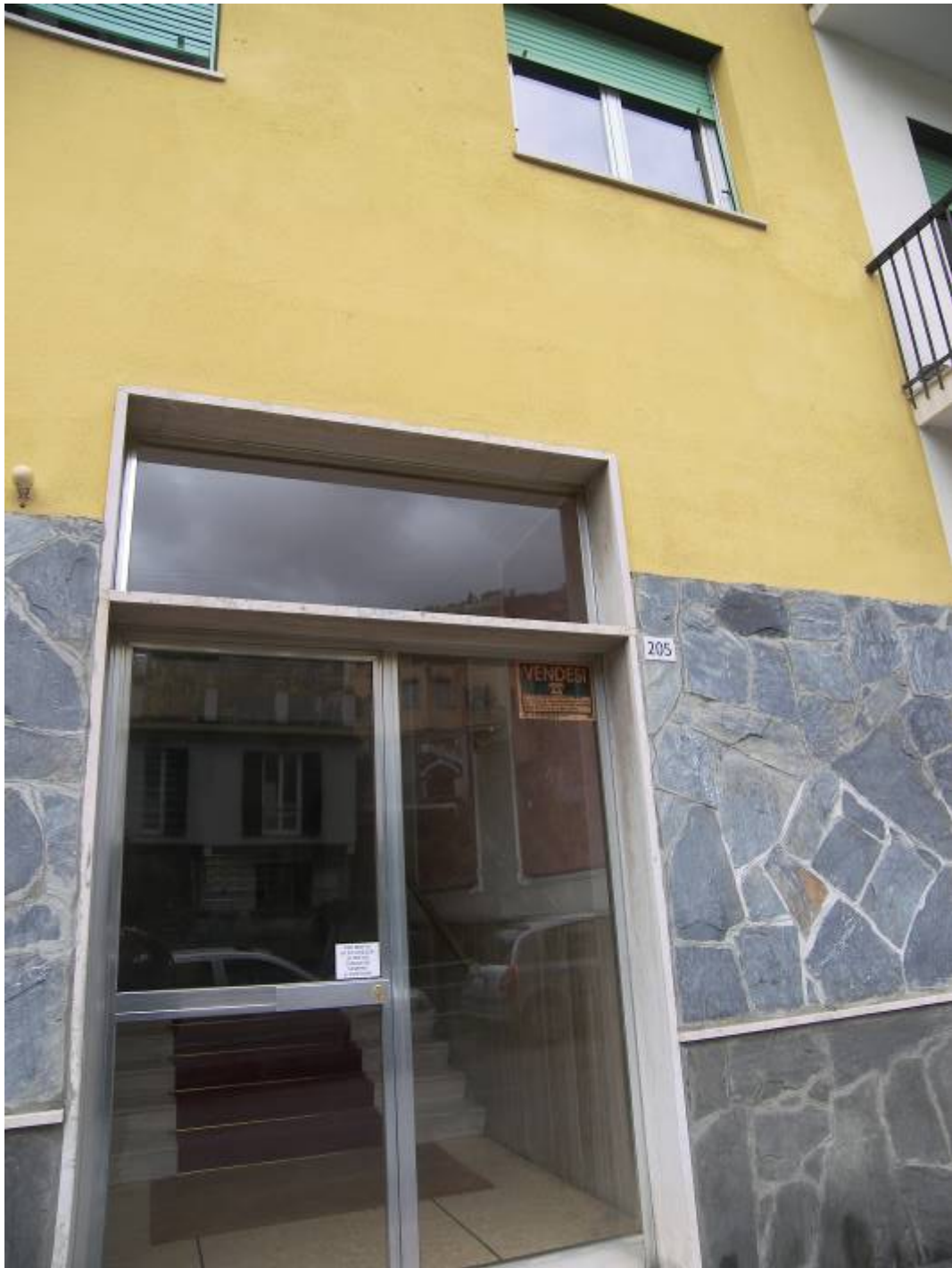
Foto 2 dettaglio portone accesso al condominio
