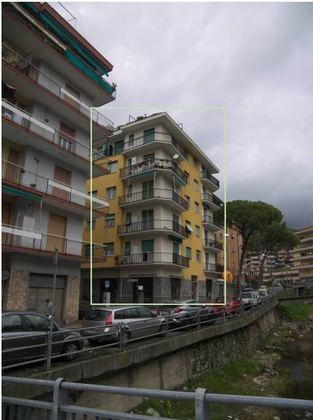
Foto 1 – Vista generale area circostante il fabbricato
