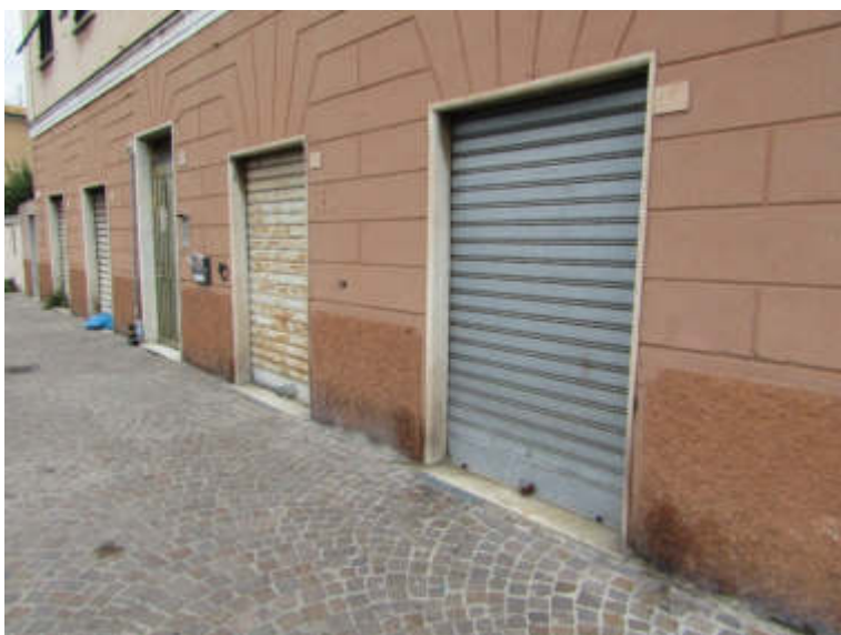
Foto 4 – accessi su via Prà
