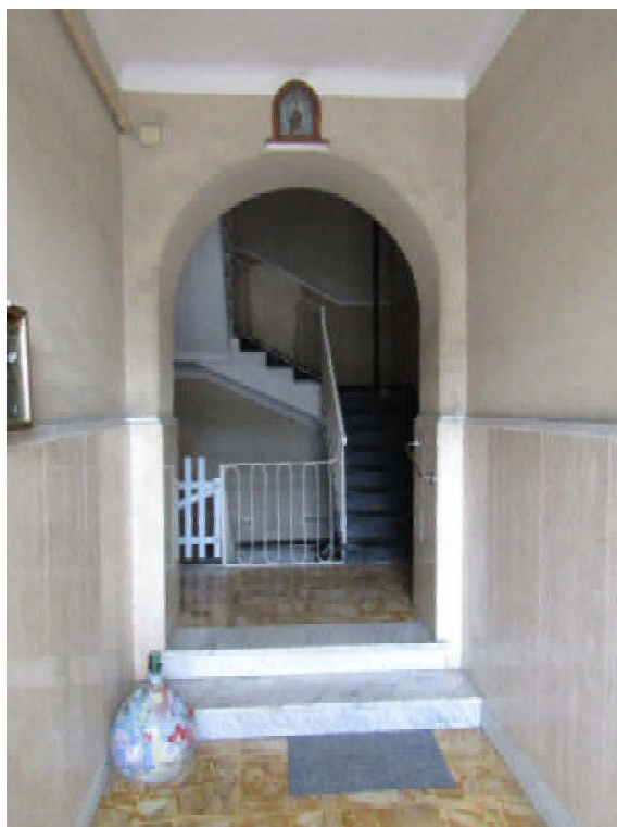
Foto 11 – vista del vano scala condominiale
