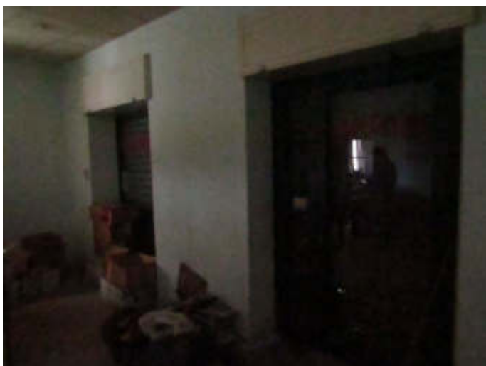
Foto 32 – accessi su via Prà
