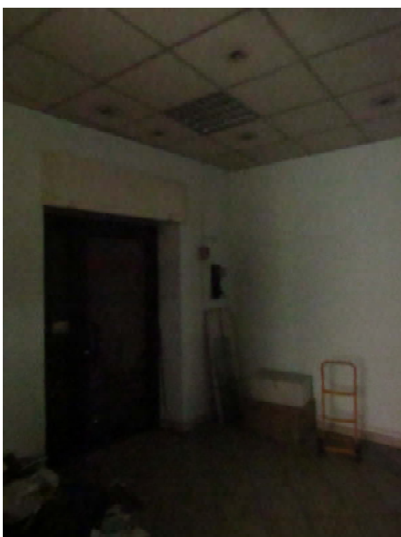
Foto 33 – particolare varco con accesso pedonale
