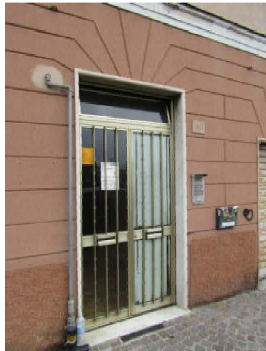
Foto 3 – ingresso c.n. 48 di via Prà
