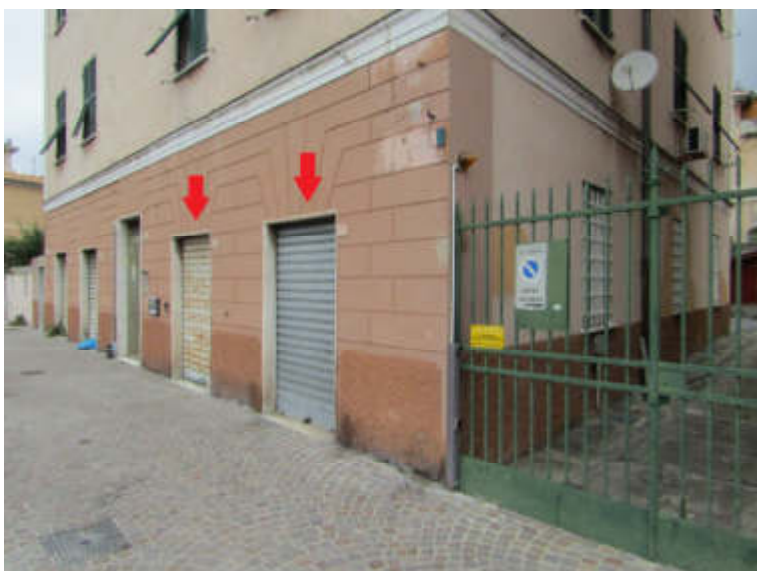
Foto 5 – accessi immobile int. 2
