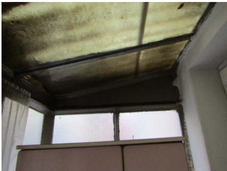
Foto 22 – particolare copertura volume/tettoia
