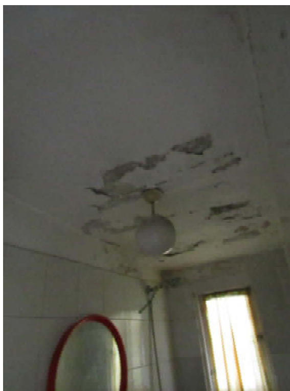
Foto 25 – particolare soffitto servizio igienico
