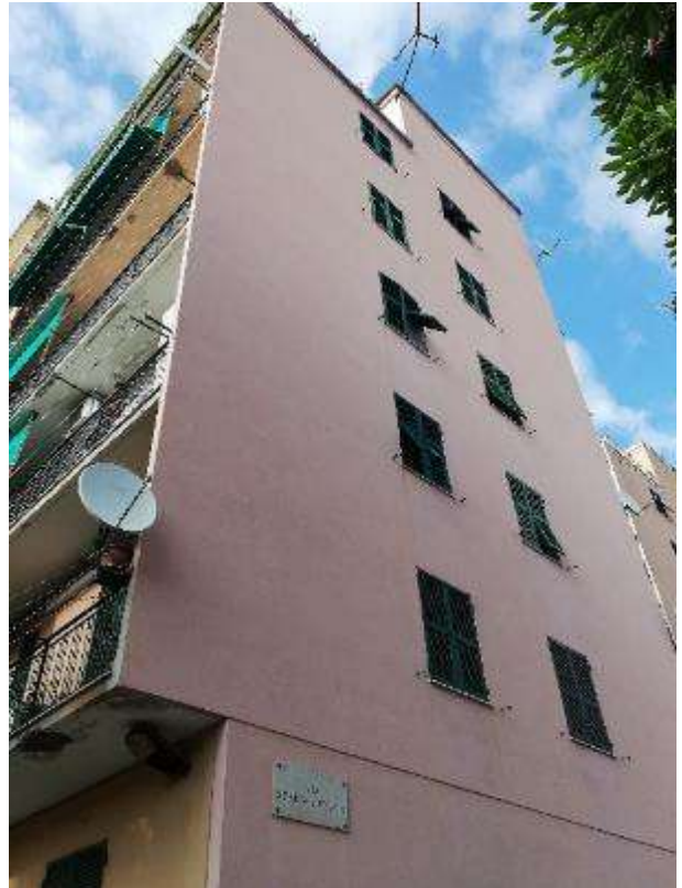
FOTO 10: prospetto laterale sud oggetto di recente intervento di manutenzione
