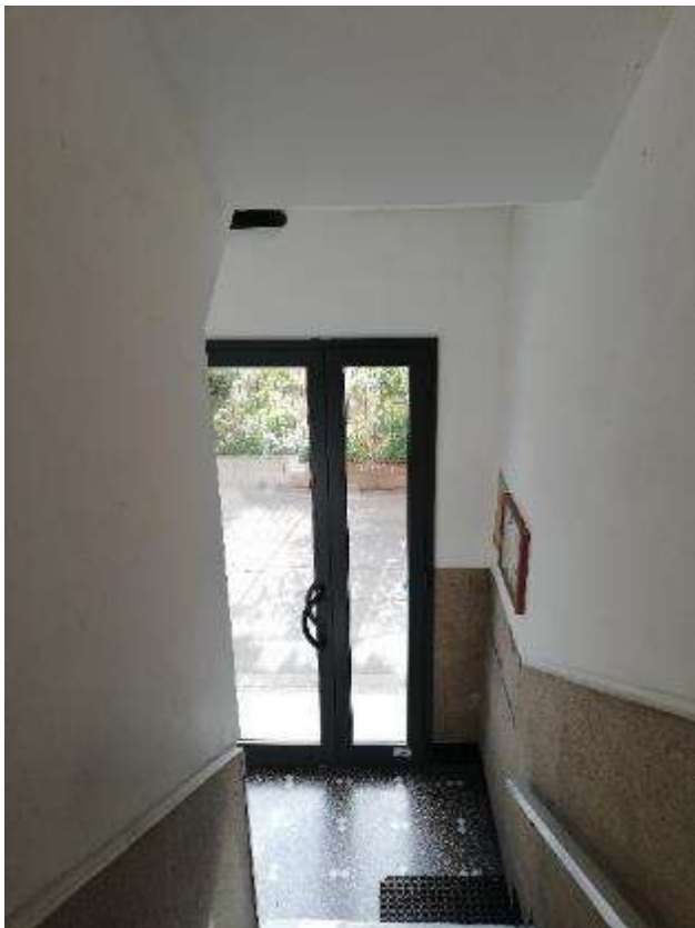
FOTO 1: vista dal vano scala verso il portone di ingresso
