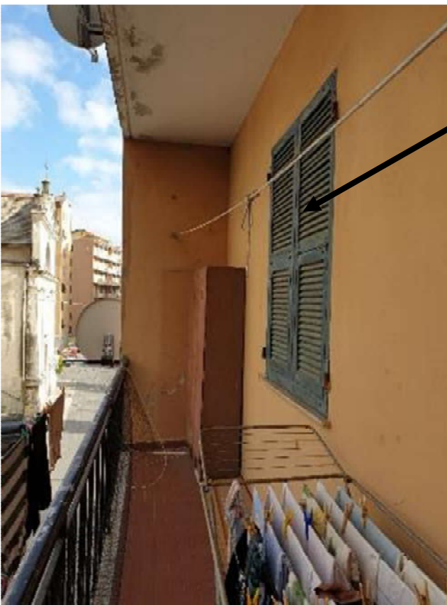
FOTO 12 – 13 - 14: balcone- con la freccia si evidenzia la persiana corrispondente alla bucatura tamponata nella camera matrimoniale
