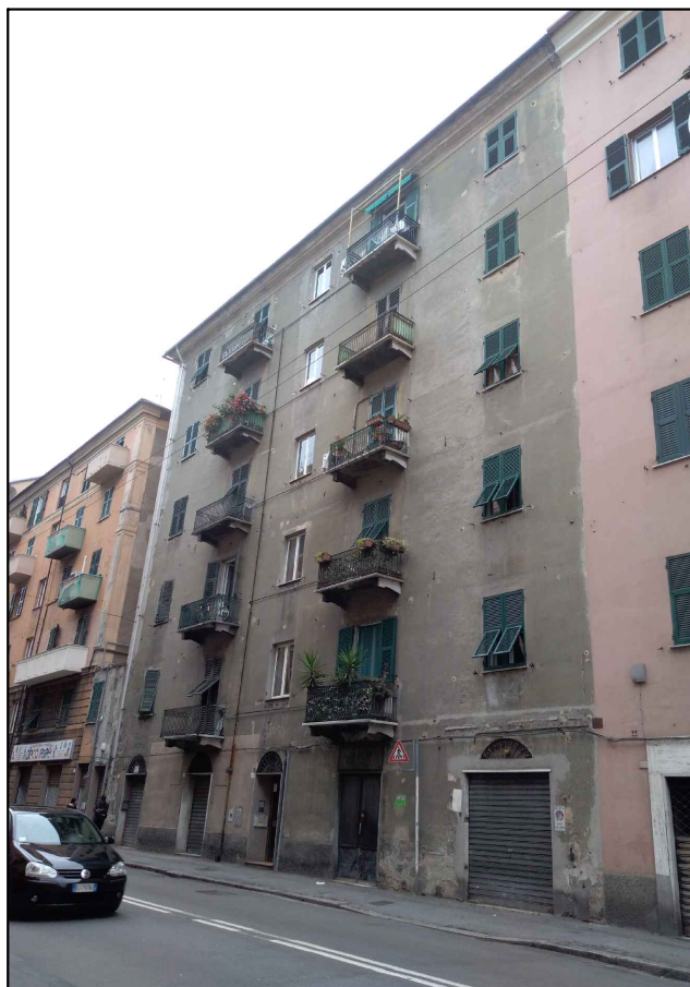
prospetto principale del condominio su via Fillak
