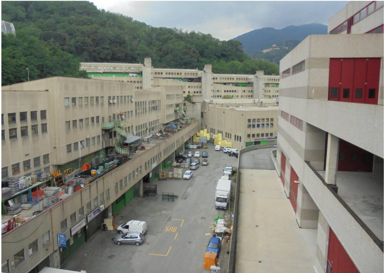
Foto 8 - Vista della rampa carraia retrostante della lottizzazione verso ponente
