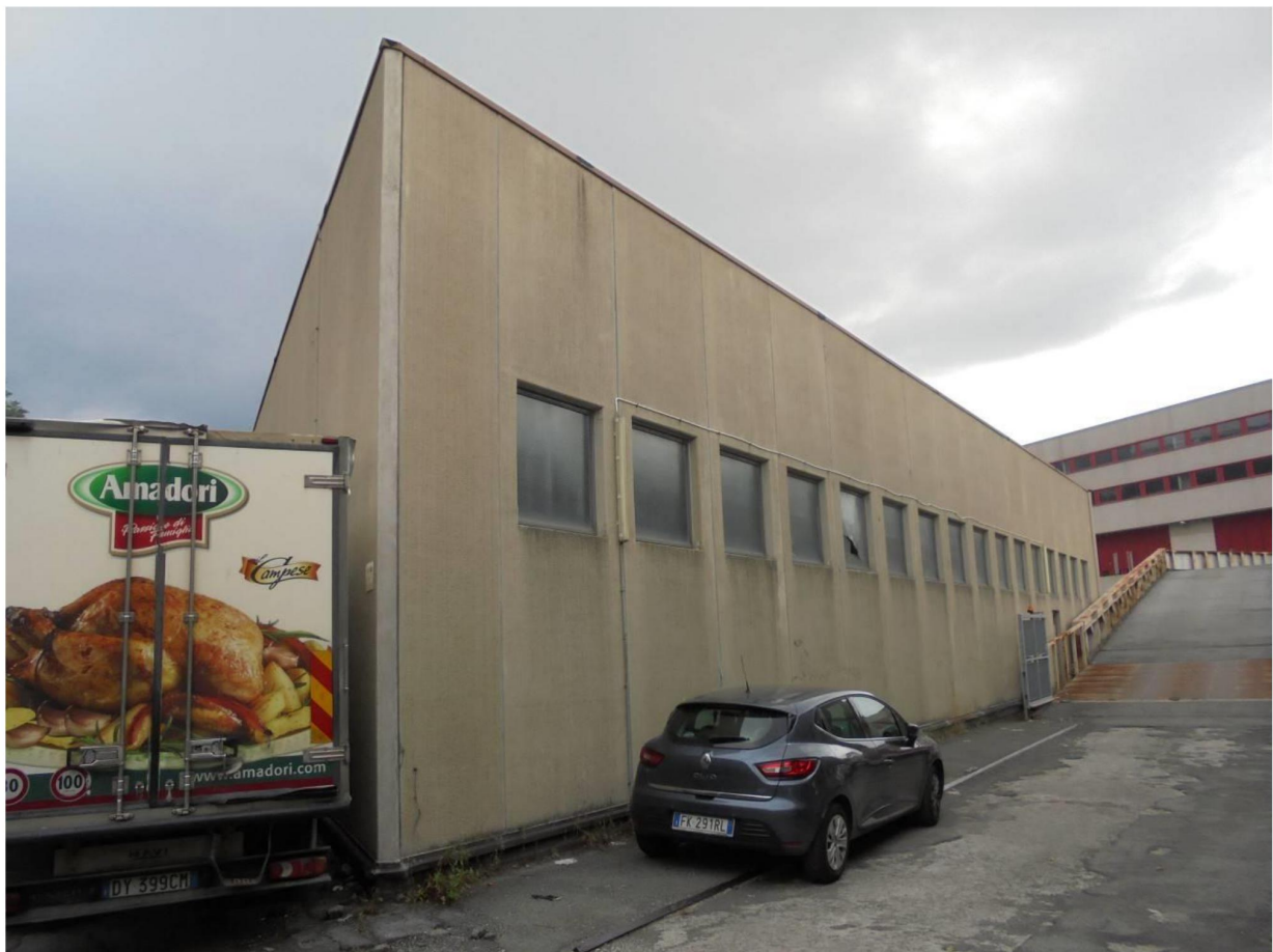
Foto 5 - Vista del fronte est del capannone da Via Albissola
