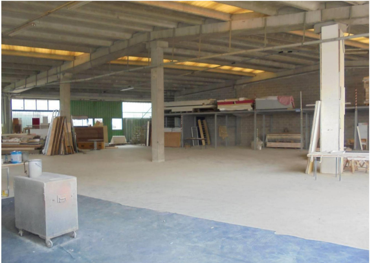
Foto 14 - Vista interna del capannone
