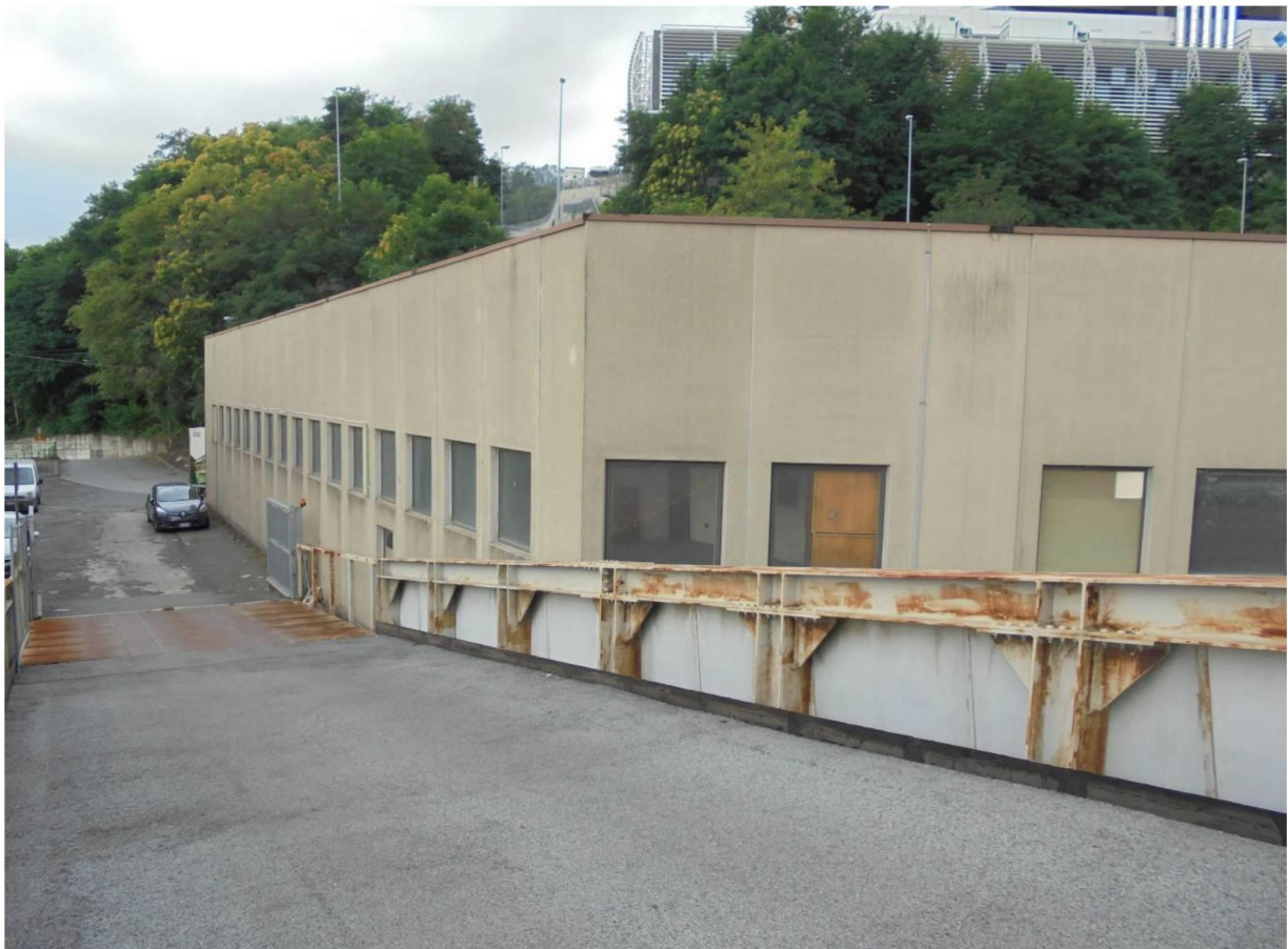
Foto 6 - Vista del fronte est del capannone da Via Albissola
