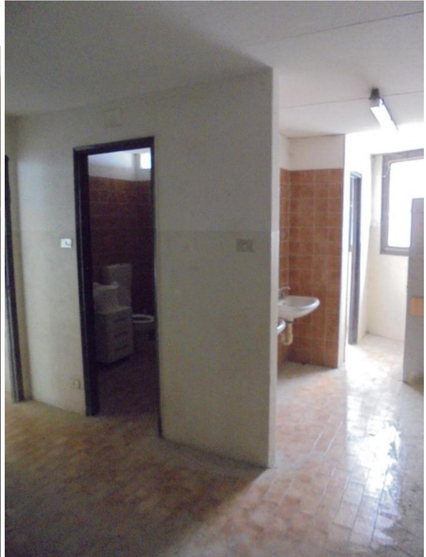
Foto 19 - Vista dell'ingresso spogliatoio
