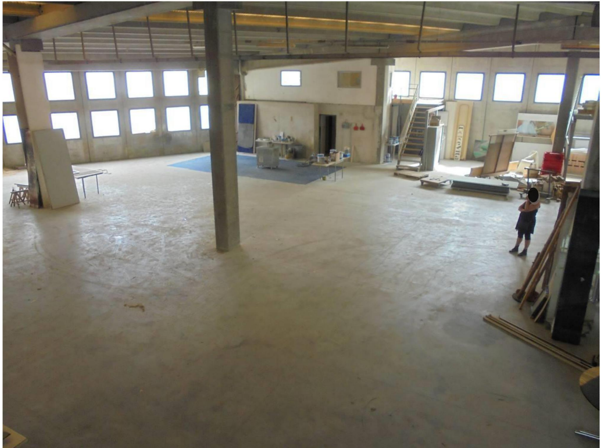
Foto28 - Vista del capannone dal soppalco nord
