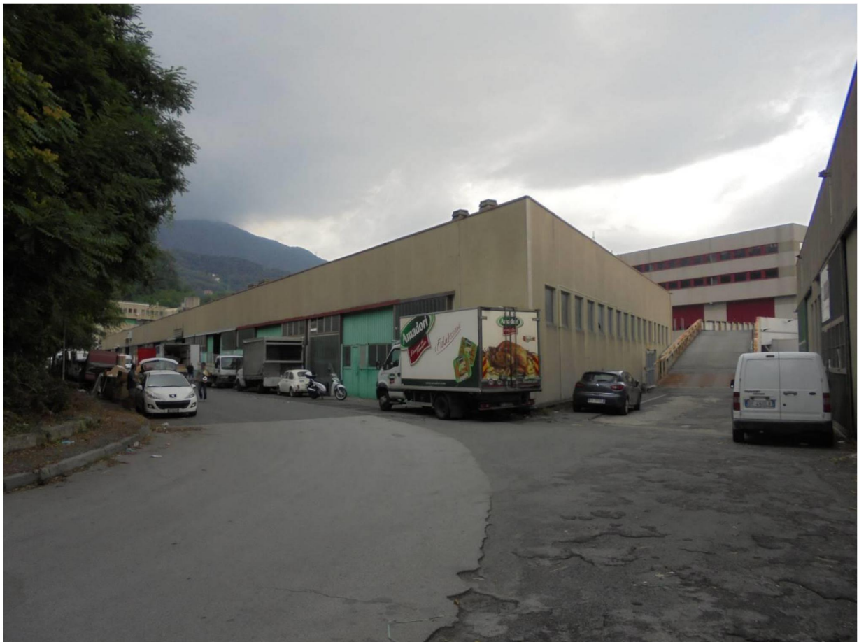
Foto 4 - Vista del capannone da Via Albissola
