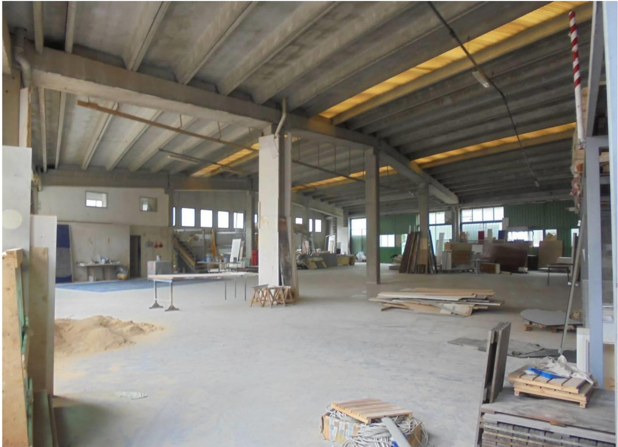
Foto 13 - Vista interna del capannone
