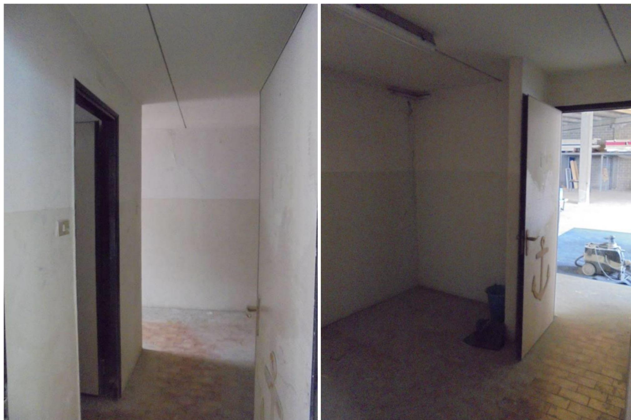
Foto 16 e 17 - Vista dell'ingresso spogliatoio
