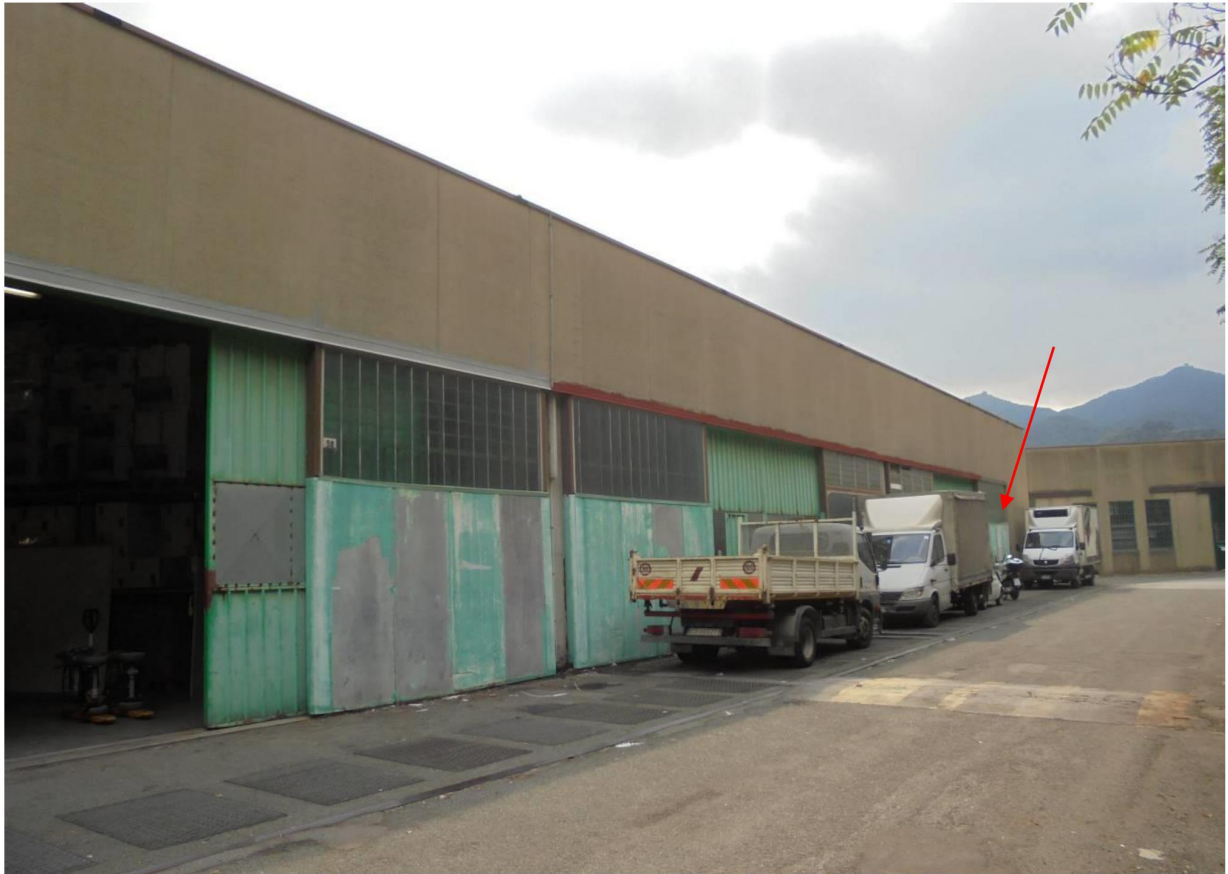
Foto 10 - Vista del fronte sud del capannone da Via Albissola In evidenza il punto di ingresso al capannone
