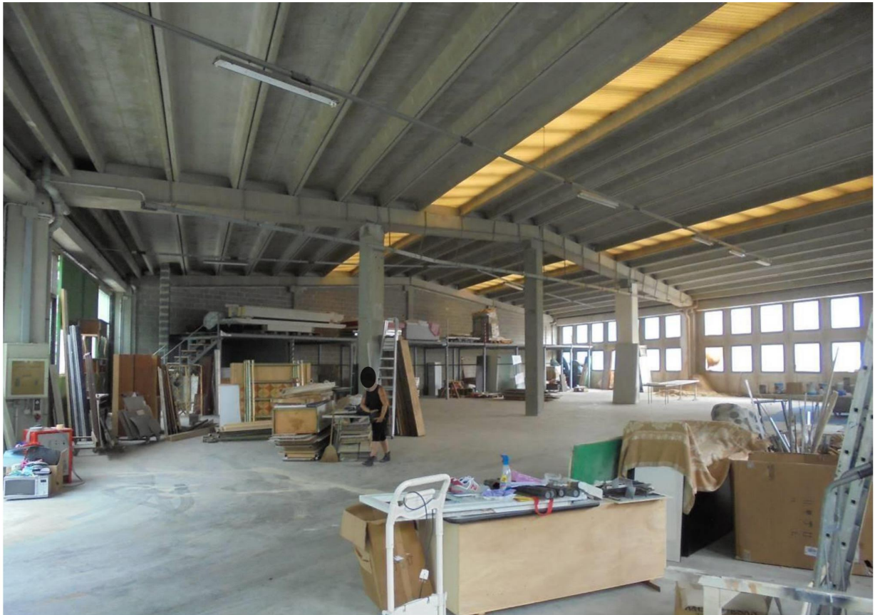
Foto 11 - Vista interna del capannone
