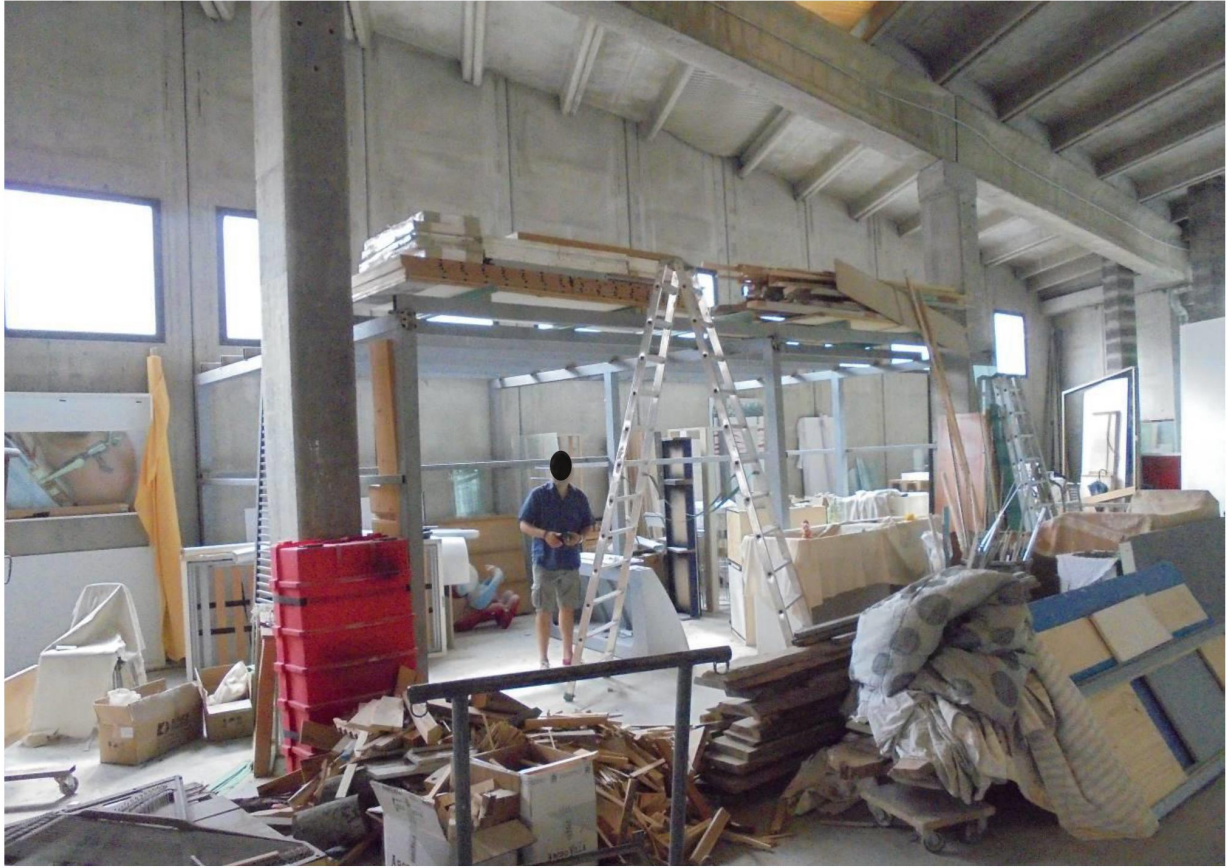
Foto 24 - Vista del soppalco sud
