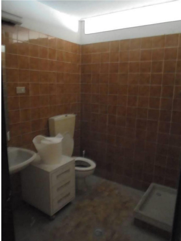
Foto 18 - Vista del W.C.1
