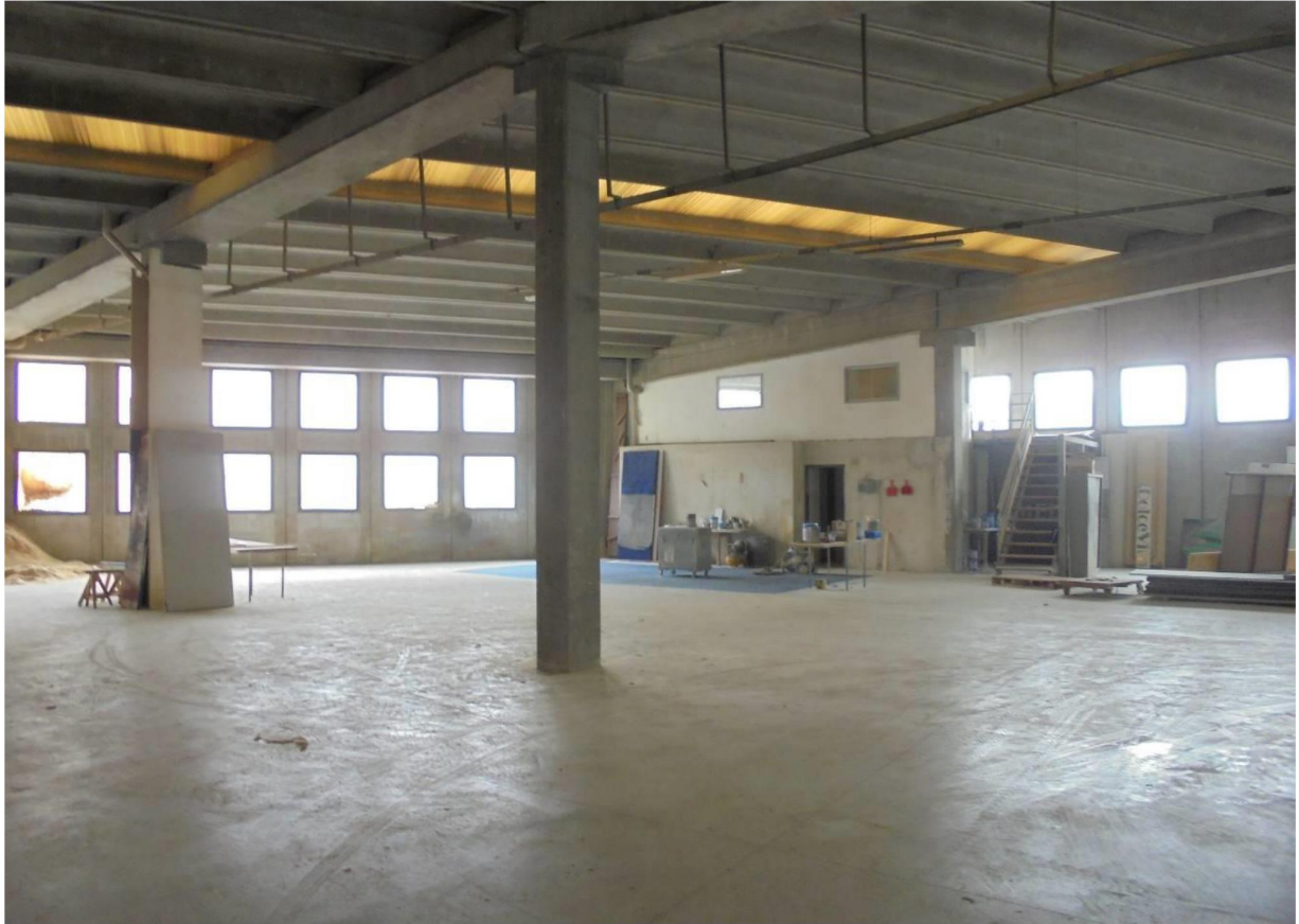
Foto 12 - Vista interna del capannone
