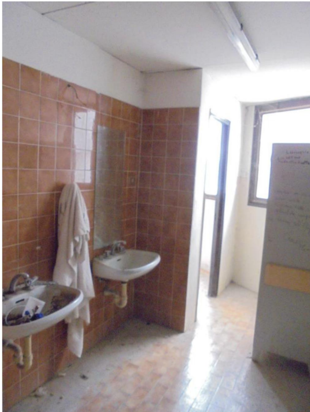
Foto 20 - Vista della zona bagni
