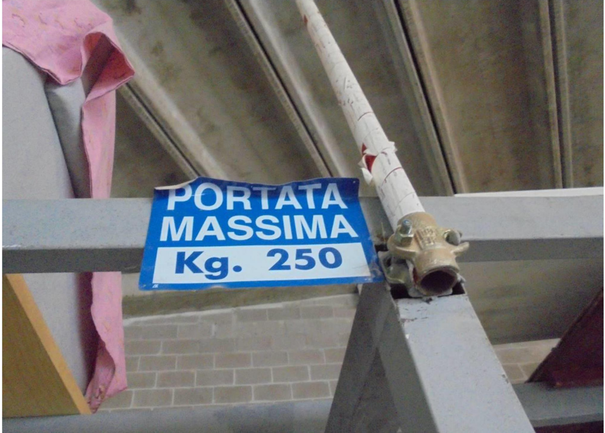
Foto 27 - Dettaglio del soppalco nord
