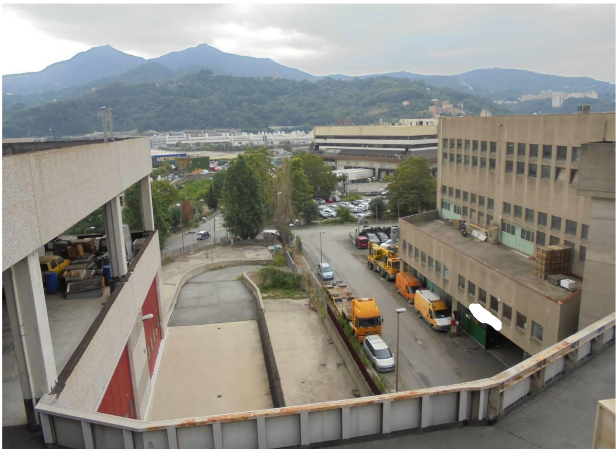
Foto 9 - Vista della rampa carraia retrostante della lottizzazione verso levante
