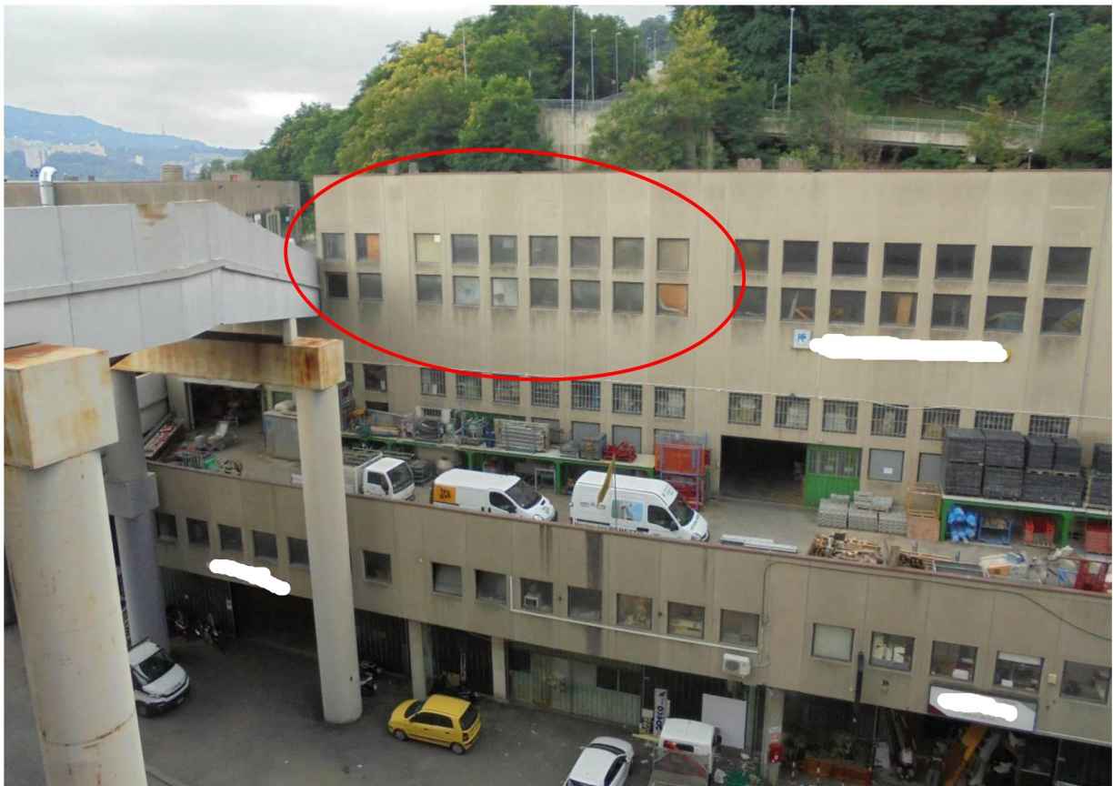
Foto 7 - Vista del fronte nord del capannone da Via Albissola
