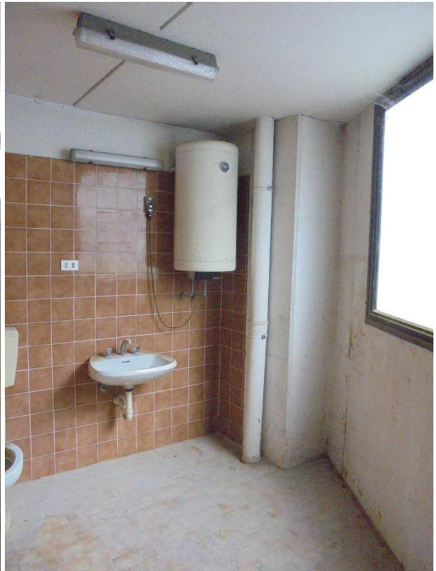
Foto 21 - Vista - Vista del W.C.2
