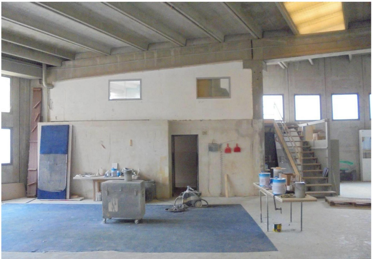
Foto 15 - Vista interna del capannone In evidenza la zona servizi/spogliatoio
