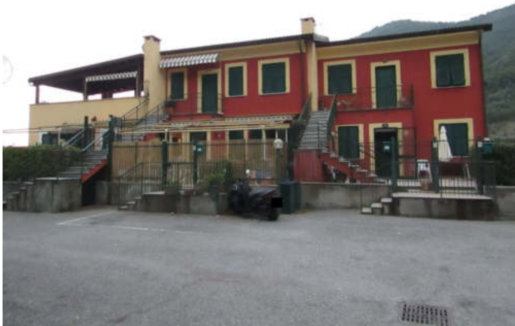
FOTO 5 – PROSPETTO FABBRICATO “A” DAL PIAZZALE ONDOMINIALE
