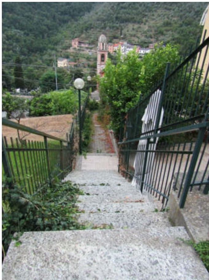
FOTO 7 – SCALA DI ACCESSO ALL'APPARTAMENTO DAL PIAZZALE
