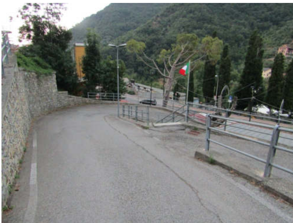
FOTO 2 – STRADA DI ACCESSO DALLA STRADA PROVINCIALE
