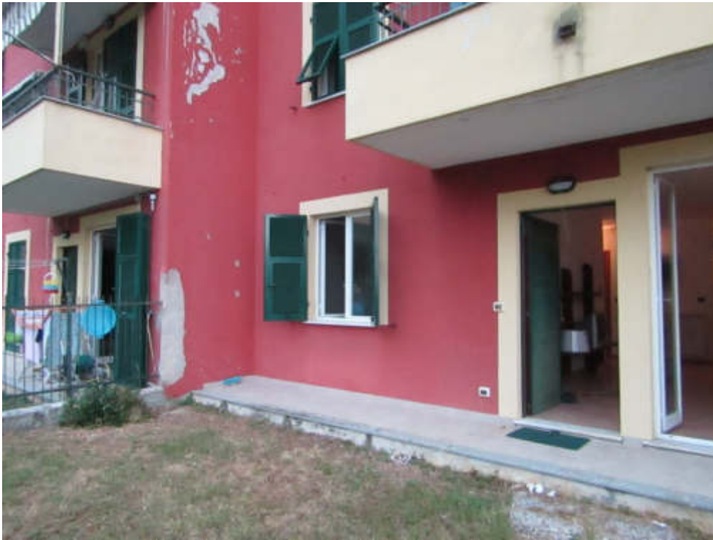
FOTO 15 – PORTONCINO DI INGRESSO E FINESTRA CAMERA SUL GIARDINO
