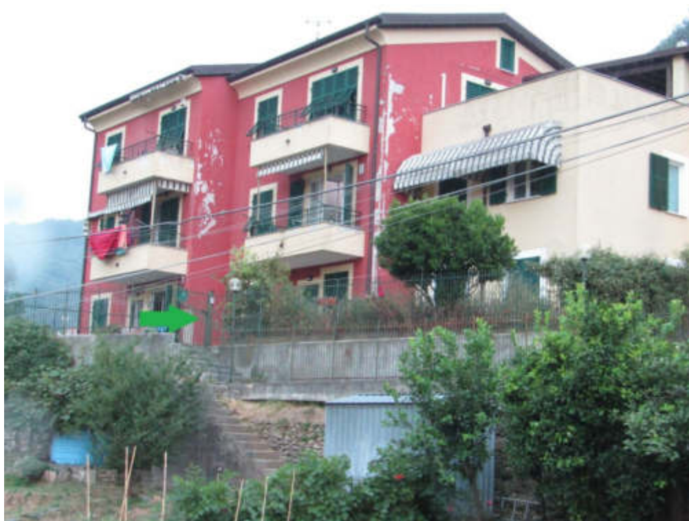
FOTO 8 – PROSPETTO FABBRICATO "A"
