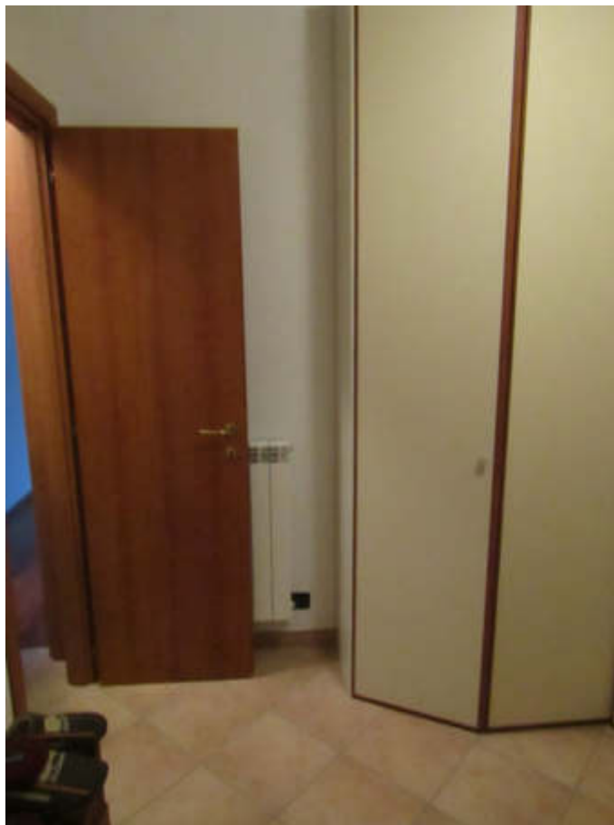
FOTO 30 – LOCALE AD USO LAVANDERIA
