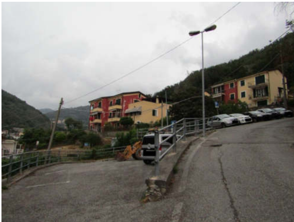
FOTO 1 – VISTA FABBRICATO “A” E FABBRICATO “B” DI PIAZZA BORSELLINO
