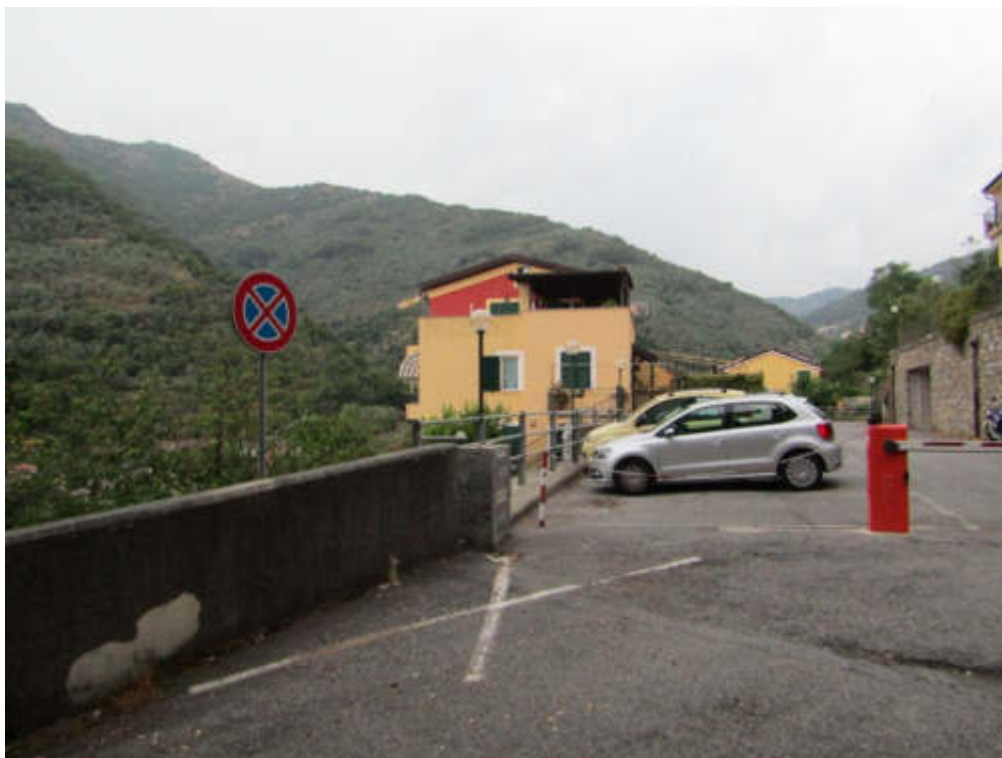
FOTO 3 – PROSPETTO LATERALE FABBRICATO “A”
