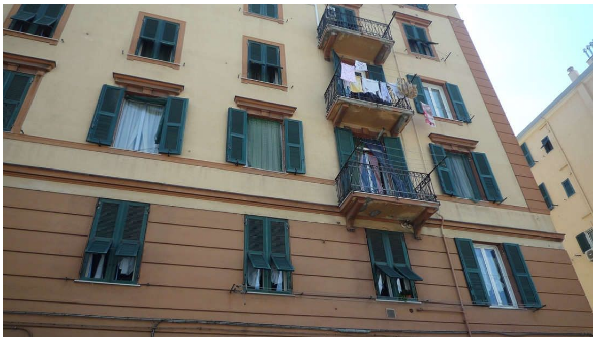
Prospetto principale Est – Piano oltre il bugnato (2° piano) vista delle 4 finestre e del balcone appartamento int. 13 – particolare - Fotografia 5
