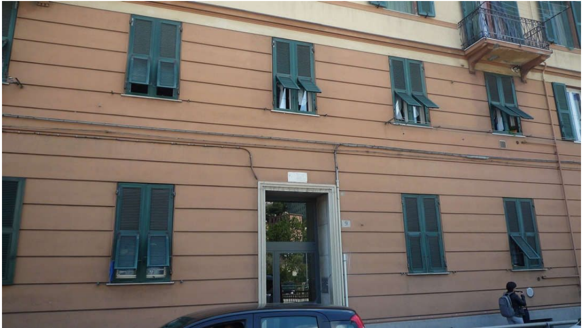
Prospetto di accesso Est – Particolare del portone -Fotografia 3
