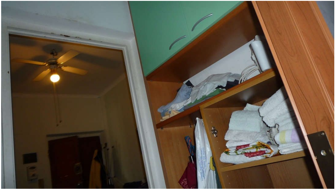
Vista del disimpegno verso l'ingresso - Fotografia 23
