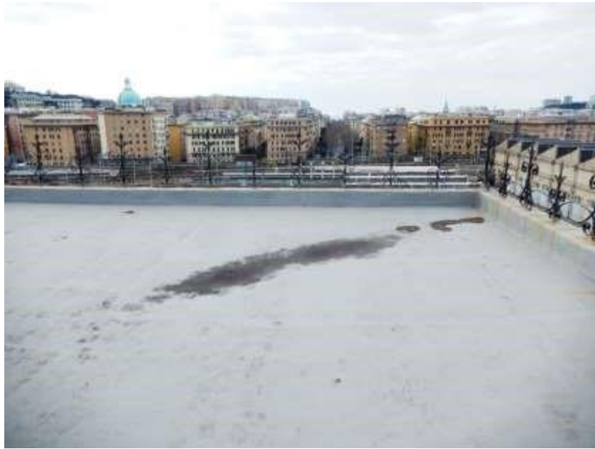
FOTOGRAFIA n. 9 - Terrazza di copertura
