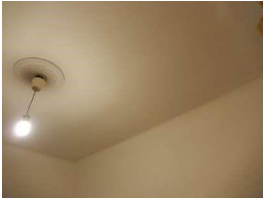
FOTOGRAFIA n. 24 - Camera centrale sud
