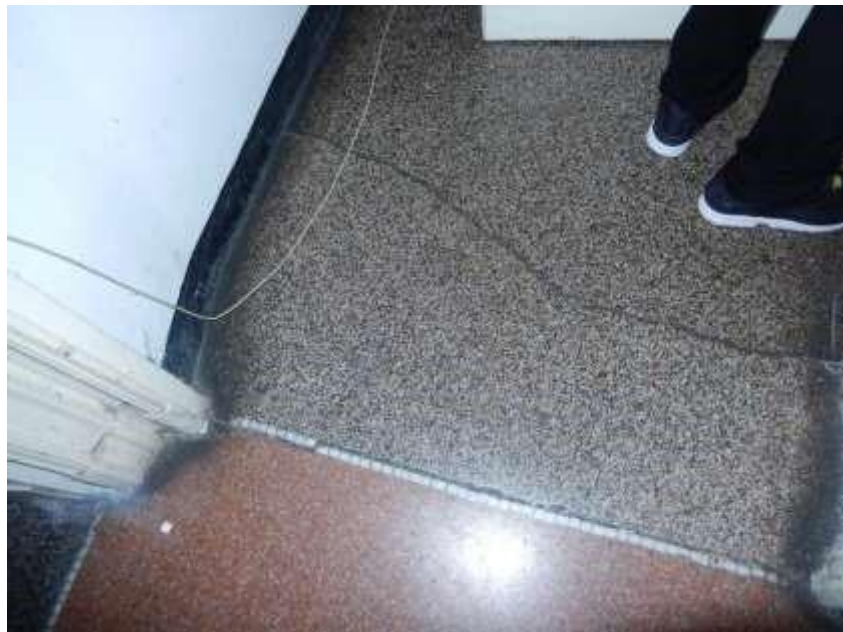
Fotografia n. 37 - Camera sud lato ovest
