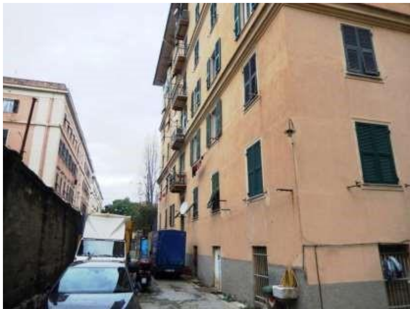
FOTOGRAFIA n. 6 - Retro dell'edificio di Via Giacometti 3
