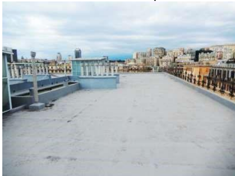
FOTOGRAFIA n. 10 - Terrazza di copertura
