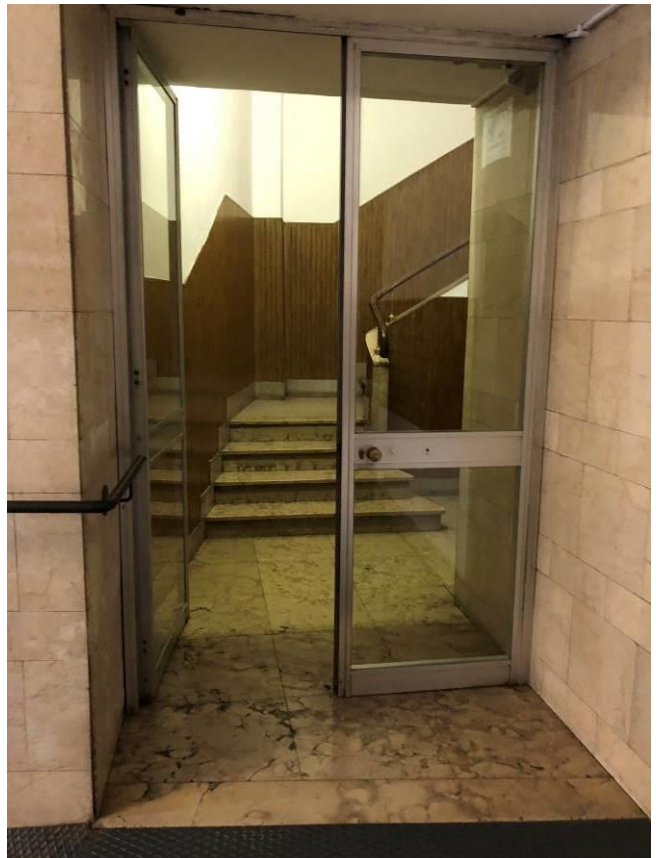
Foto 8 - Vista dell'androne di ingresso alla scala
