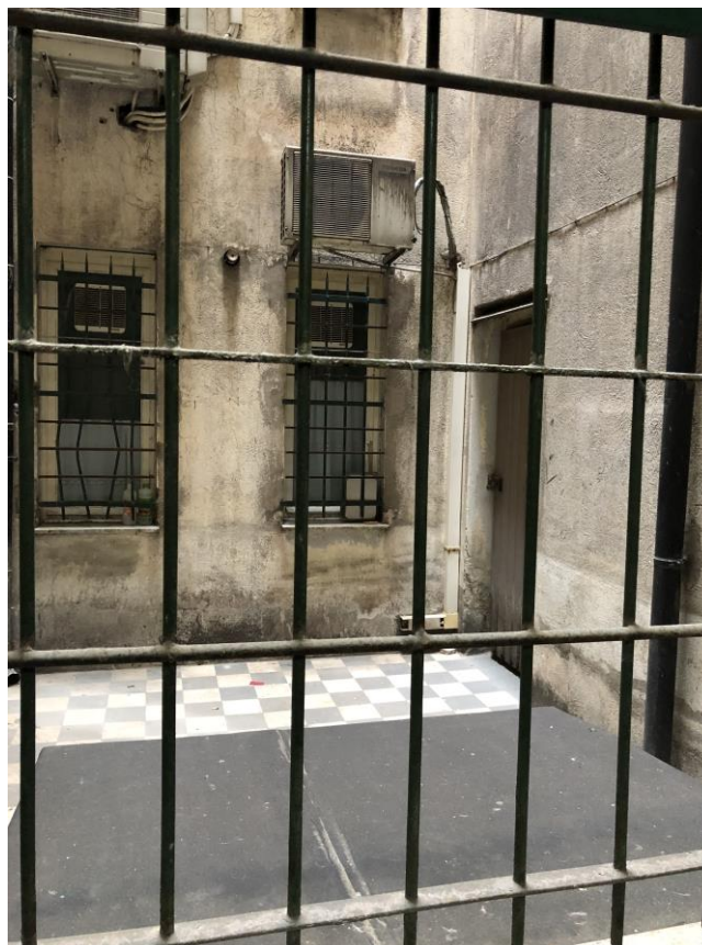
Foto 18 - Vista del cavedio interno
