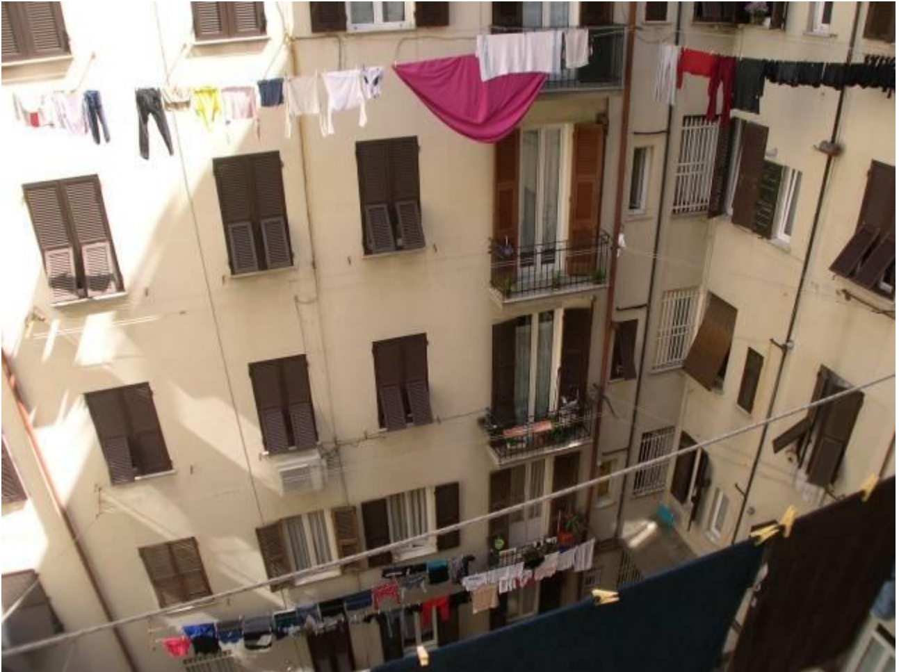
Foto 23 – Vista della corte interna dal balcone dalla cucina
