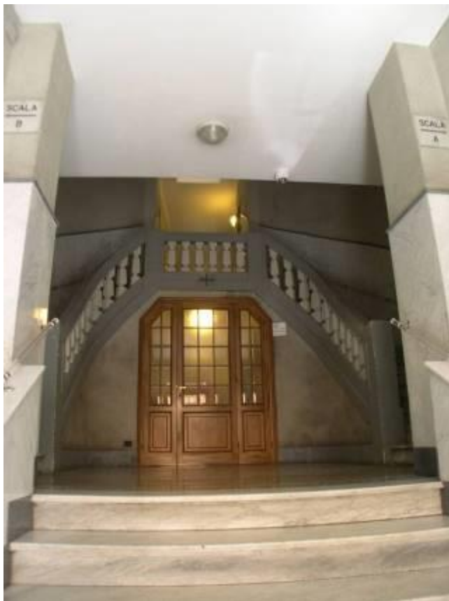
Foto 12 – Atrio di ingresso su strada
