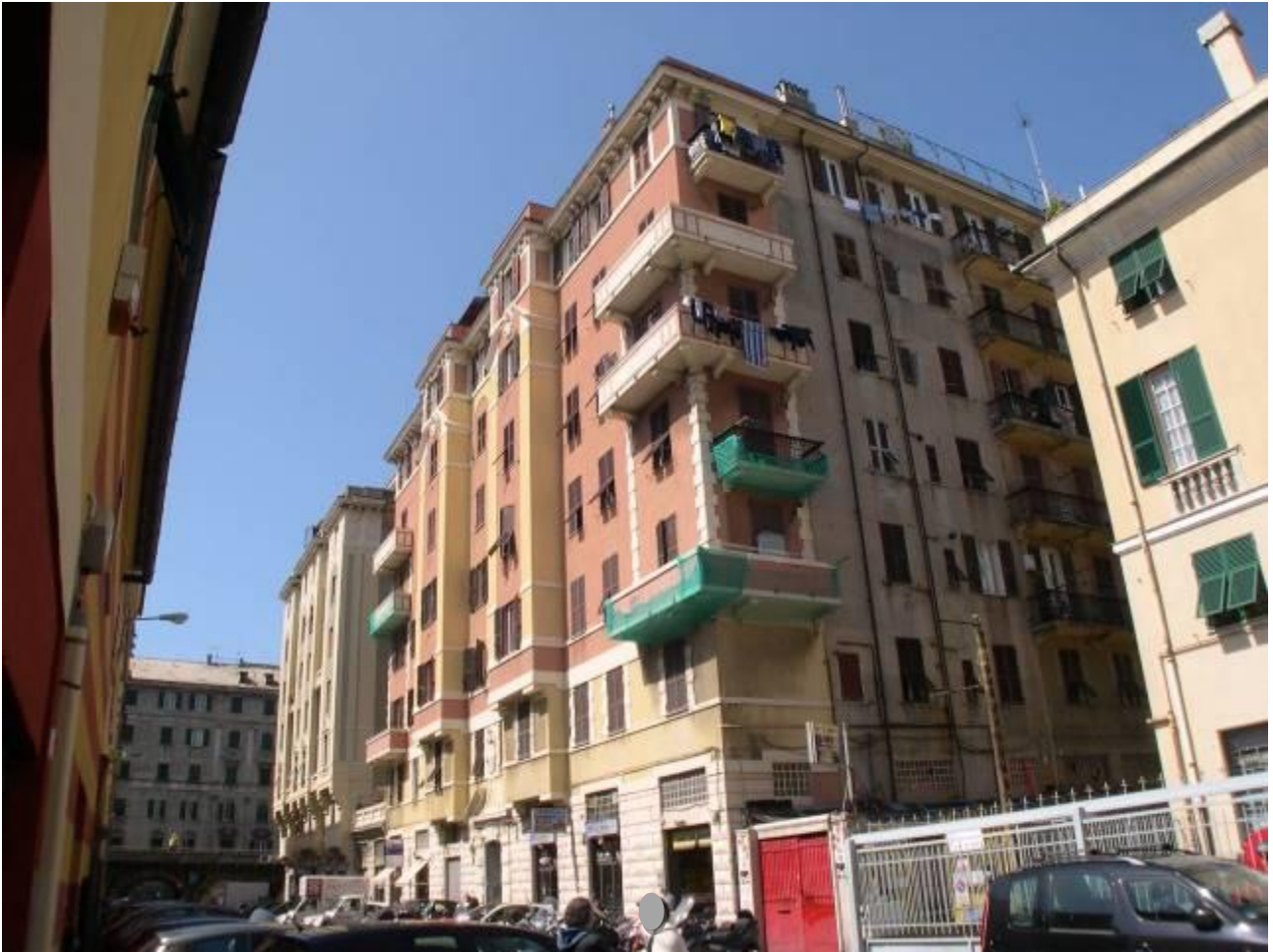
Foto 6 – Vista del condominio di Via Agostino Castelli, 4
