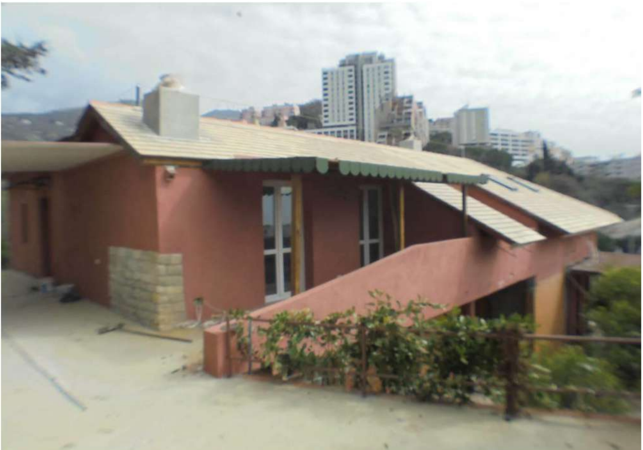
Foto 56 – Vista da monte dell'alloggio Lotto "C"
