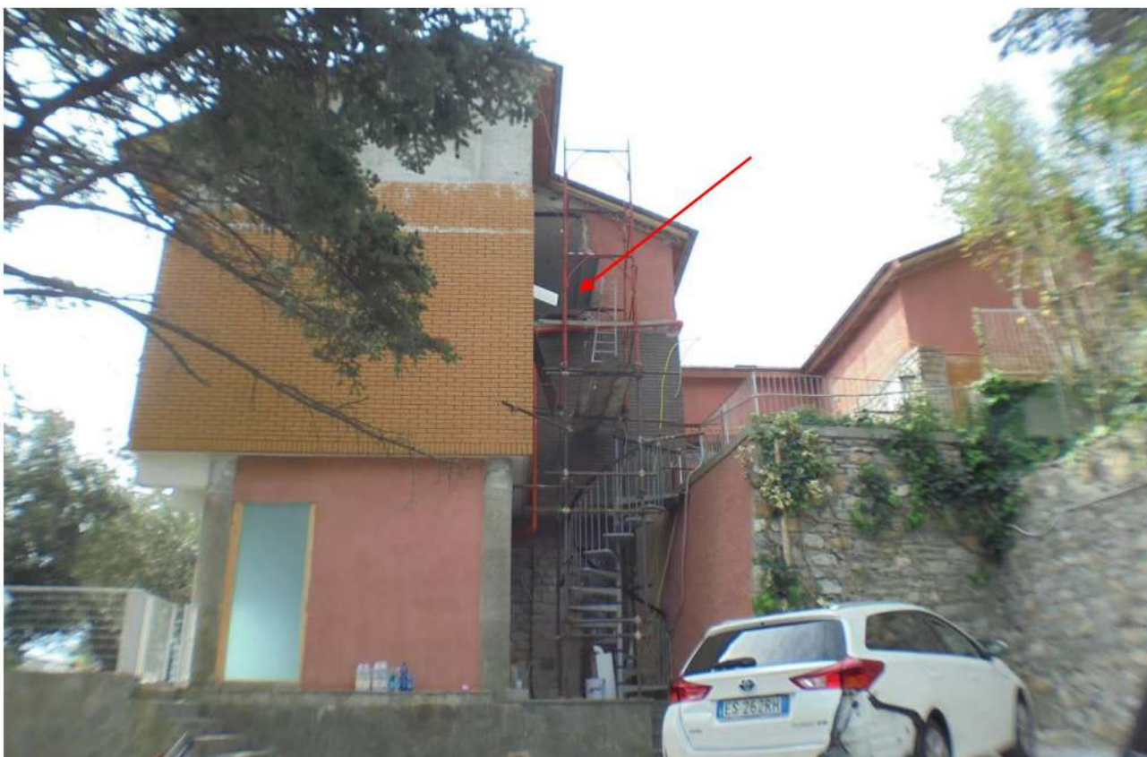
Foto 9 – Vista di dettaglio da monte delle unità abitative
