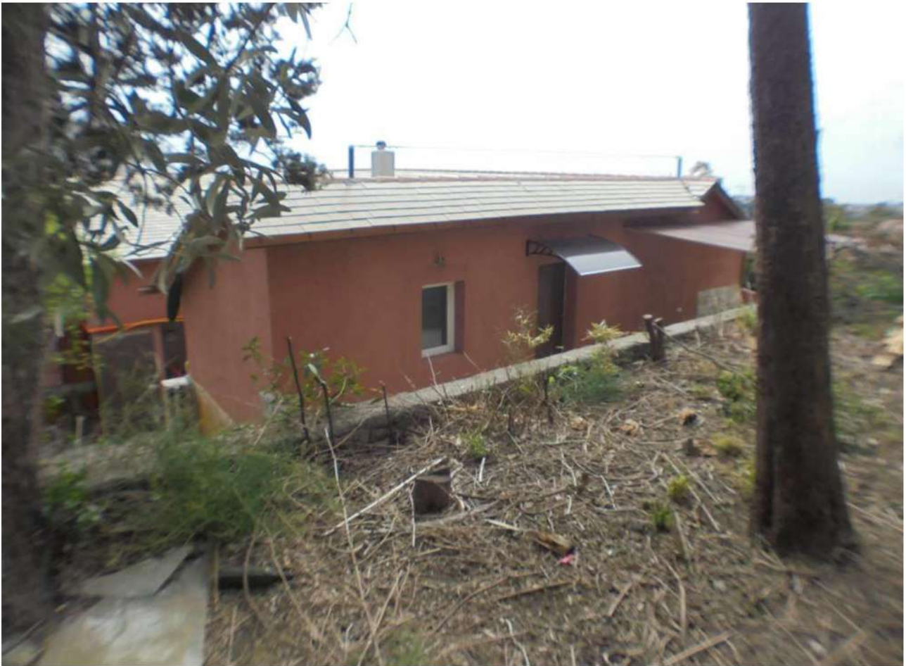
Foto 55 – Vista da monte dell'alloggio Lotto "C"
