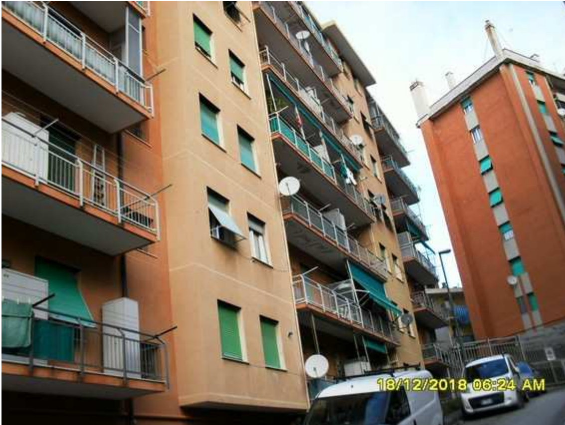
Foto 1: Prospetto est dell'edificio
