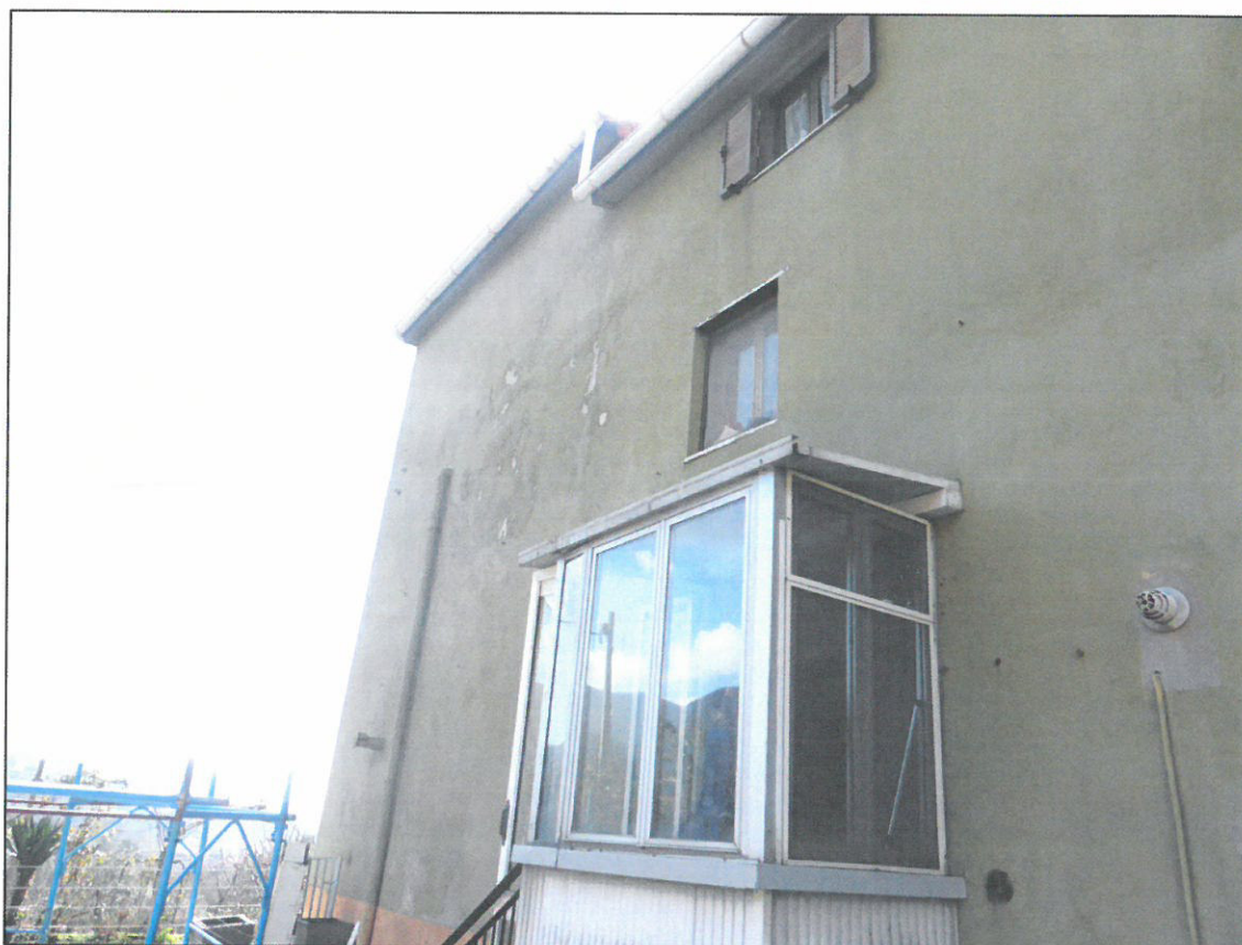
VERANDA D'ACCESSO AL VANO SCALA
