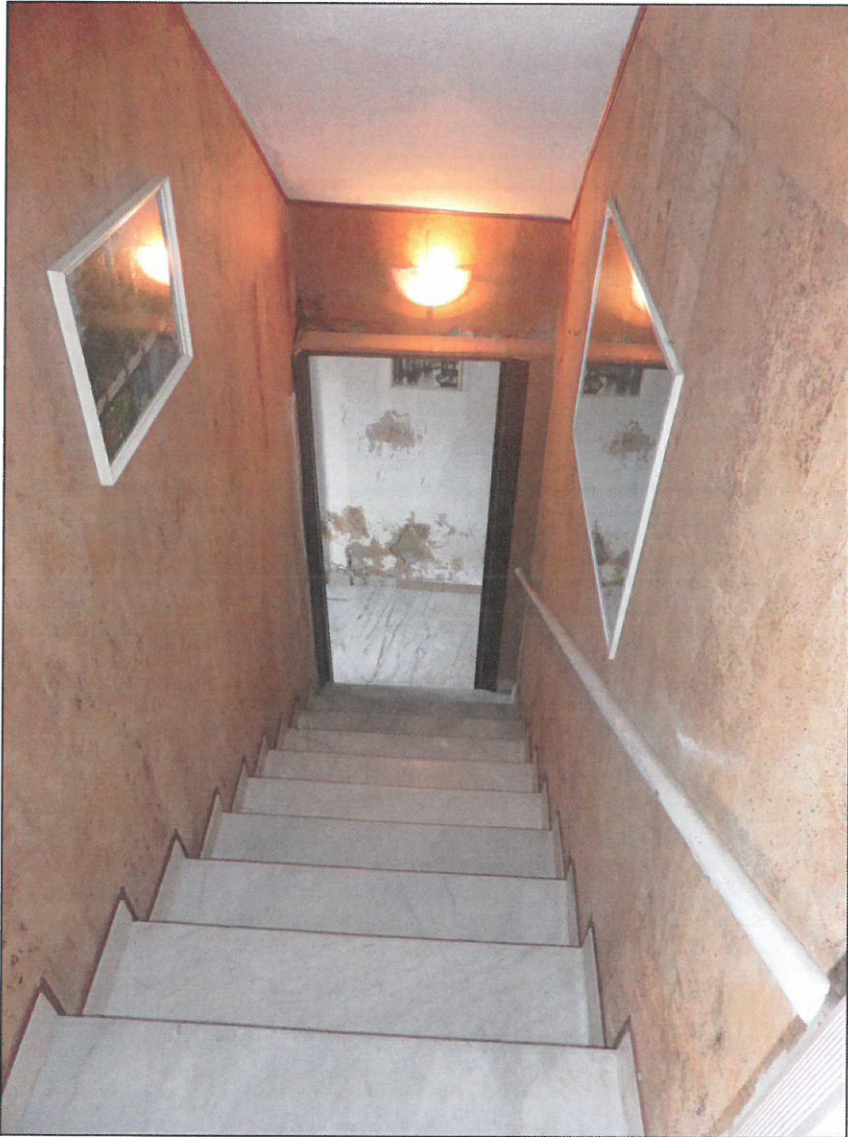
VANO SCALA COMUNE
