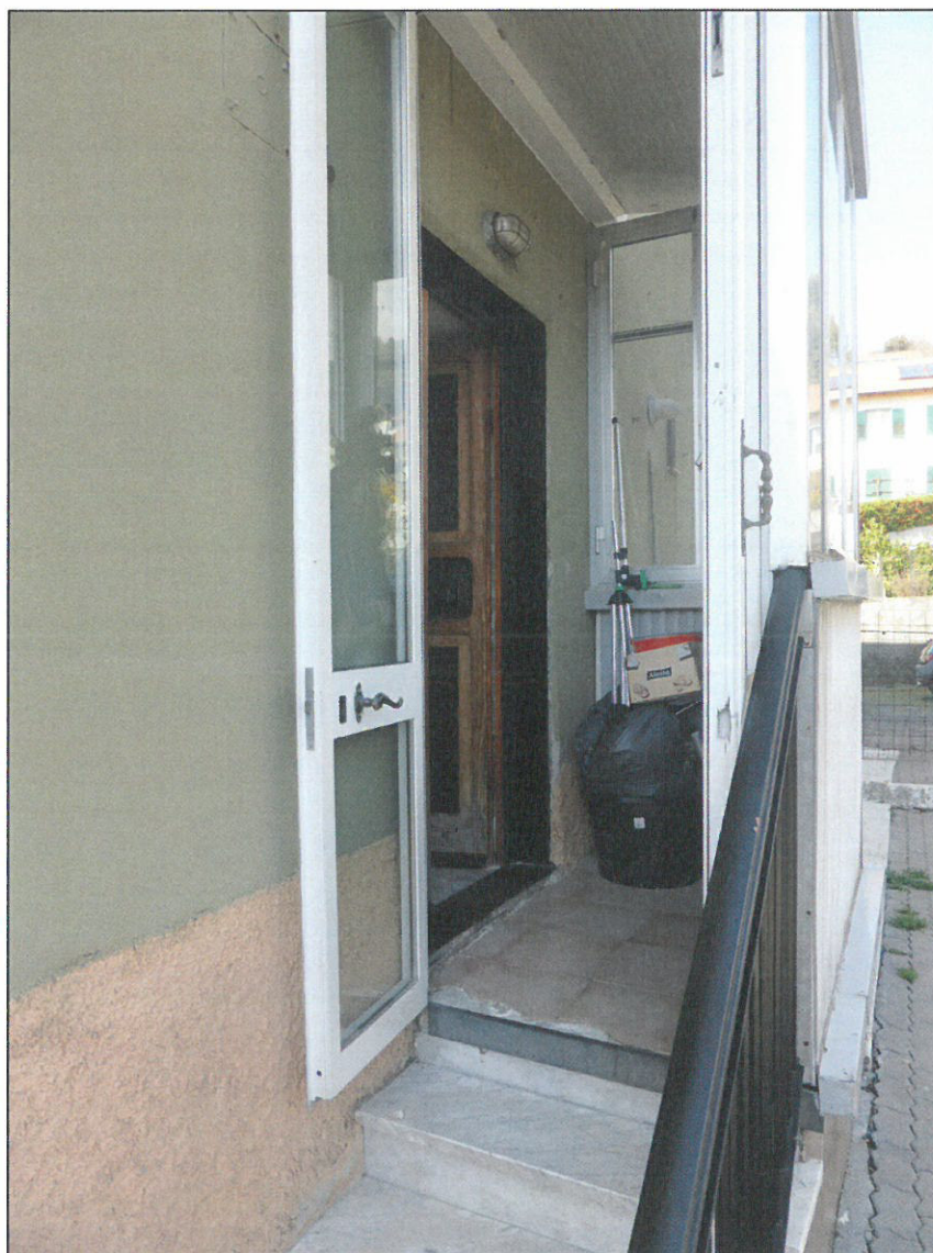
VERANDA D'ACCESSO AL VANO SCALA
