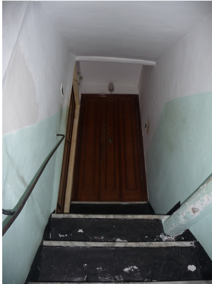
Foto n 3 Vista su porta di ingresso dell'appartamento da scala condominiale.
