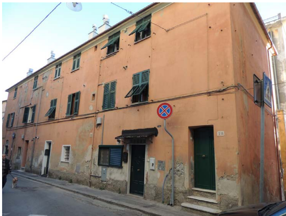
Foto n 2 Vista sull 'edificio sito in Via Sapello n. 28 - Genova Prà. Prospetto Nord Ovest
