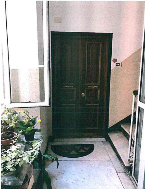
Foto 8— vista dell'ingresso all'appartamento dal pianerottolo.
