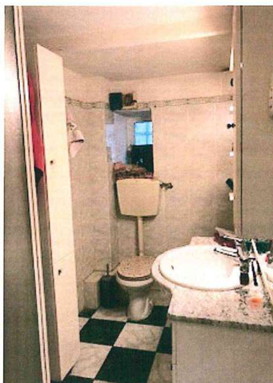
Foto 18—vista del bagno verso nord-ovest..
