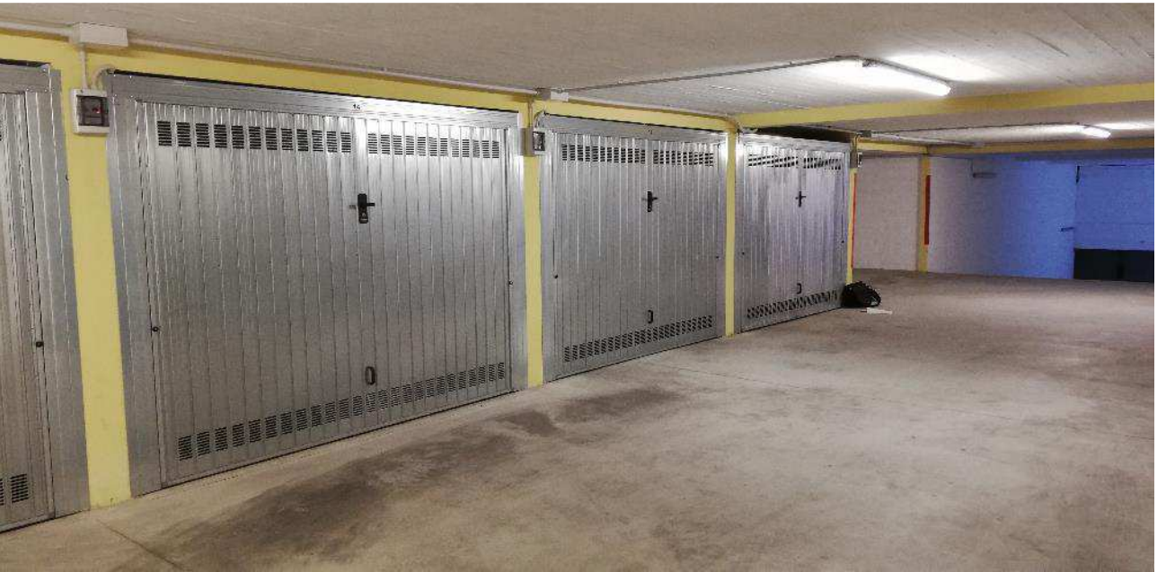
VISTA AREA DI MANOVRA
