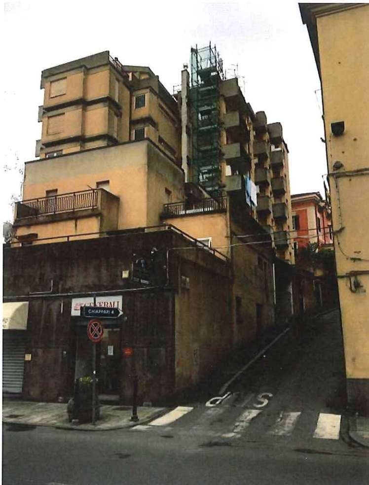
Foto 1) Vista angolo Via V Veneto- Via Martiri di Voltaggio
