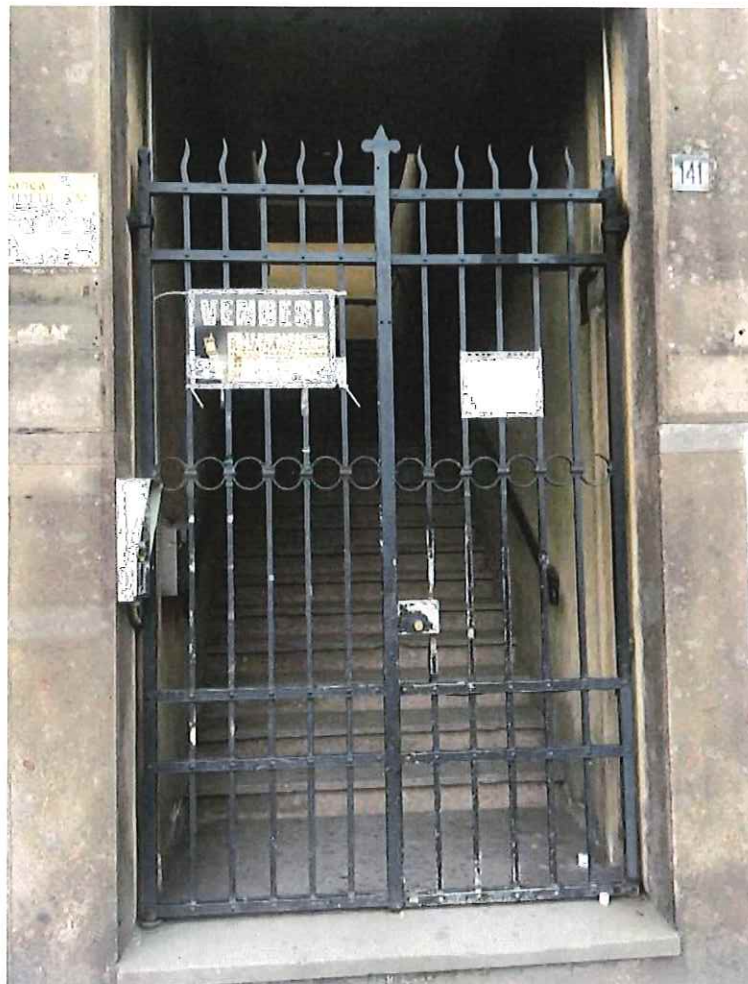
Foto 2) Ingresso da Via V. Veneto
