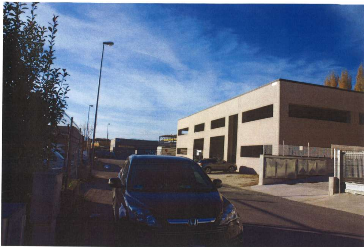
foto n.5- Vista edifici presenti nella via
