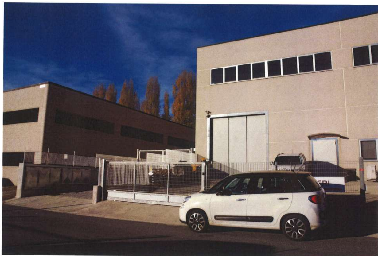
foto n.6- Vista edifici presenti nella via
