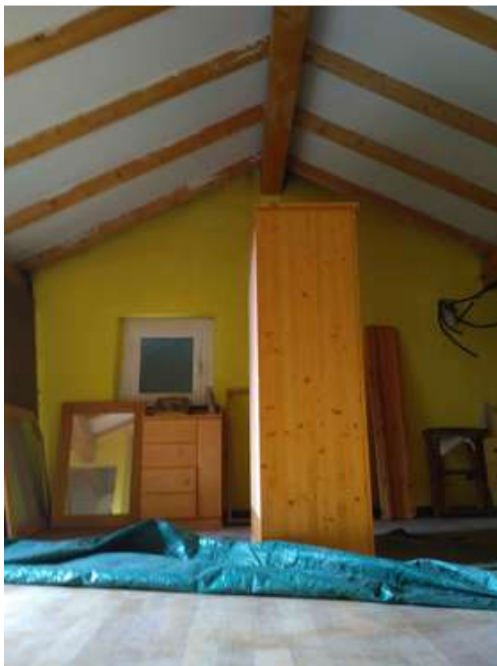
Viste interne: locale sottotetto
