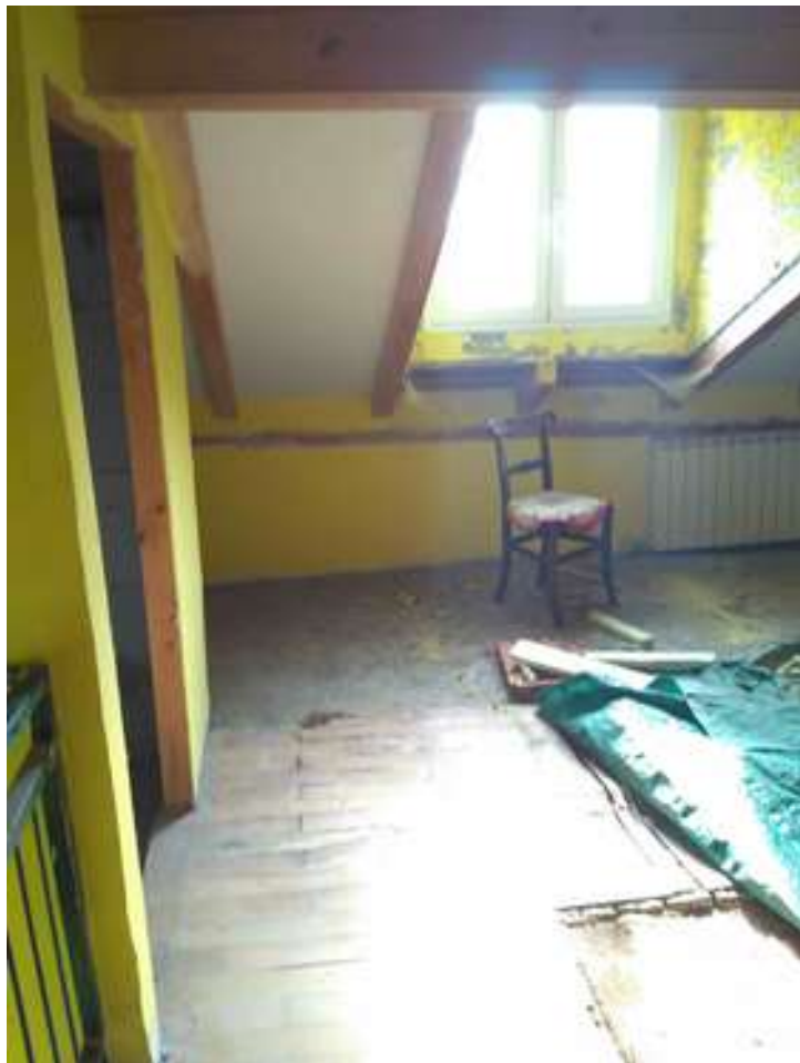
Viste interne: locale sottotetto
