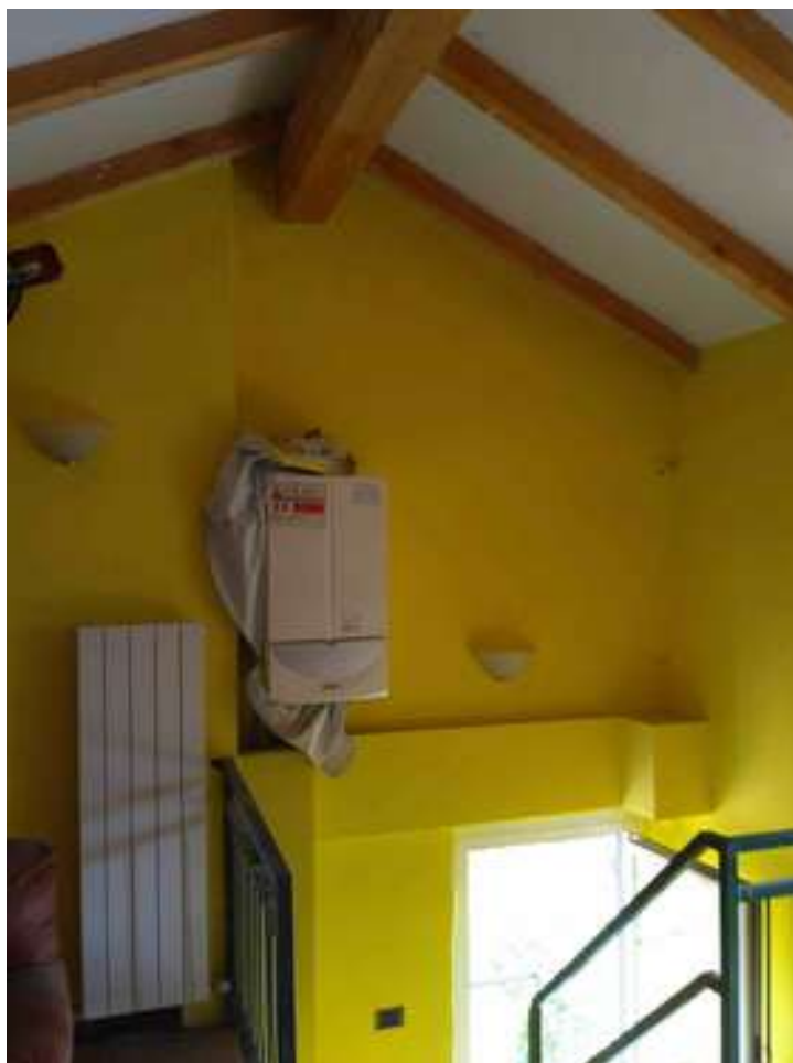
Viste interne: locale sottotetto
