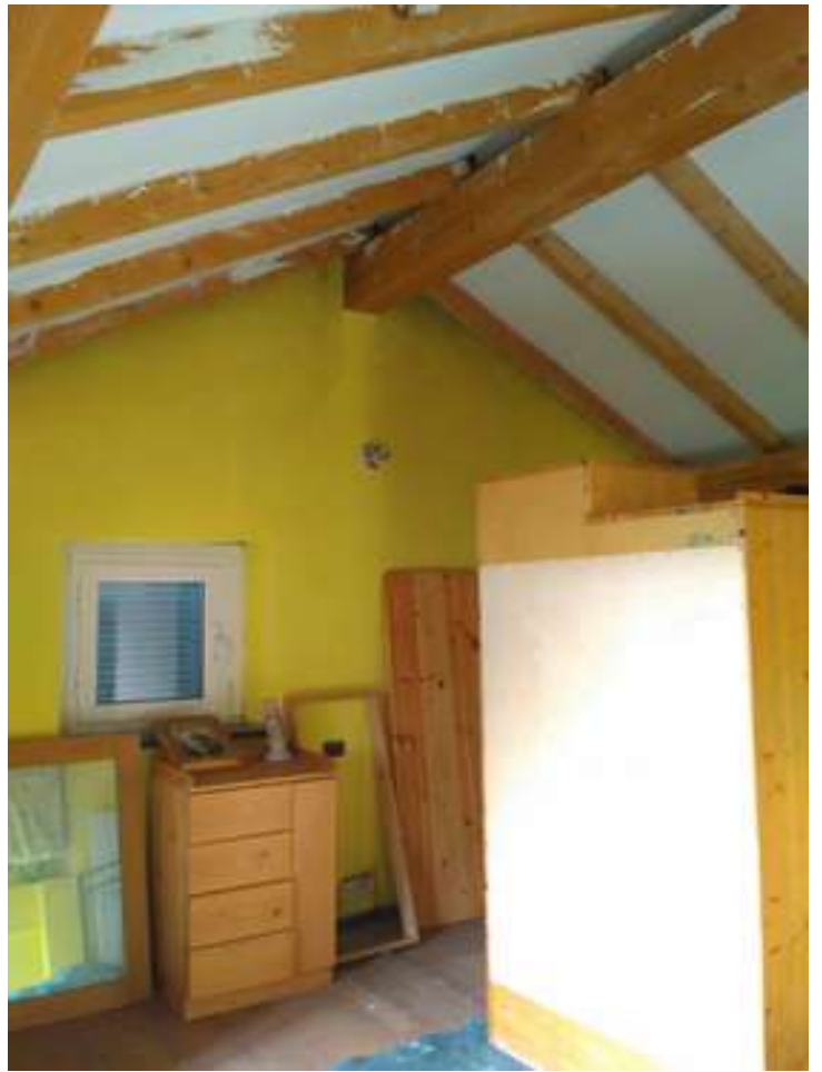
Viste interne: locale sottotetto
