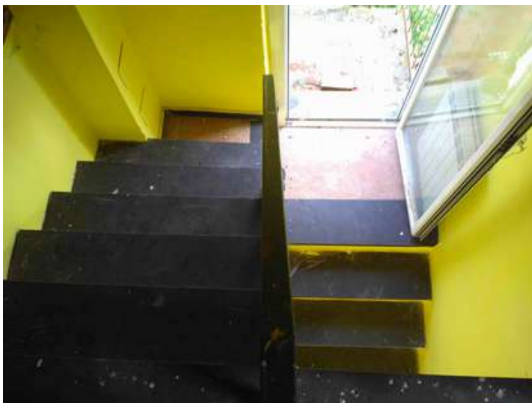
Viste interne: locale sottotetto
