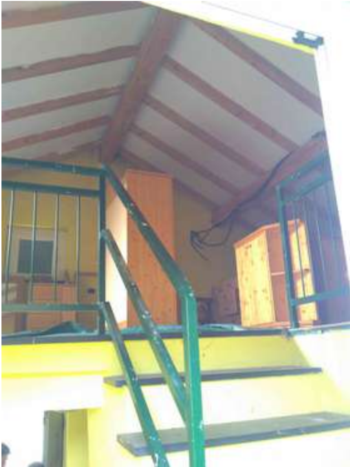
Viste interne: scala verso sottotetto
