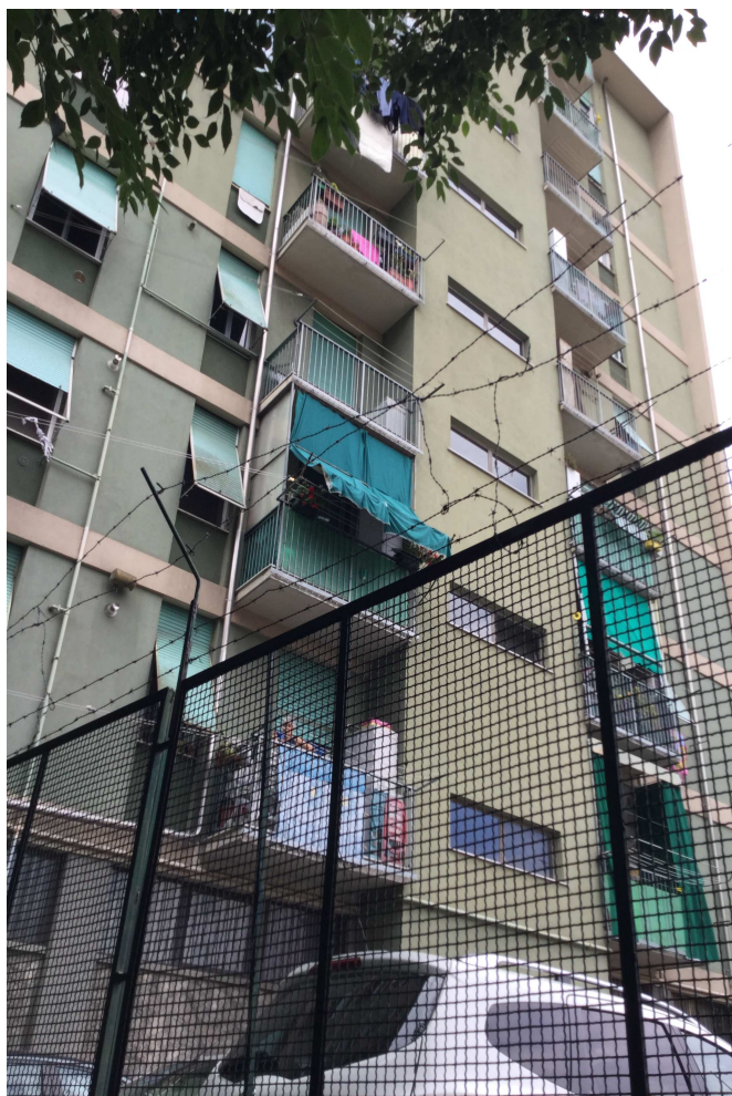
Foto 5- Facciata lato opposto all'ingresso al civico
