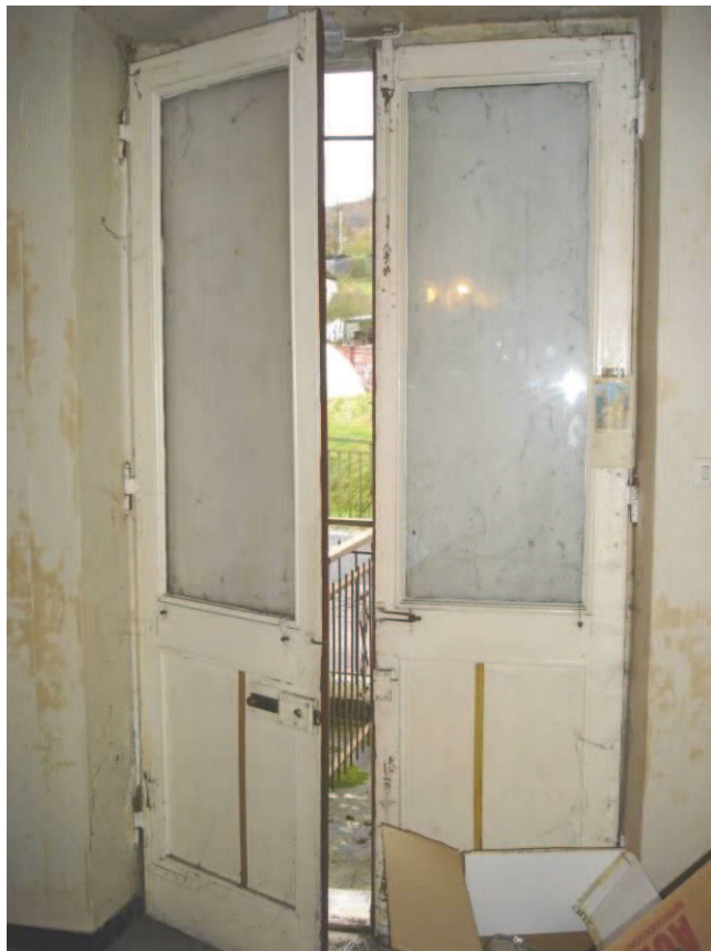
Vista della porta di ingresso (dall'interno)
