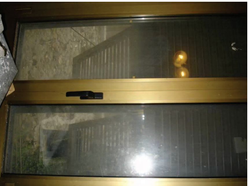
Particolare della finestra della camera da letto
