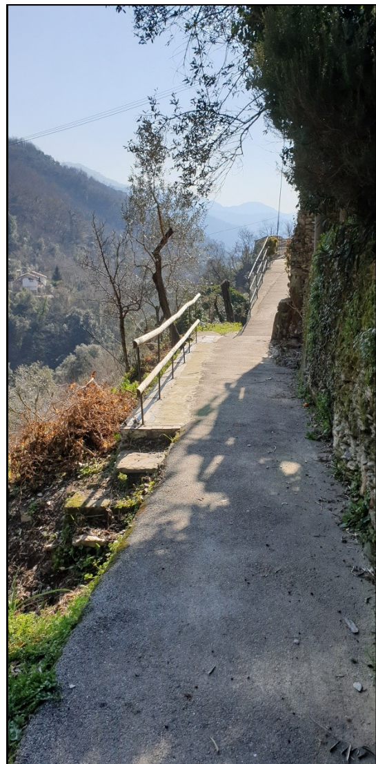
FOTO 3 —STRADA VICINALE (vista verso accesso immobile)
