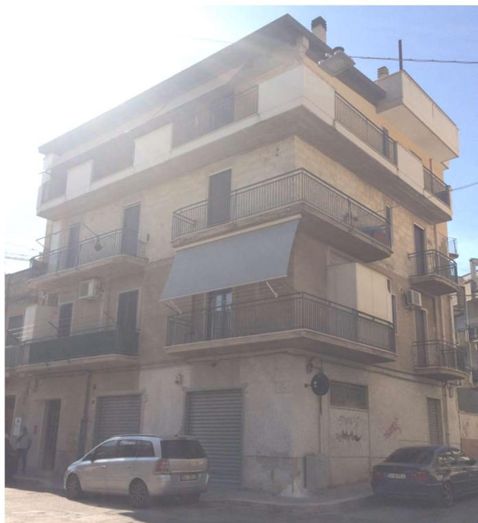
Fig. 1 – vista fabbricato di cui l'immobile è quota parte
