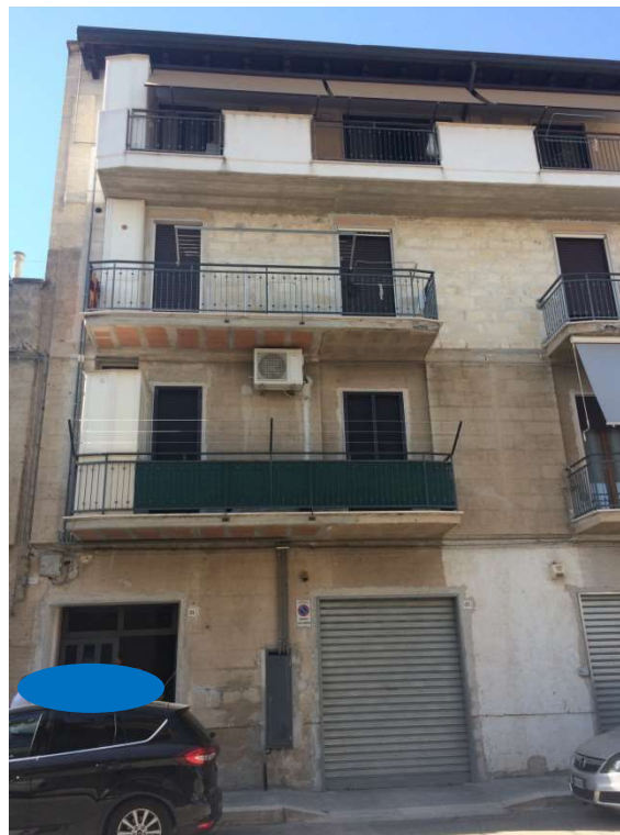
Fig. 9 – Prospetto alla Via Parma
