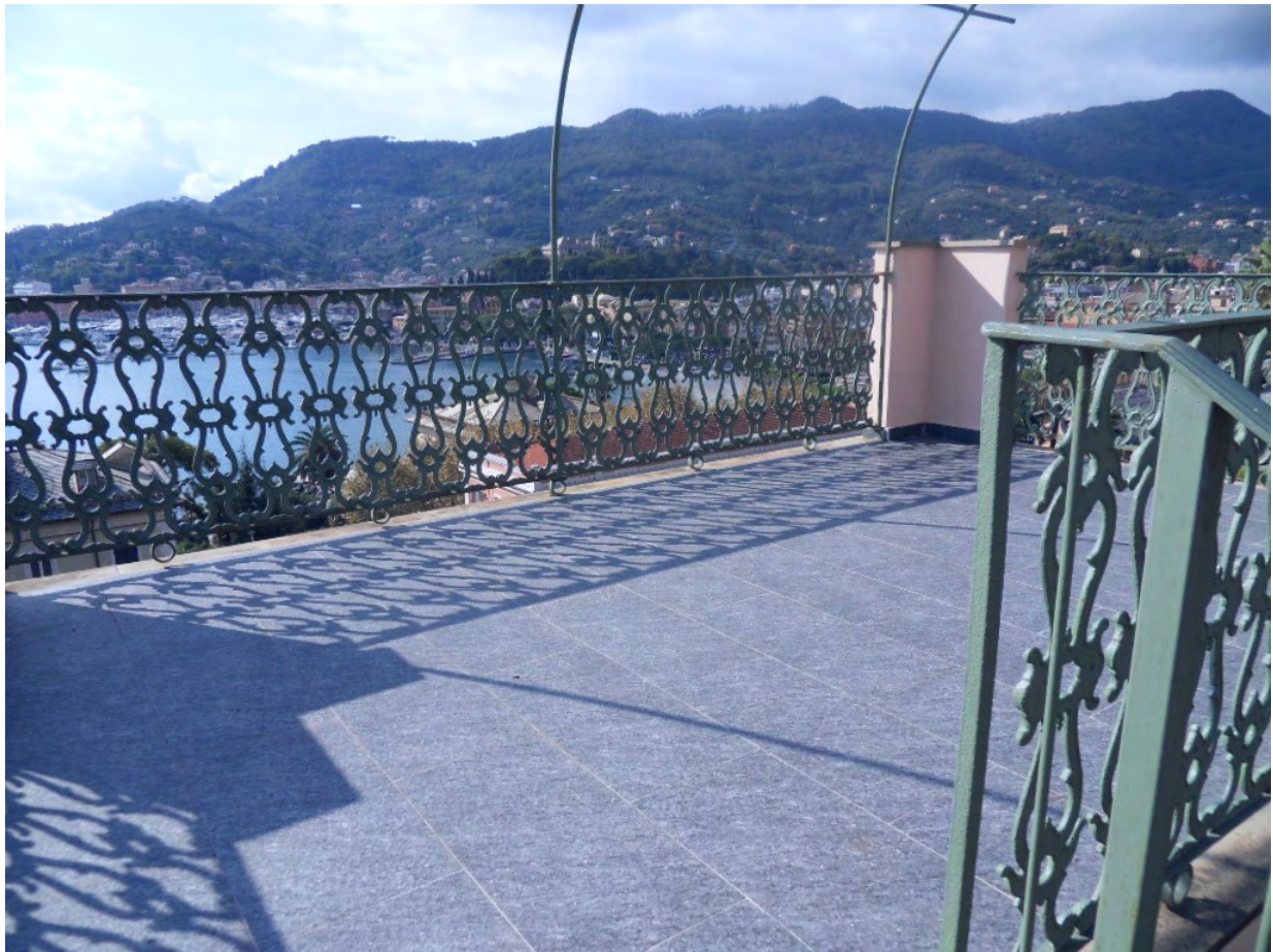
TERRAZZO DI COPERTURA INTERNO 6
