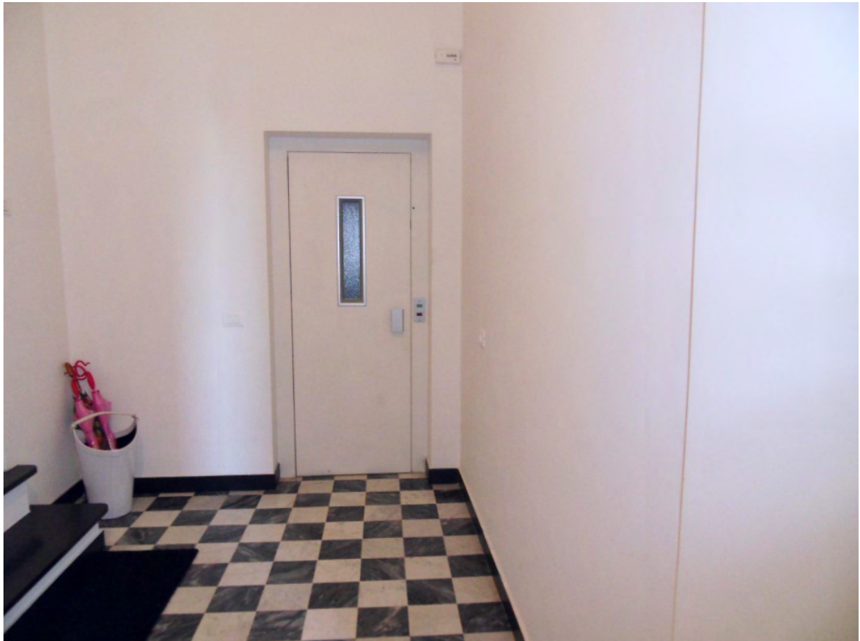
INTERNO VANO SCALE
