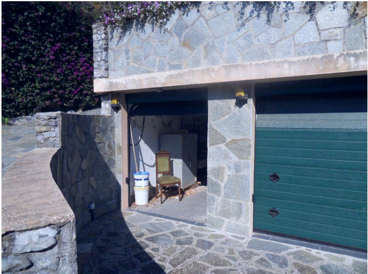
ACCESSO AL MAGAZZINO
