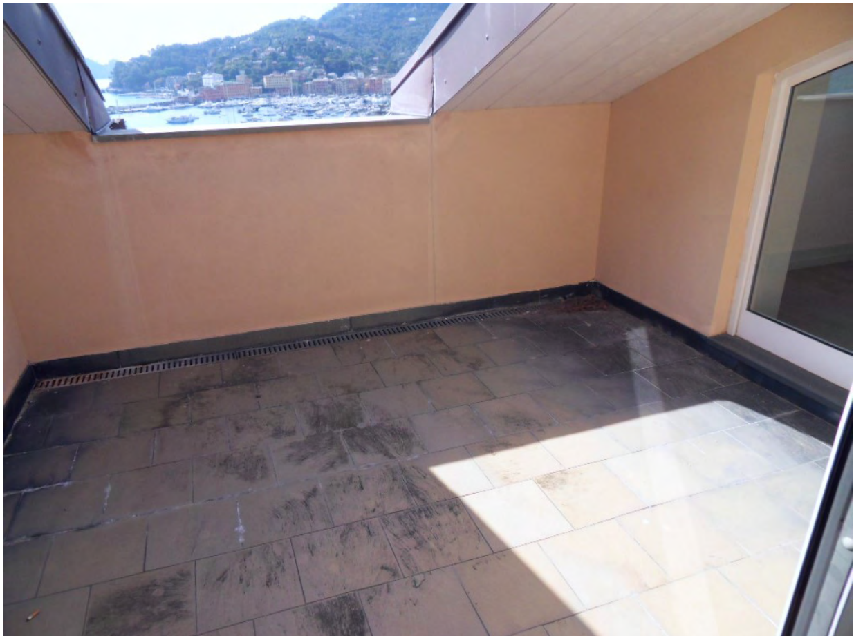
TERRAZZO INTERNO 7, PIANO TERZO
