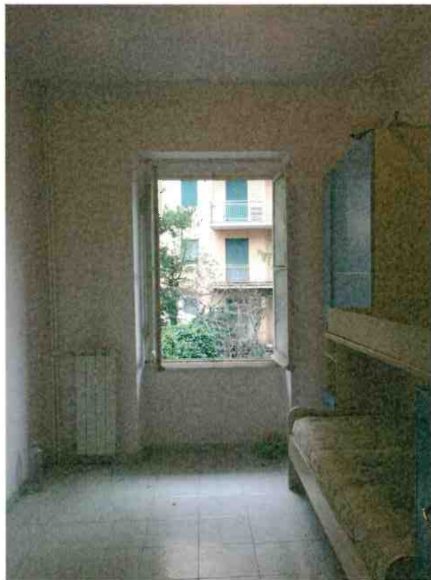
FOTO N. 6 Cameretta adiacente alla cucina.
