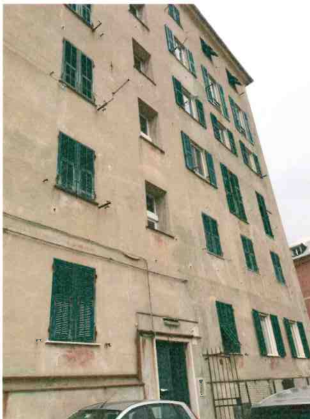
FOTO N. 3 Vista del prospetto est del fabbricato.
