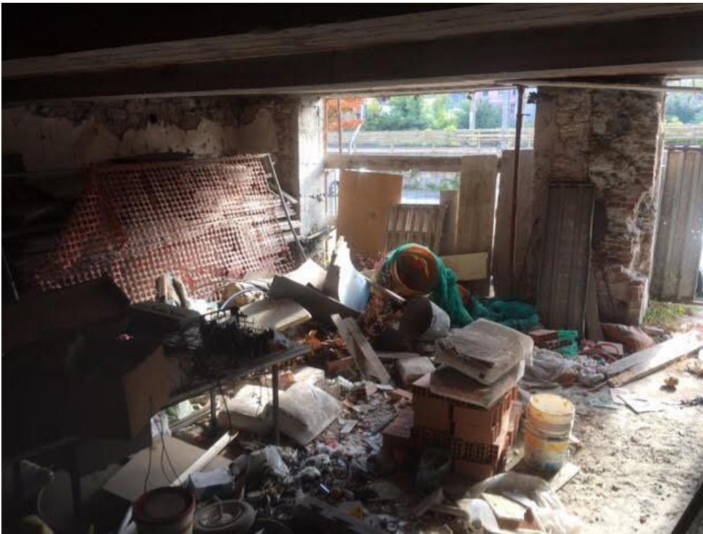
Foto n°6 – Vista interna PIANO TERRA del civ. 20 di Via Roma
