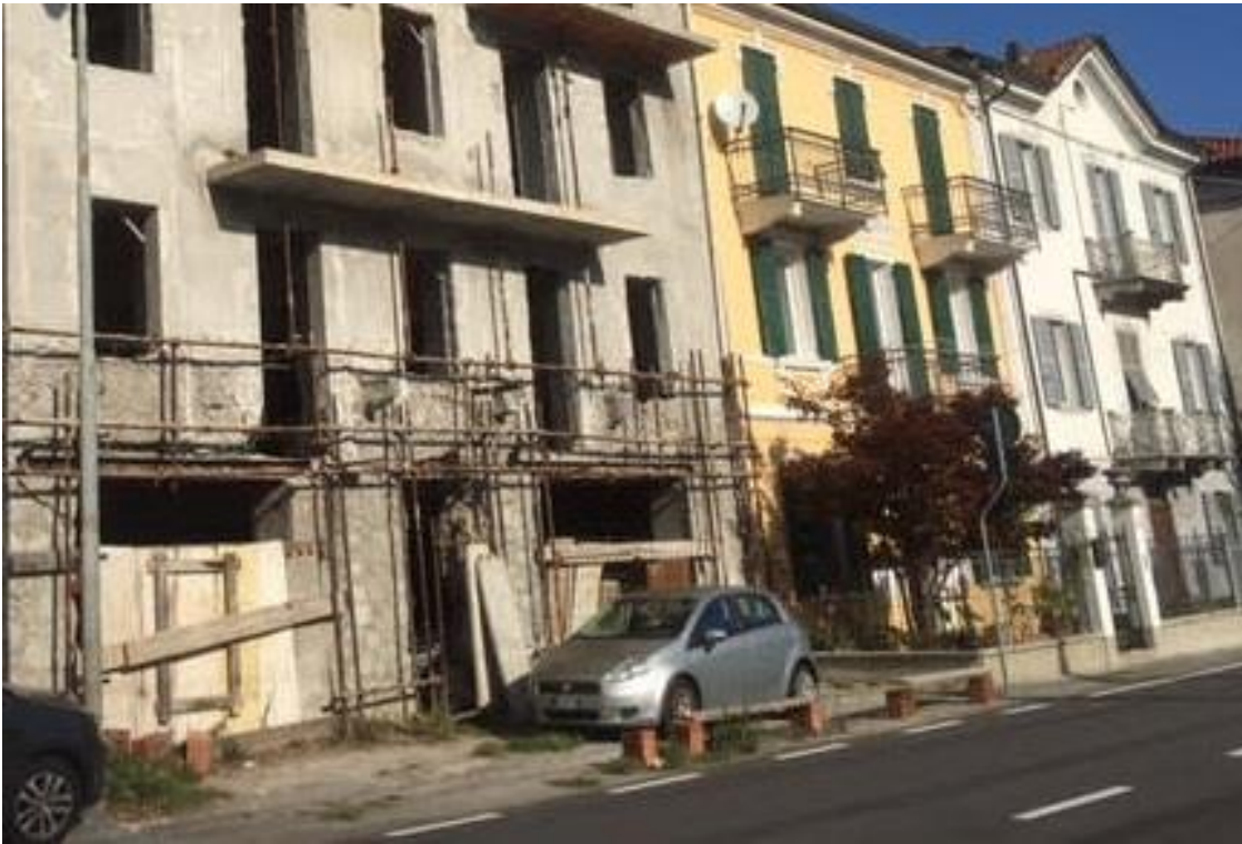
Foto n°3 – Accesso immobile con area pertinenziale esterna verso via Roma
