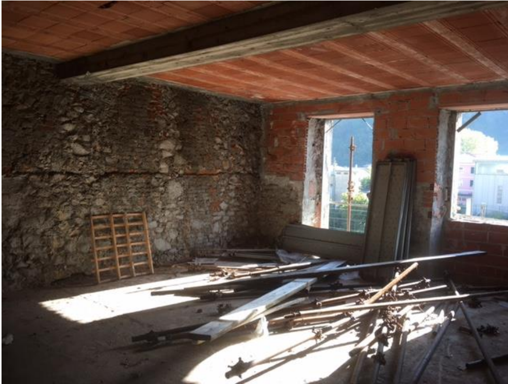
Foto n° 19 – Vista interna PIANO TERZO del civ. 20 di Via Roma
