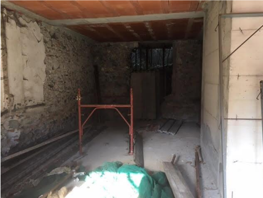
Foto n°11 – Vista interna PIANO PRIMO del civ. 20 di Via Roma
