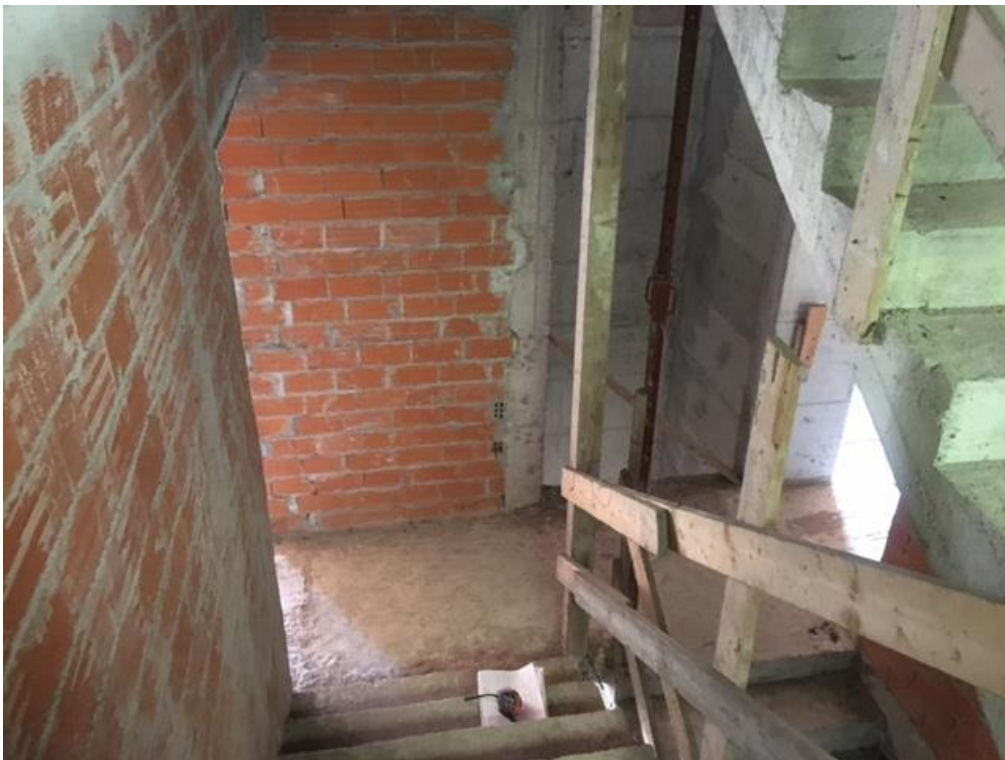
Foto n°26 – Vista interna struttura scale e vano ascensore in c.a. immobile civ. 20 di Via Roma
