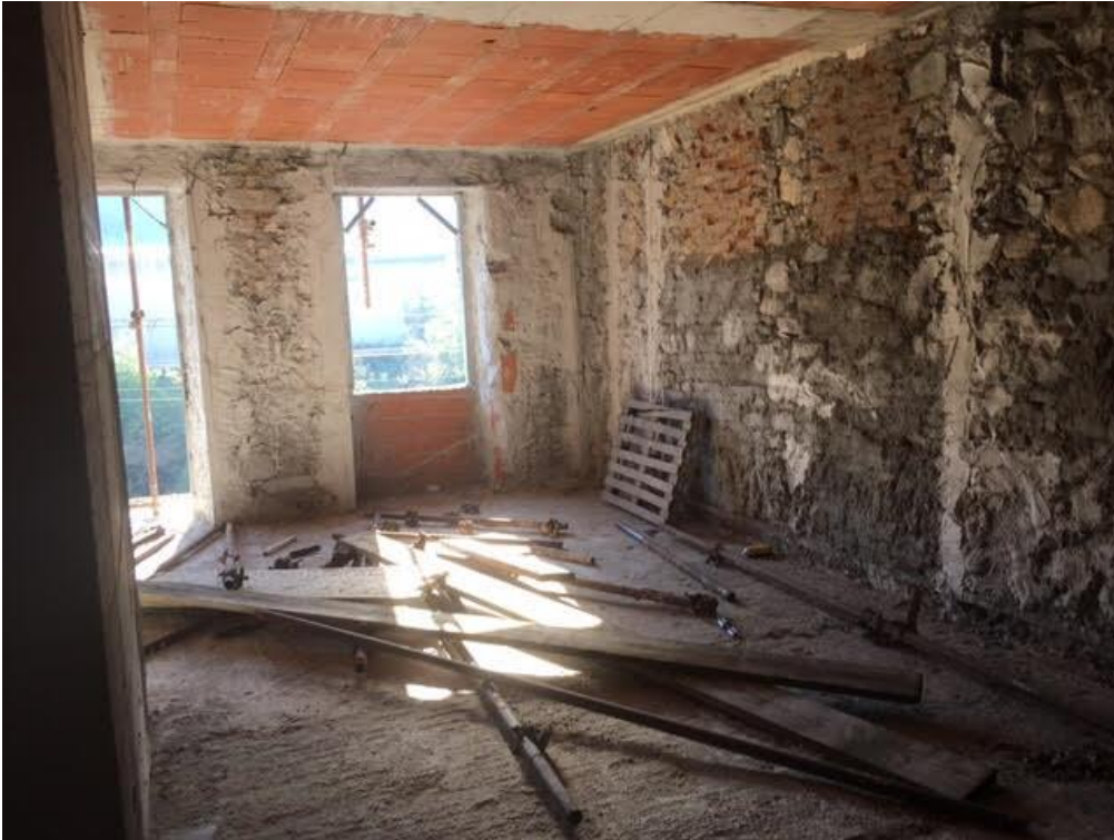
Foto n° 15 – Vista interna appartamento Int. 19 – Piano quarto – veranda
