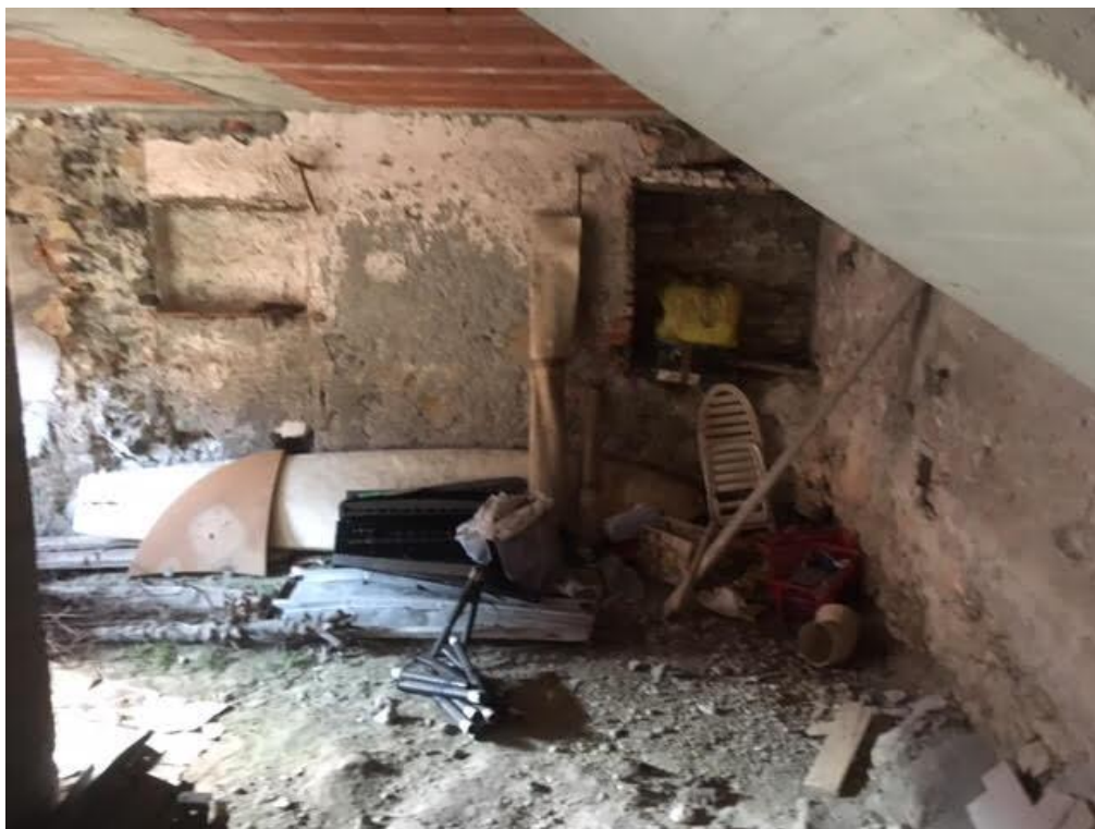
Foto n°7 – Vista PIANO TERRA del civ. 20 di Via Roma
