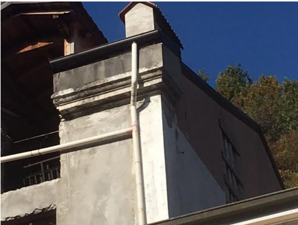
Foto n°4 – Vista esterna particolare copertura, facciata laterale
