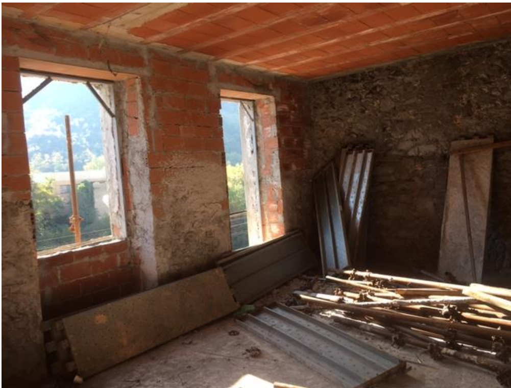
Foto n°20 – Vista interna PIANO TERZO del civ. 20 di Via Roma
