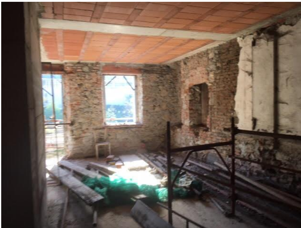
Foto n°10 – Vista interna PIANO PRIMO del civ. 20 di Via Roma
