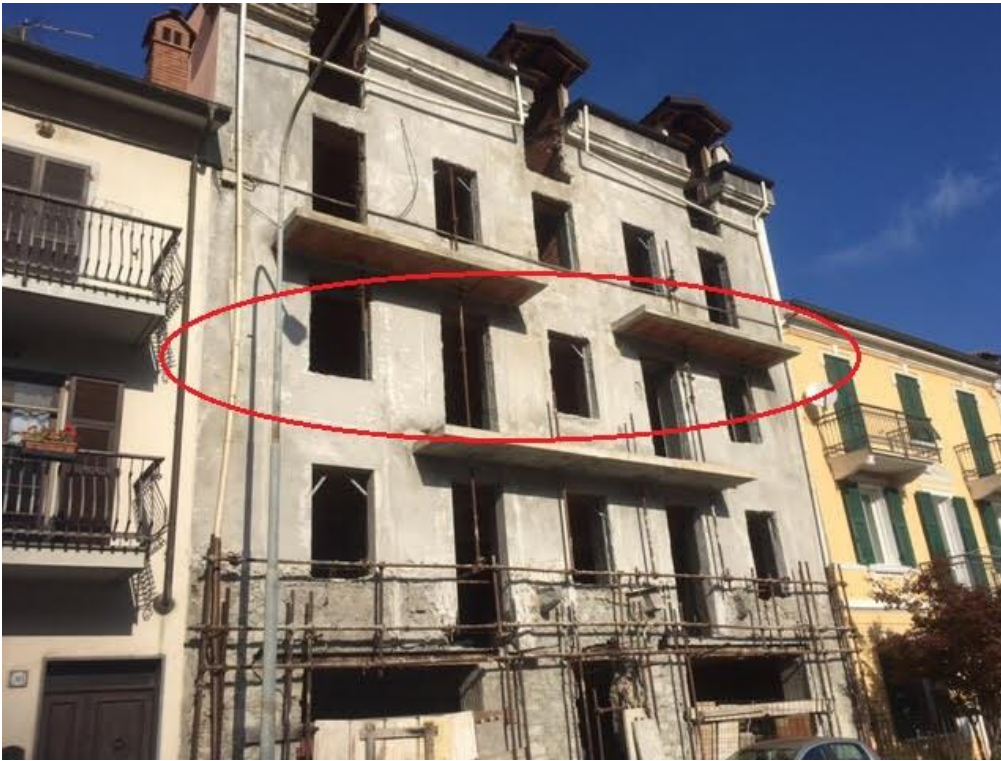
Foto n° 13 – Vista esterna PIANO SECONDO del civ. 20 di Via Roma
