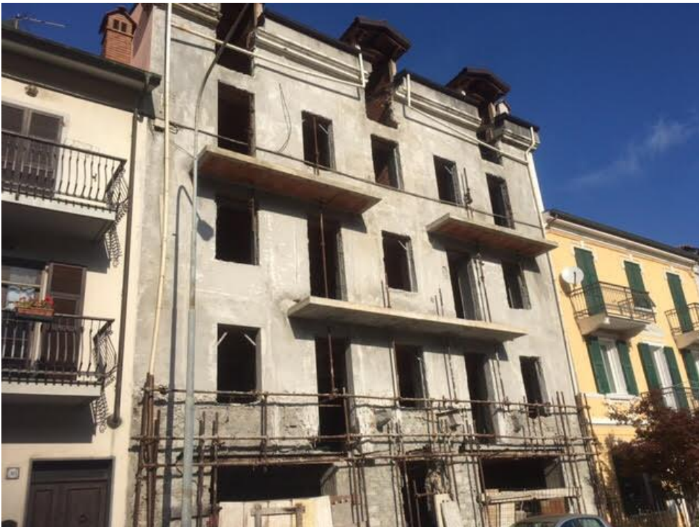
Foto n°2 – Vista esterna immobile civ. 20 di Via Roma in Isola Del Cantone (GE)
