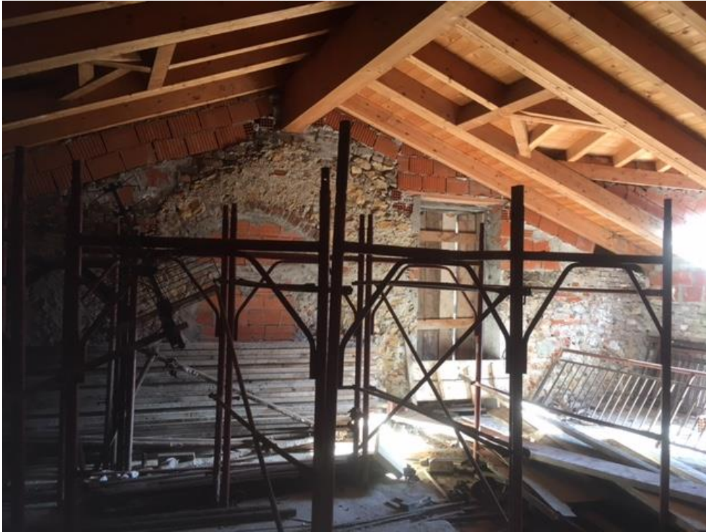
Foto n° 23 – Vista interna PIANO 4° SOTTOTETTO del civ. 20 di Via Roma
