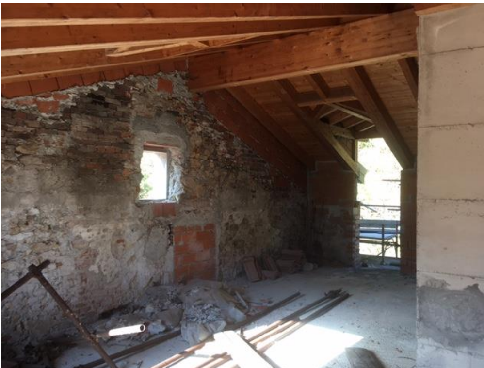
Foto n°22 – Vista interna PIANO 4° SOTTOTETTO del civ. 20 di Via Roma
