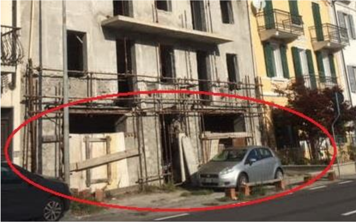
Foto n°5 – Vista PIANO TERRA del civ. 20 di Via Roma
