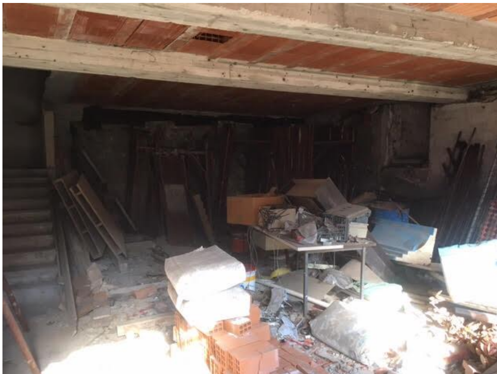
Foto n°8 – Vista interna PIANO TERRA del civ. 20 di Via Roma
