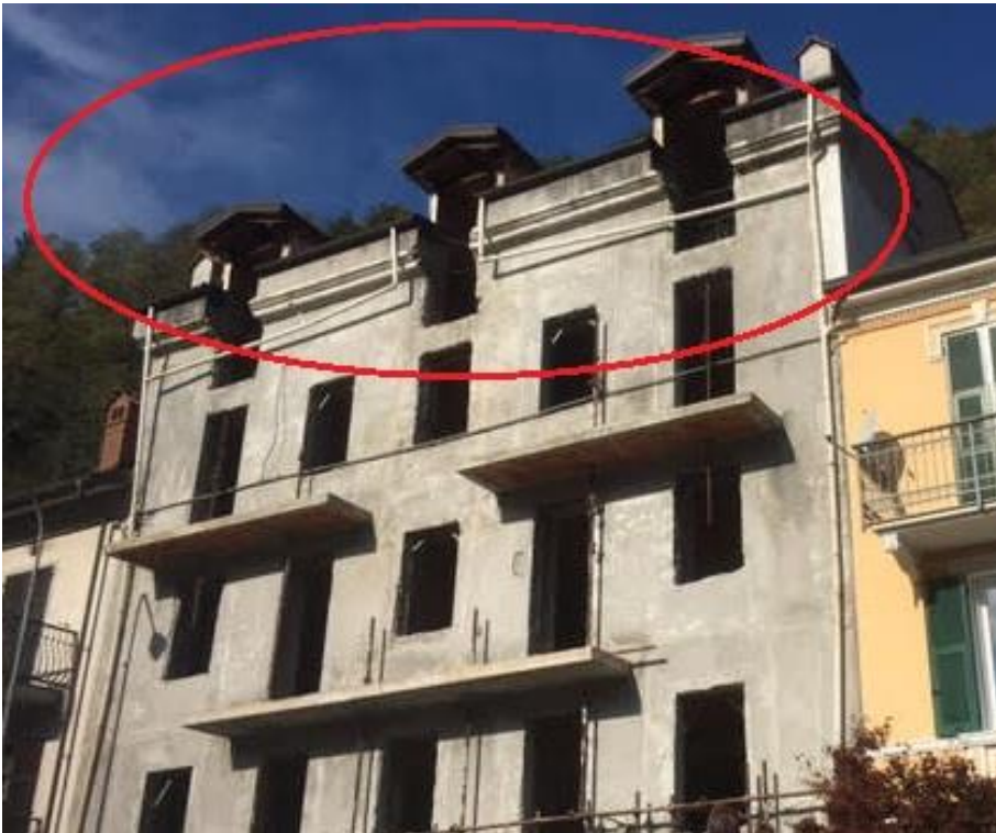
Foto n° 21 – Vista esterna PIANO 4° SOTTOTETTO del civ. 20 di Via Roma
