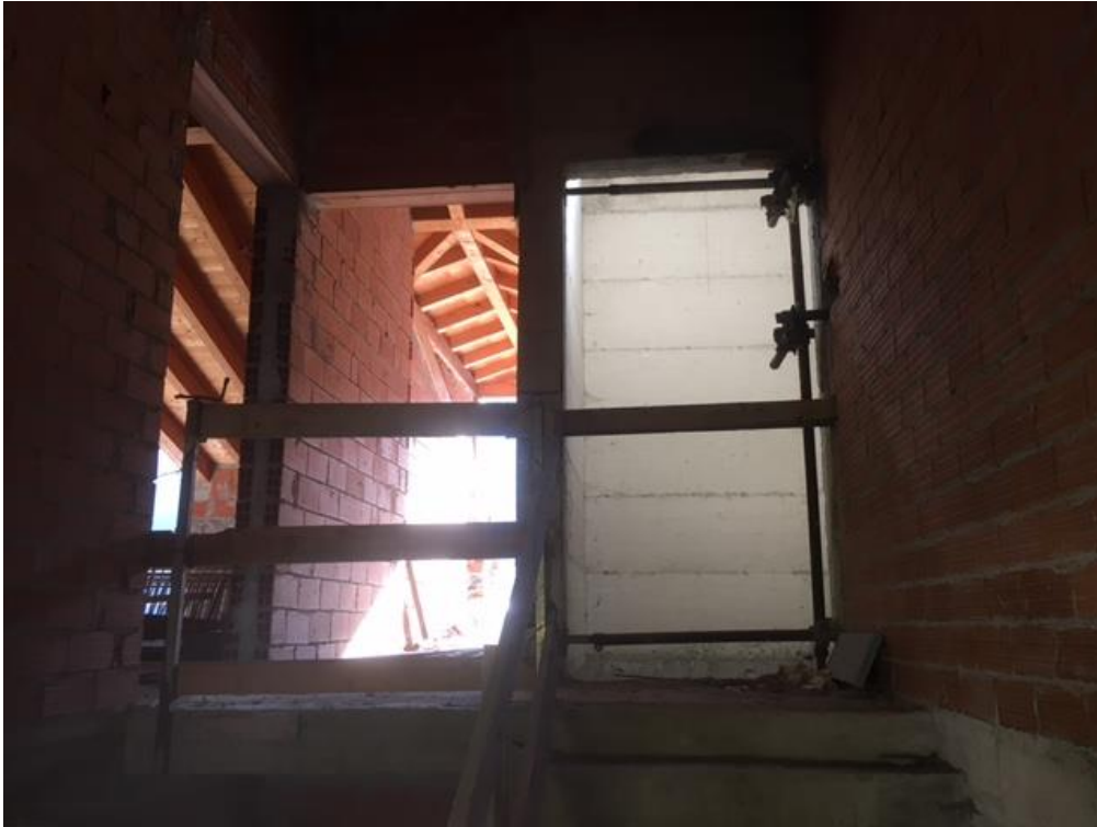
Foto n° 27 – Vista interna struttura arrivo al sottotetto scale in c.a. immobile civ. 20
