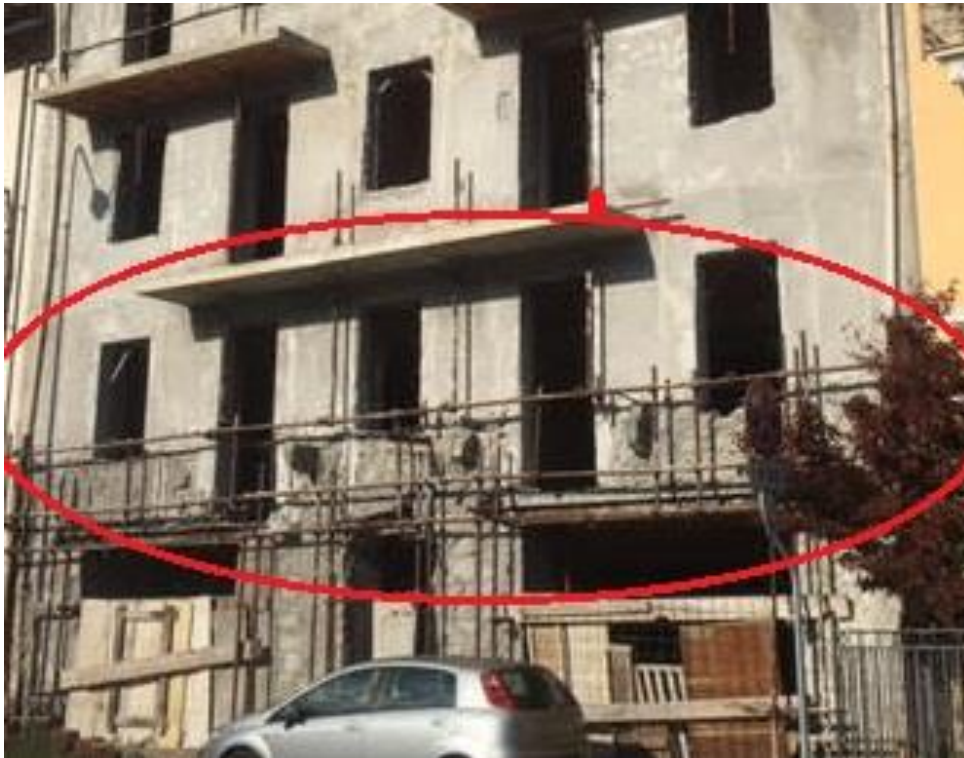
Foto n°9 – Vista esterna PIANO PRIMO del civ. 20 di Via Roma
