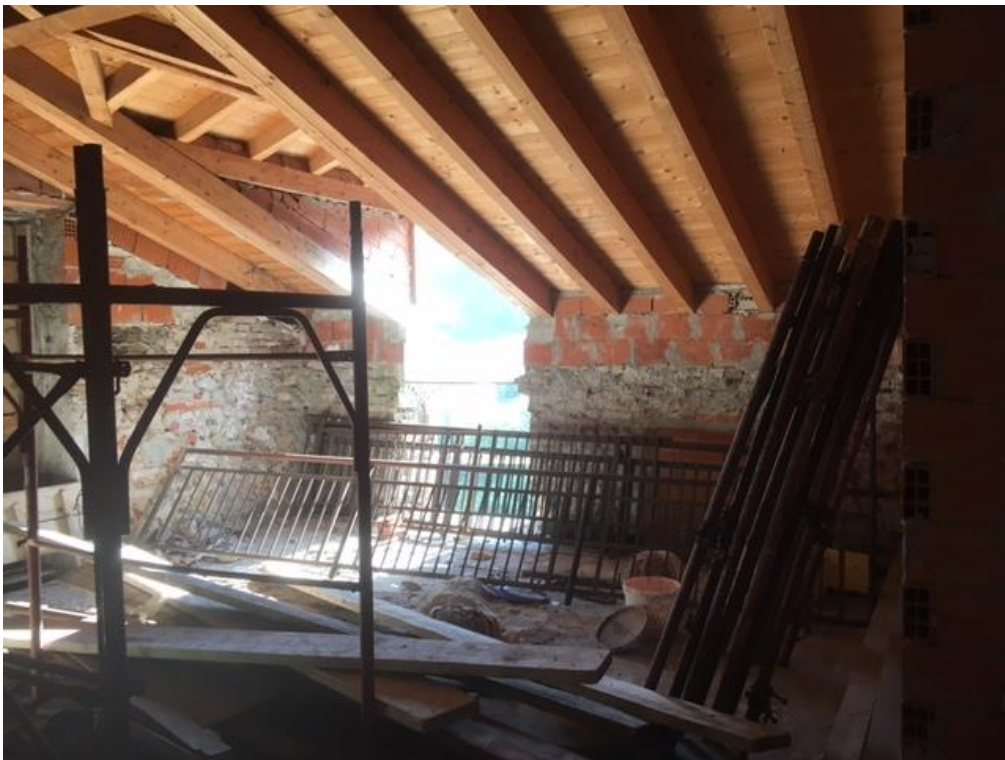
Foto n°24 – Vista interna PIANO 4° SOTTOTETTO del civ. 20 di Via Roma
