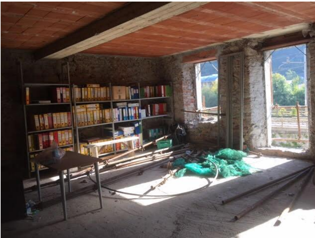
Foto n°12 – Vista interna PIANO PRIMO del civ. 20 di Via Roma
