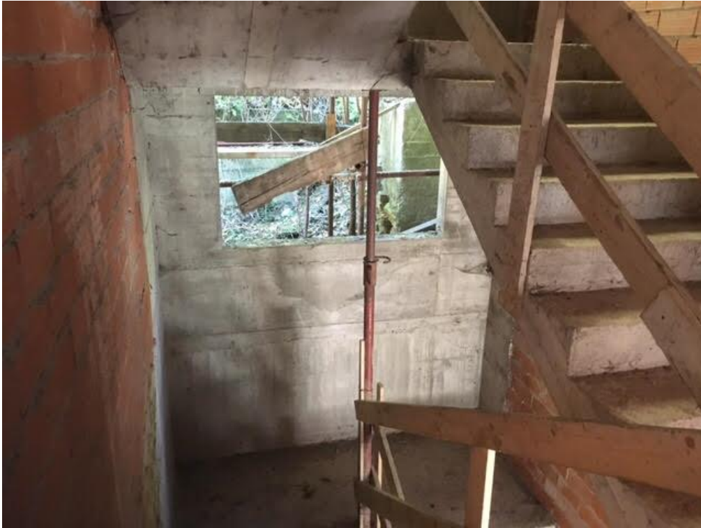
Foto n° 25 – Vista interna struttura scale in c.a. immobile civ. 20 di Via Roma
