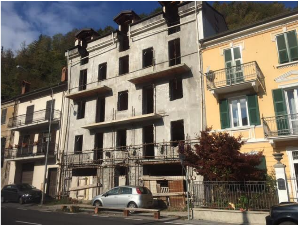
Foto n°1 – Vista esterna immobile civ. 20 di Via Roma in Isola Del Cantone (GE)
