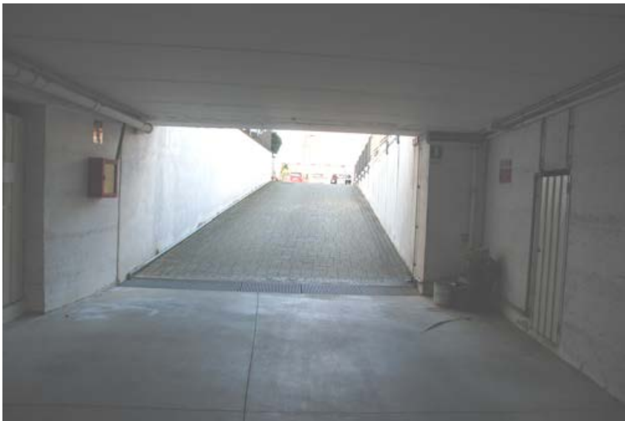
Foto n. 27- Rampa di accesso al piano interrato con i boxes
