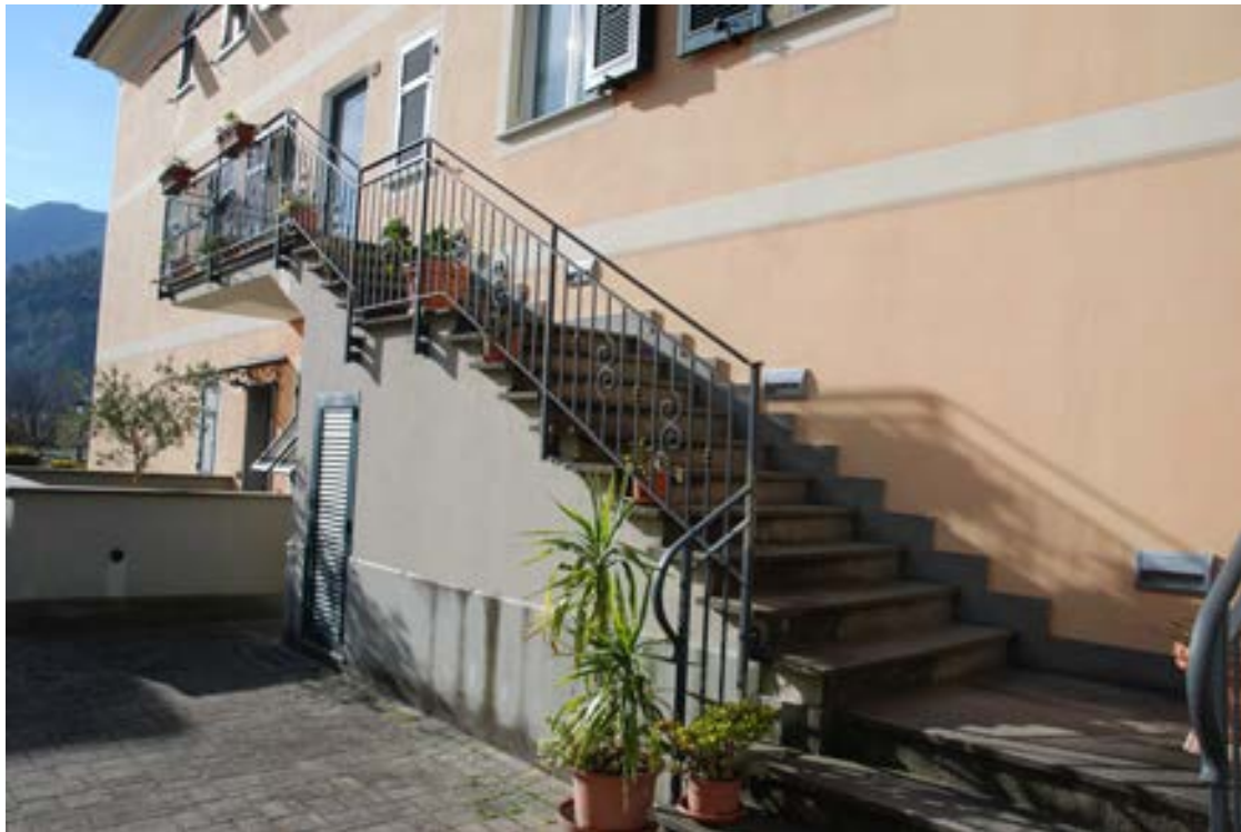
Foto n. 8- Scala esterna comune di accesso al civ. 21 int. 2
