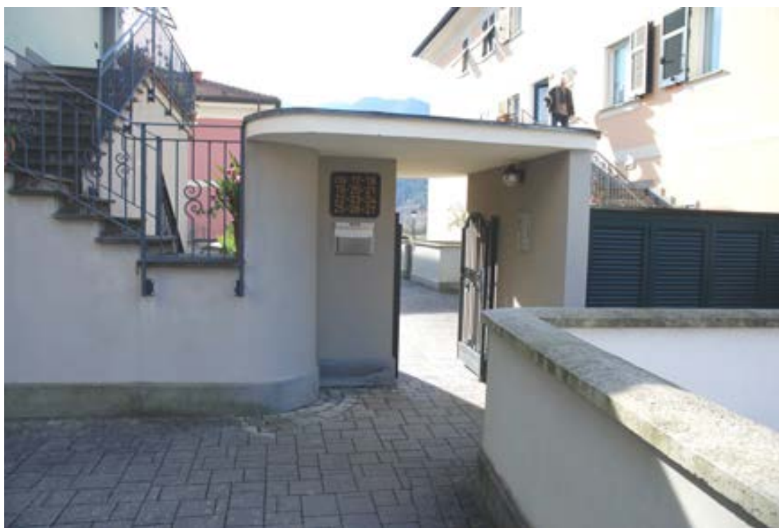
Foto n. 5- Pensilina di accesso pedonale al civico 21
