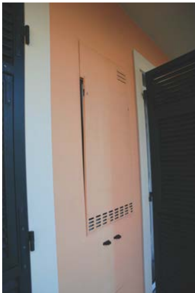
Foto n. 26- Alloggiamento caldaia
