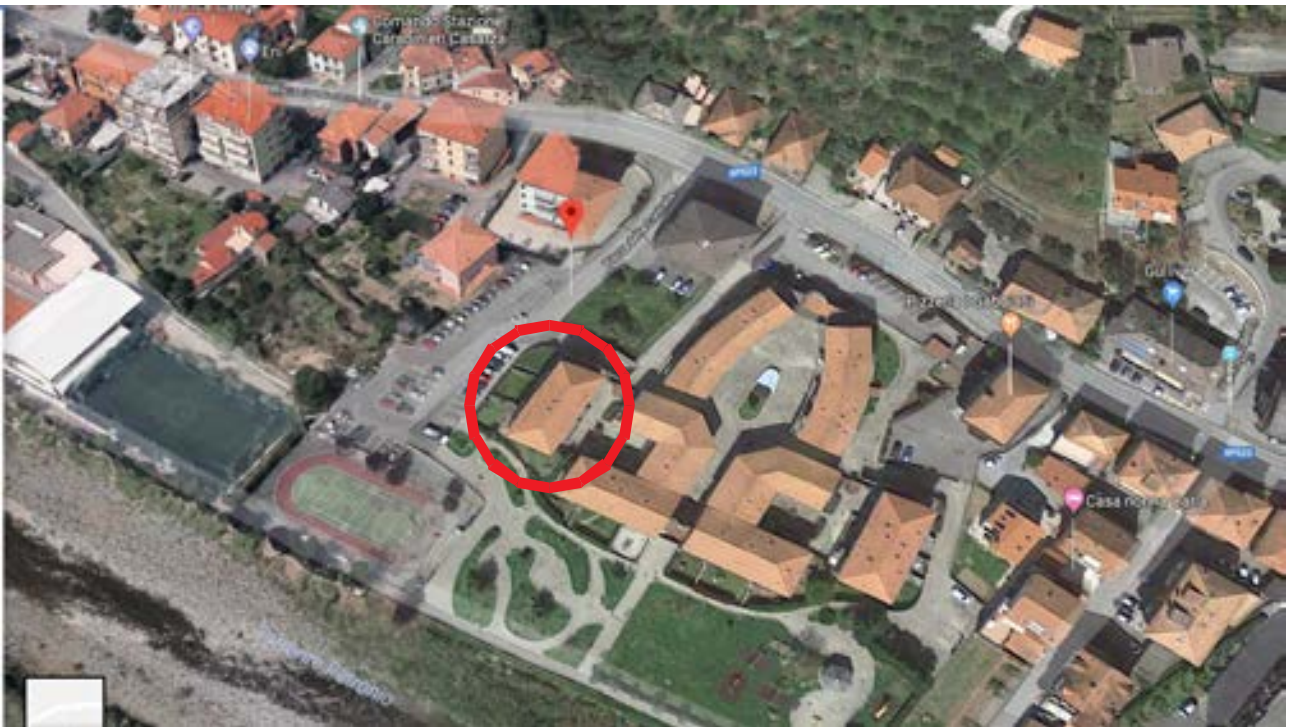
Foto n. 1- In evidenza l'edificio civico n.21 di P.zza della Contrada, Casarza Ligure (Ge).
