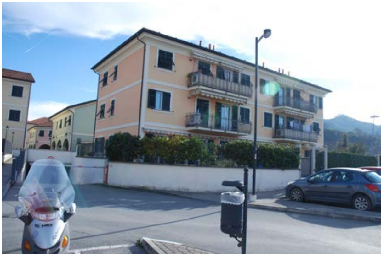
Foto n. 2- Edificio civico n.21 p.zza della Contrada, Casarza Ligure (Ge), ripreso dal piazzale a parcheggio
