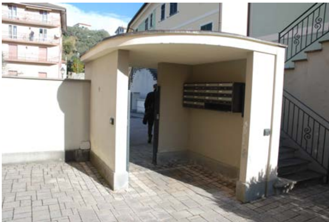
Foto n. 6- Pensilina di accesso pedonale al civico 21 ripresa dall'interno
