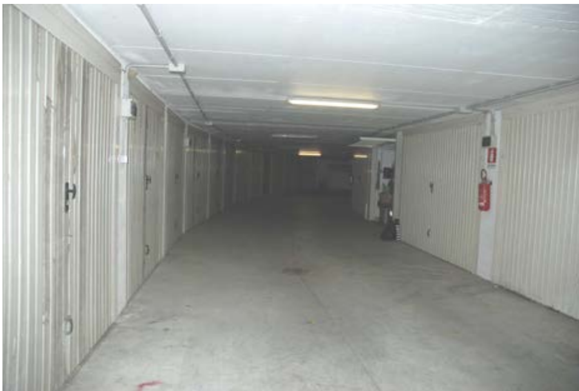
Foto n. 28- Corsia di manovra boxes
