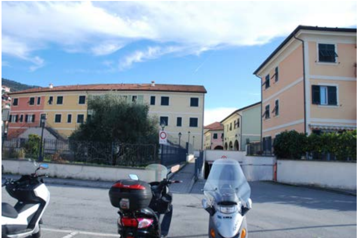
Foto n. 3- A destra civico n.21 p.zza della Contrada, Casarza Ligure (Ge), ripreso dall piazzale a parcheggio. Visibili alcuni edifici che costituiscono il complesso edilizio.
