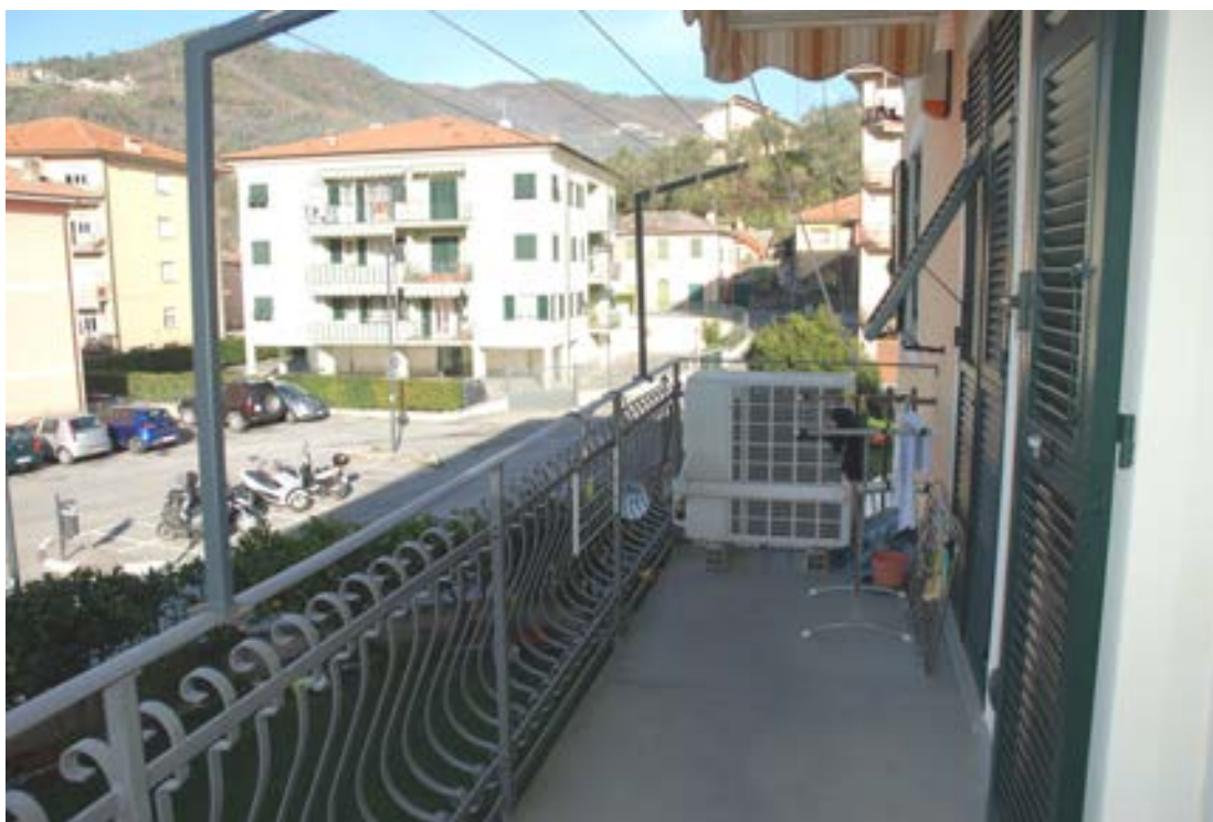
Foto n. 25- Balcone su cui affaccia il soggiorno ed una cameretta. Sono inoltre ivi alloggiati l'unità esterna della climatizzazione canalizzata e la caldaia ( nicchia parete perimetrale)
