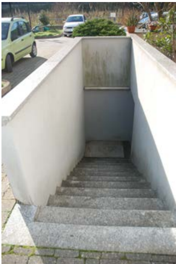
Foto n. 26- Scala di accesso al piano interrato con i boxes
