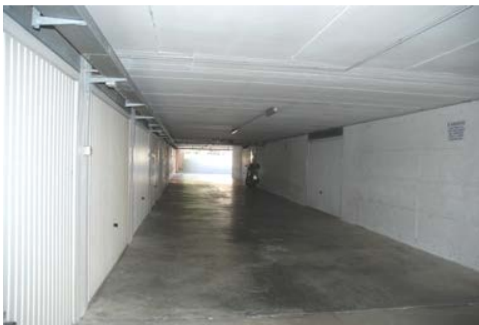
Foto n. 27- Corsia di manovra boxes
